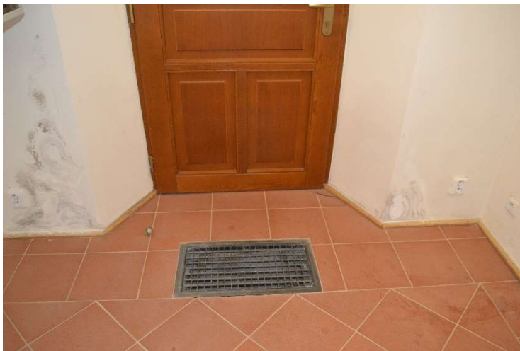
Obrázek 70: Nasávací otvor provětrávané podlahy
