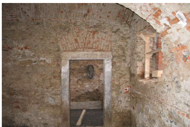
Obrázek 25: Kamenné ostění během rekonstrukce
