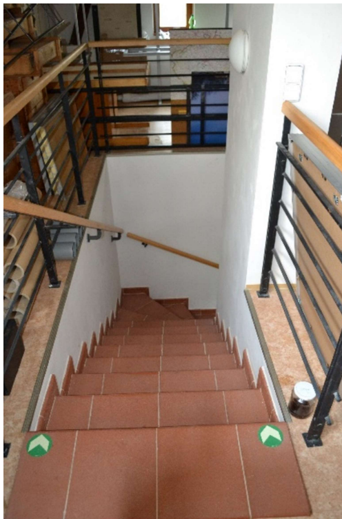
Obrázek 44: Vnitřní deskové schodiště v podkroví
