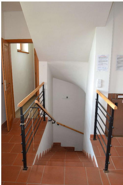
Obrázek 43: Vnitřní deskové schodiště v 2 NP
