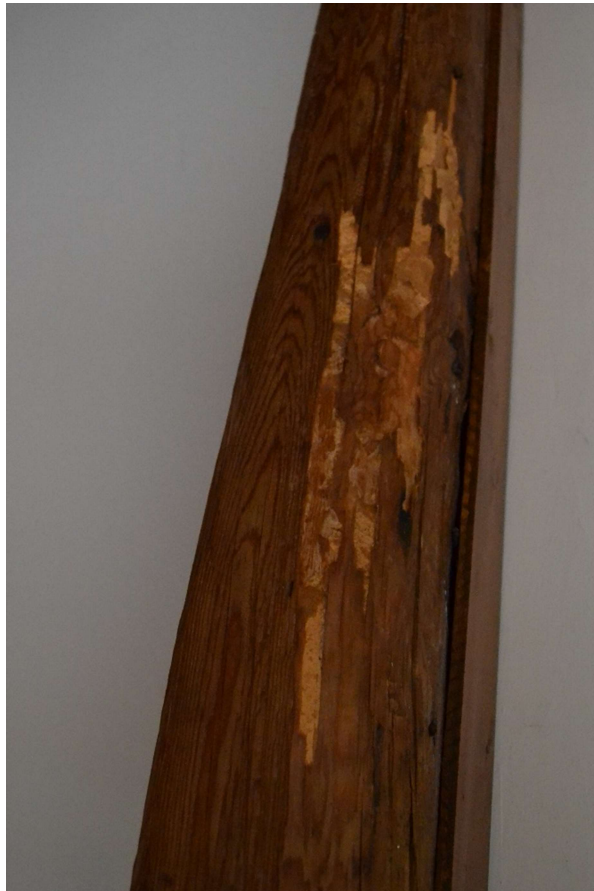
Obrázek 39: Krokev napadené tesaříkem
