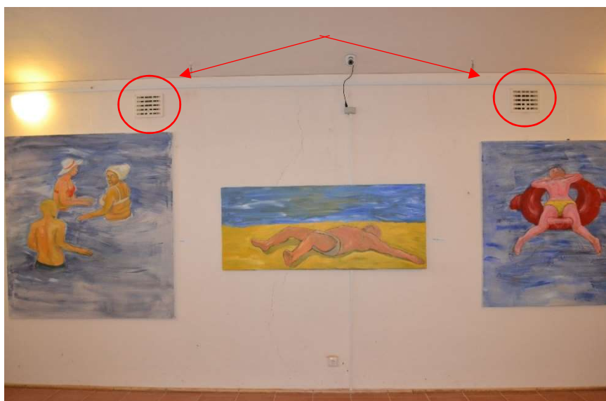
Obrázek 62: Výdechové otvory z provětrávané podlahy
