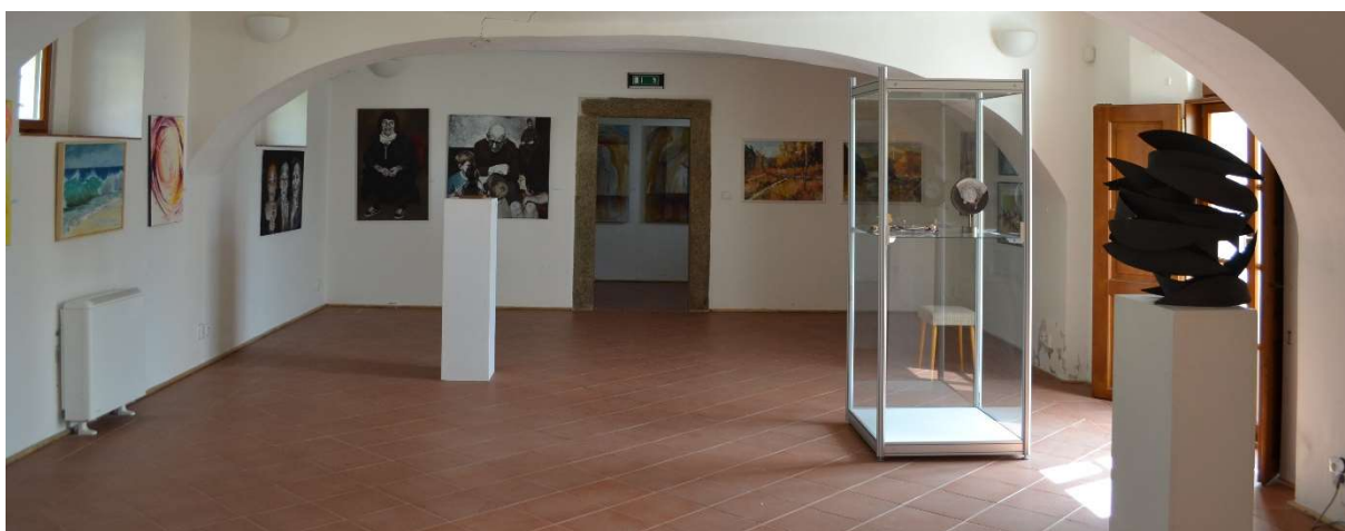
Obrázek 52: Nášlapná vrstva z neglazované dlažby v přízemí
