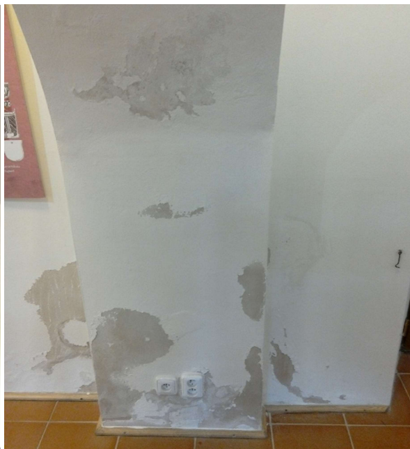
Obrázek 11: Známky vlhkosti v oblasti u podlahy
