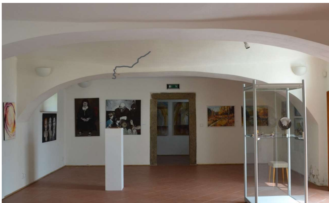
Obrázek 83: Poloha trhliny na klenebním pasu
