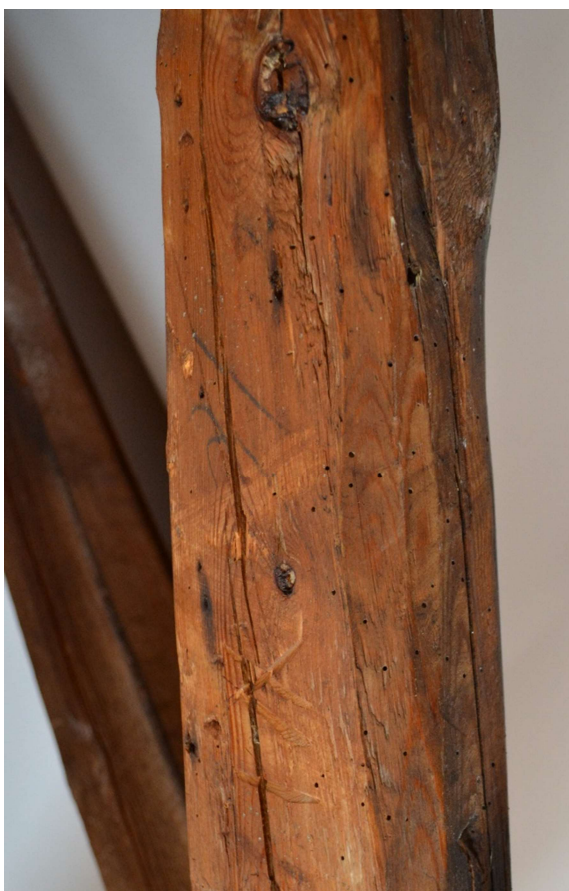
Obrázek 38: Výletové otvory červotoče z pásku
