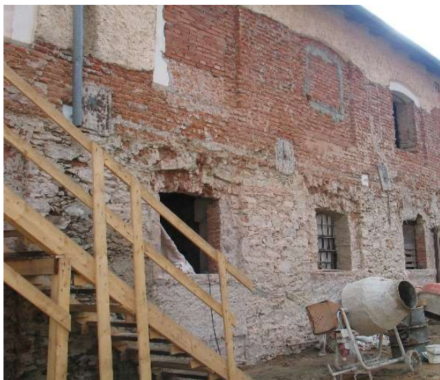
Obrázek 16: Pohled na odhalenou severní fasádu
