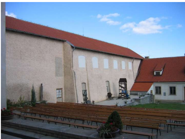
Obrázek 41: Tvar střechy před rozšířením;
