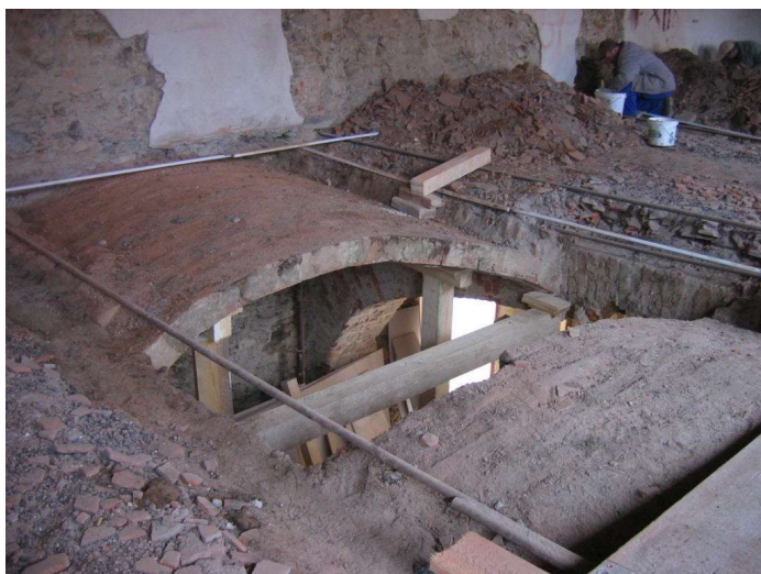
Obrázek 12: Příprava příčných a podélných táhel
