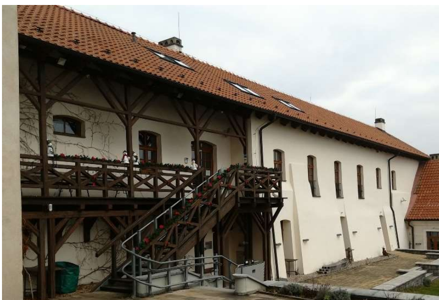
Obrázek 4: Pohled na jižní stranu objektu
