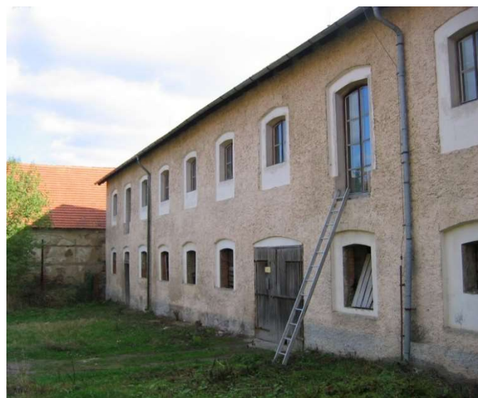
Obrázek 10: Severní fasáda po rekonstrukci 1990-1992
