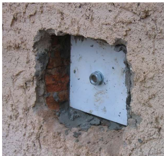
Obrázek 13: Kotevní deska ocelového táhla
