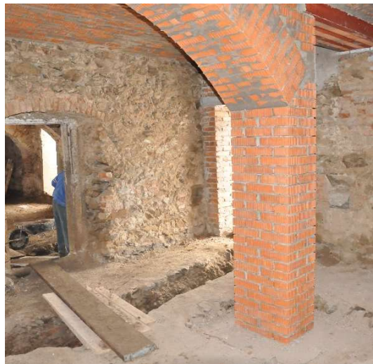
Obrázek 19: Nově vyzděný pilíř
