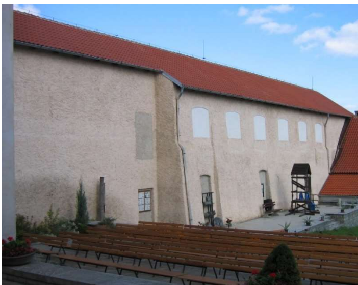
Obrázek 11: Jižní fasáda konírny po rekonstrukci v letech 1990-1992
