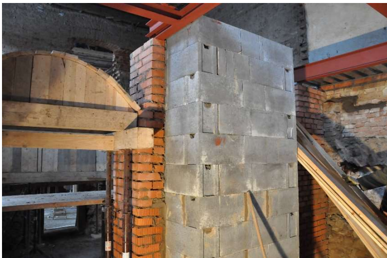
Obrázek 18: Průběh zdění výtahové šachty
