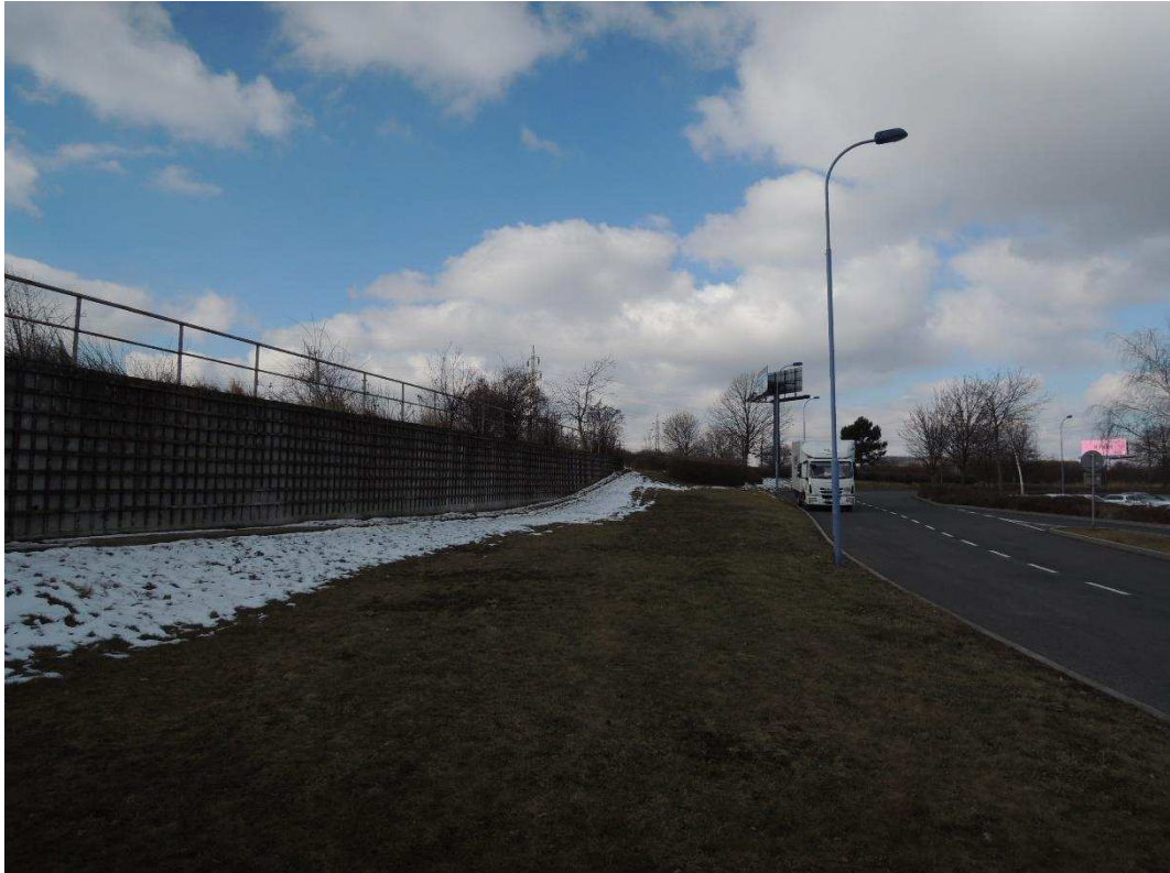
Fotografie 21 pohled proti směru staničení na plánované umístění portálu tunelu TT-Jih, vpravo příjezdová komunikace ke skladišti Tesco a parkovišti
