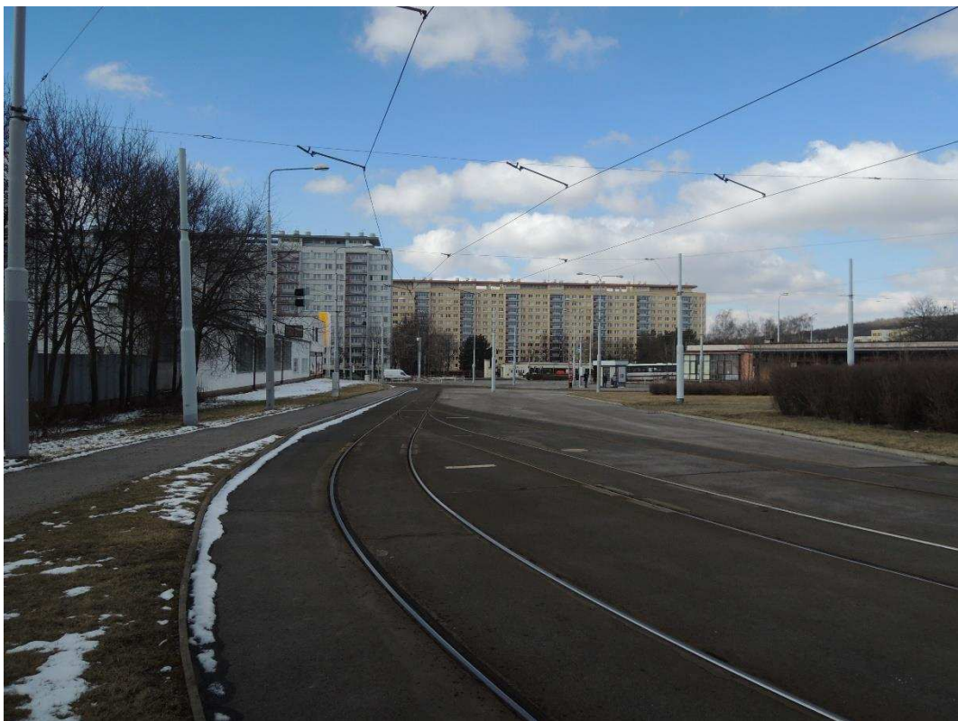
Fotografie 2 pohled na vnější kolej tramvajového obratiště v místě napojení nové tramvajové tratě
