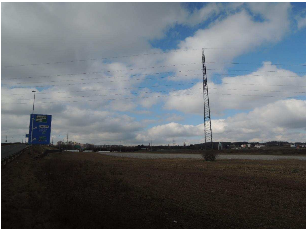
Fotografie 50 pohled nezastavěným územím jihozápadním směrem proti směru staničení, TT-Sever vede v souběhu s ulicí a kříží vedení VN
