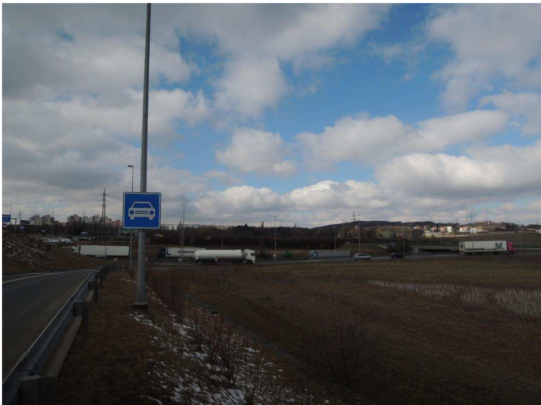
Fotografie 52 pohled proti směru staničení na mimoúrovňové křížení pozemních komunikací, TT-Sever zde stoupá po rampě mostního objektu
