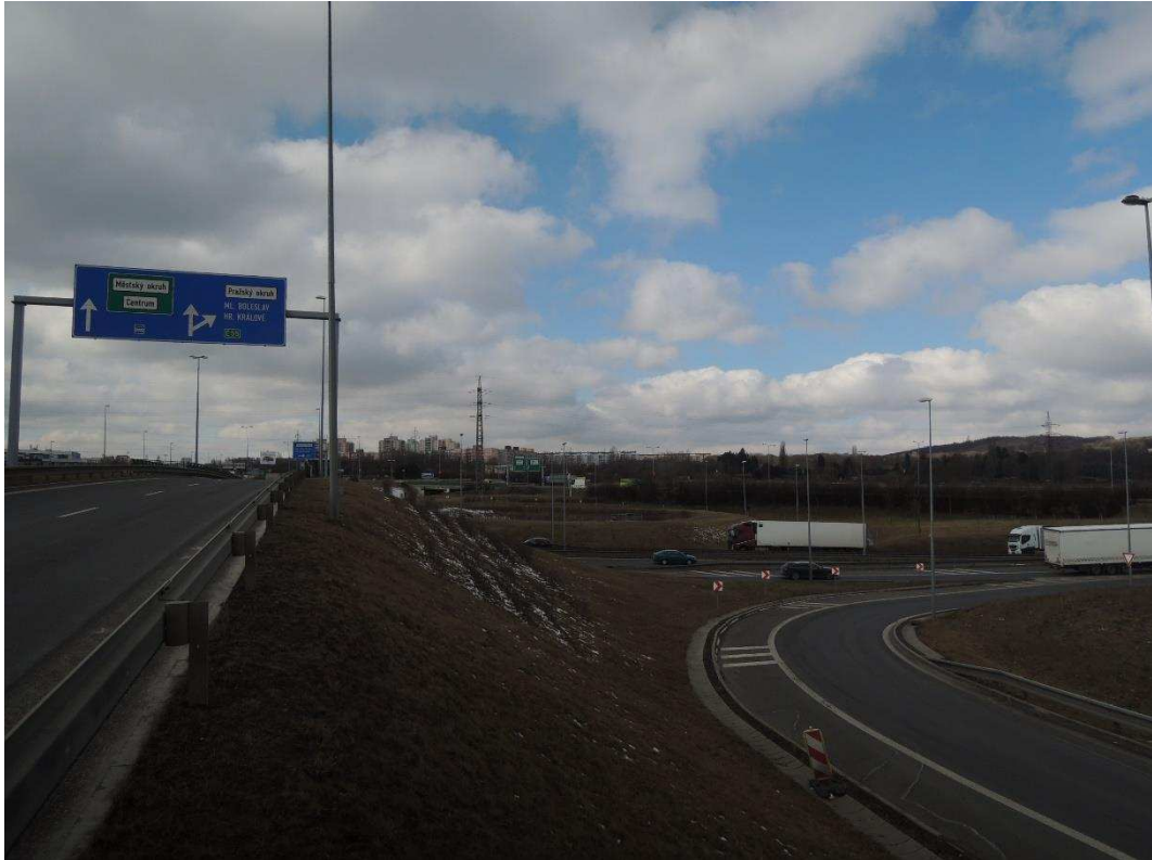
Fotografie 55 pohled proti směru staničení na mimoúrovňové křížení pozemních komunikací Veselská-Kbelská-Cínovecká, které TT-Sever mimoúrovňově kříží pomocí mostního objektu, patrných je několik výškových úrovní
