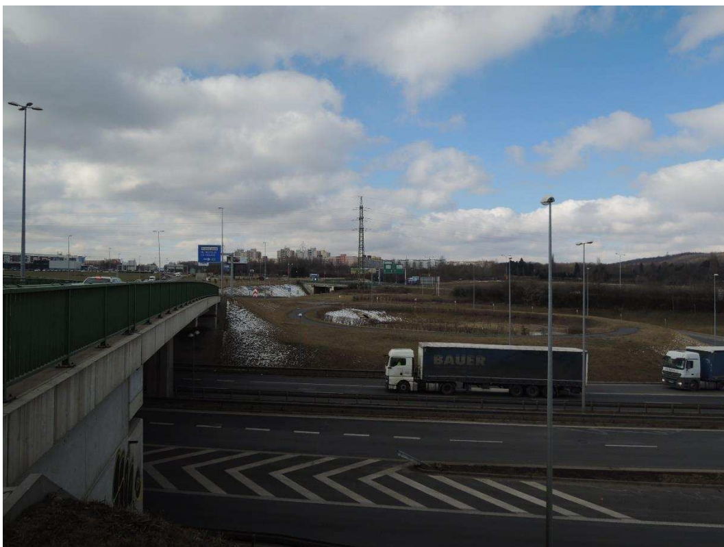
Fotografie 58 pohled směrem Ďáblice na mimoúrovňové křížení pozemních komunikací Veselská-Kbelská-Cínovecká, TT-Sever zde vede po mostním objektu
