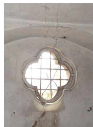
Obr. 34: Okno v sakristii
