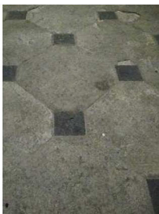
Obr. 22: Podlaha presbytáře a střední části hlavní lodi
