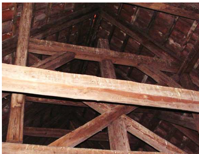
Obr. 31: Vazba nad kupolí hlavní lodi - věšadlo
