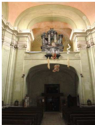
Obr. 12: Pohled na klenby vstupu a nad kruchtou
