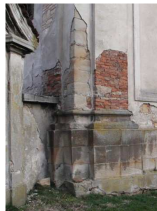
Obr. 11: Detail nároží a soklu budovy
