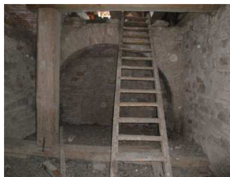
Obr. 21: Žebříkové schodiště mezipatra podkroví
