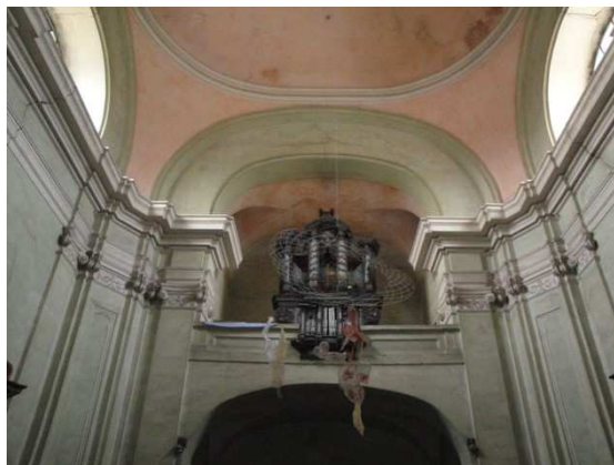
Obr. 40: Pohled na interiérovou úpravu povrchů
