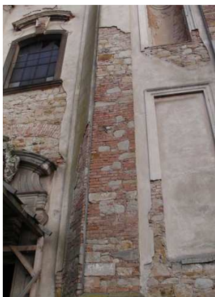
Obr. 10: Detail skladby zdiva u vstupu
