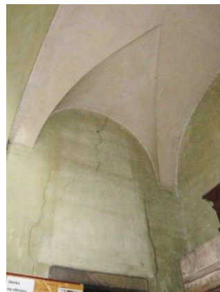
Obr. 13: Luneta nad dveřmi ke schodišti
