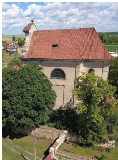
Obr. 7: Pohled na jižní stranu [7]
