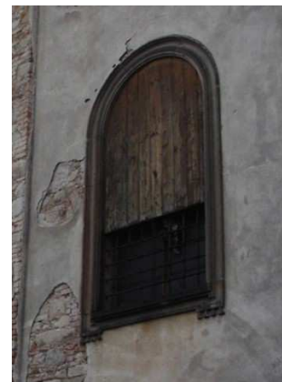
Obr. 37: Spodní okno kaple
