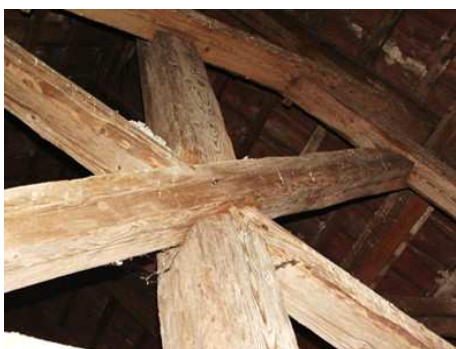
Obr. 29: Přeplátování ondřejského kříže a věšadla
