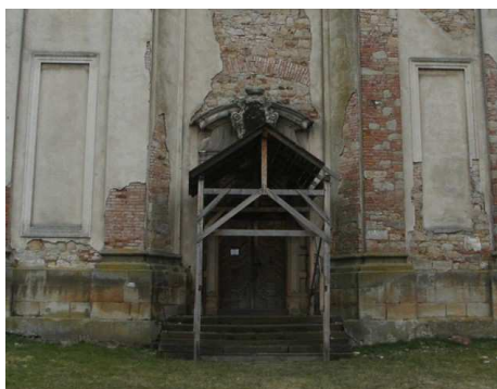
Obr. 18: Schodiště v západním průčelí
