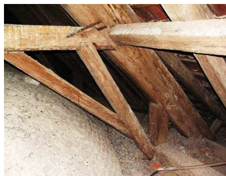
Obr. 28: Ukázka prvků opřených do vnitřní pozednice
