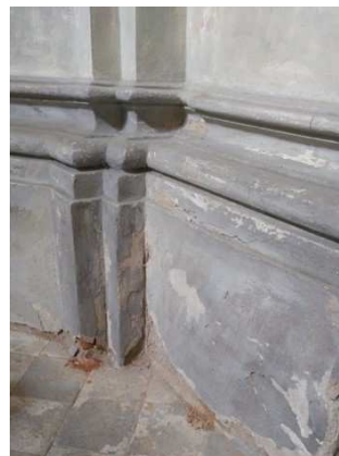
Obr. 41: Sokl interiéru stavby
