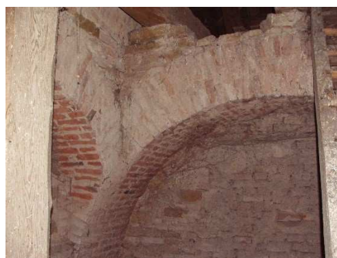
Obr. 17: Valené klenby v mezipatře podkroví
