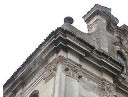
Obr. 55: Pohled na okraj střechy bez okapů
