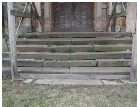
Obr. 19: Detail schodiště v západním průčelí
