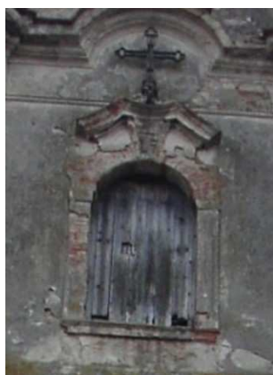
Obr. 33: Okno do podkroví
