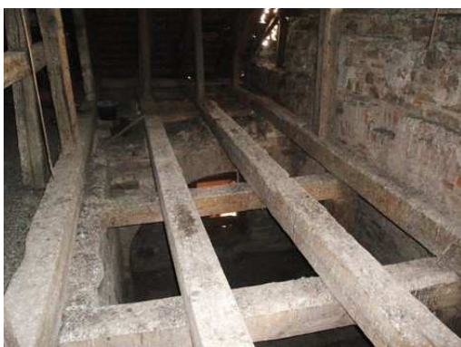
Obr. 25: Podepření vazných trámů
