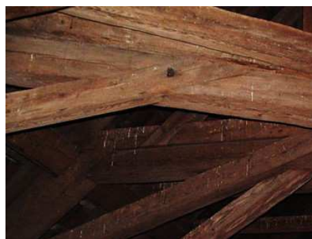
Obr. 30: Zajištění přeplátování dubovým kolíkem
