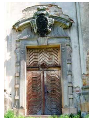
Obr. 39: Pohled na vstupní dveře [11]
