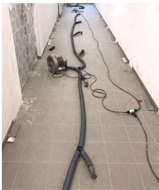
Obr. 95 - Technologie vrtáním – tlakové turbíny [4]
