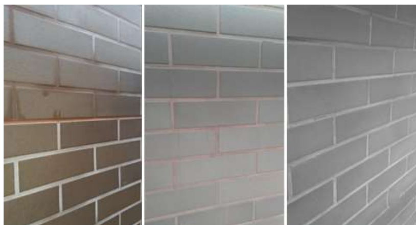
Obr. 37 - Různobarevnost spár [4]
