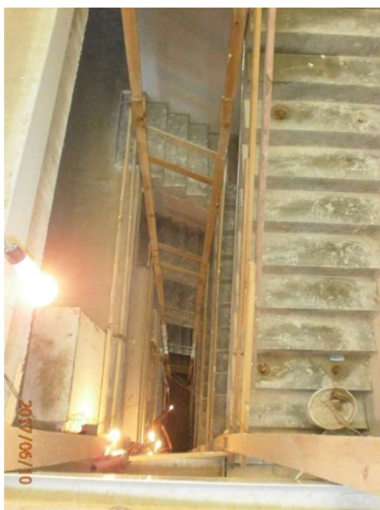
Obr. 87 - Zabezpečené komunikační jádro kolem schodiště [4]
