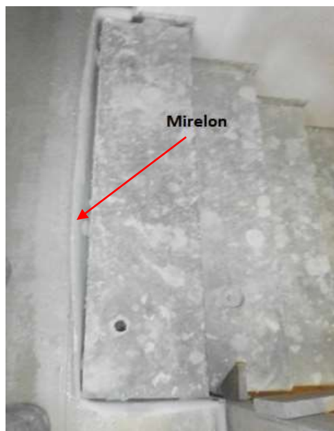
Obr. 76 - Po zalití podlahy [4]
