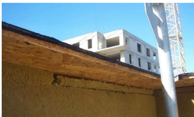
Obr. 71 - Detail přesahu bednění [4]
