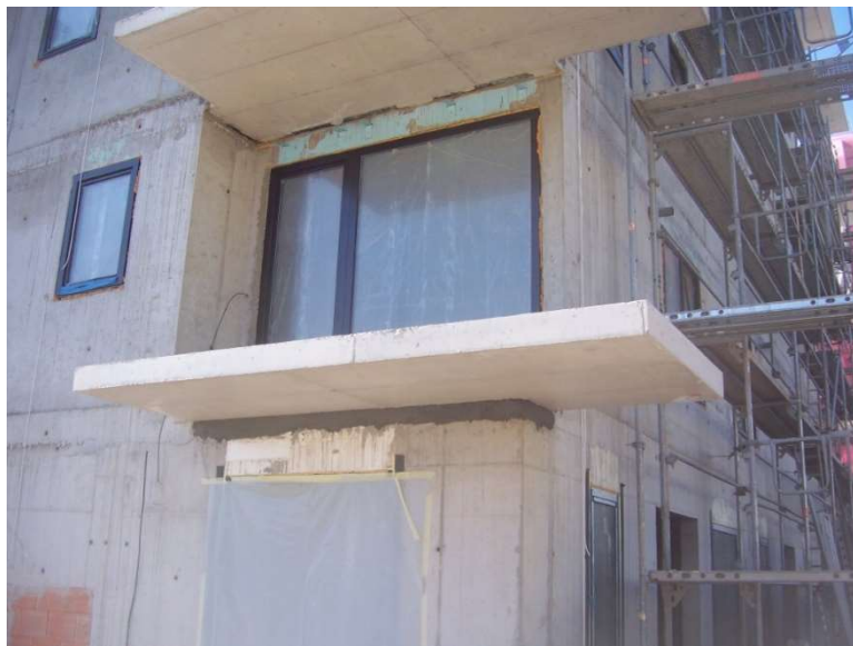
Obr. 15 - Deska balkon ve 2.NP objektu "C" po odbednění [4]
