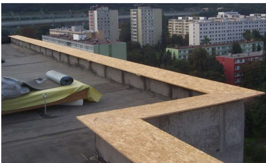
Obr. 72 - Bednění pod oplechování [4]
