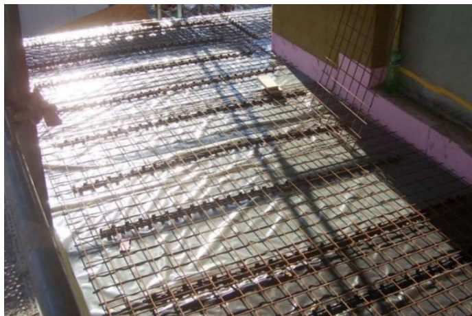
Obr. 58 - Armování podlahy balkonu před betonáží [4]
