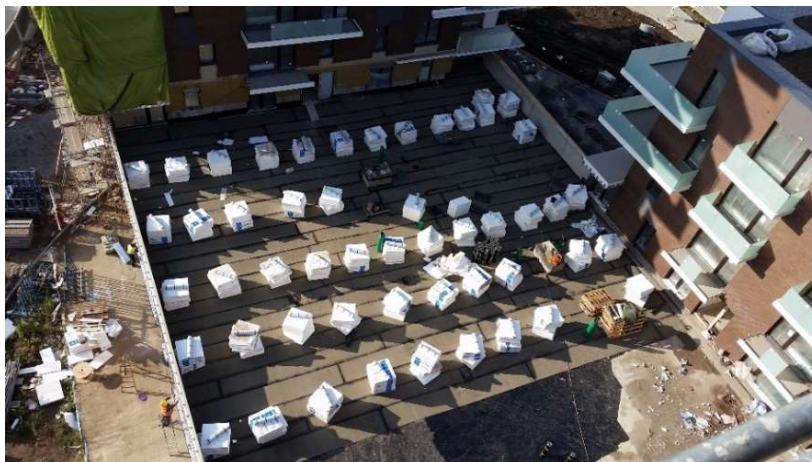
Obr. 27 - Terasa v průběh natavování parozábrany [4]
