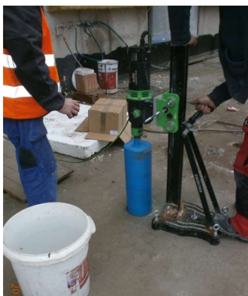
Obr. 24 - Jádrový vrták v provozu [4]
