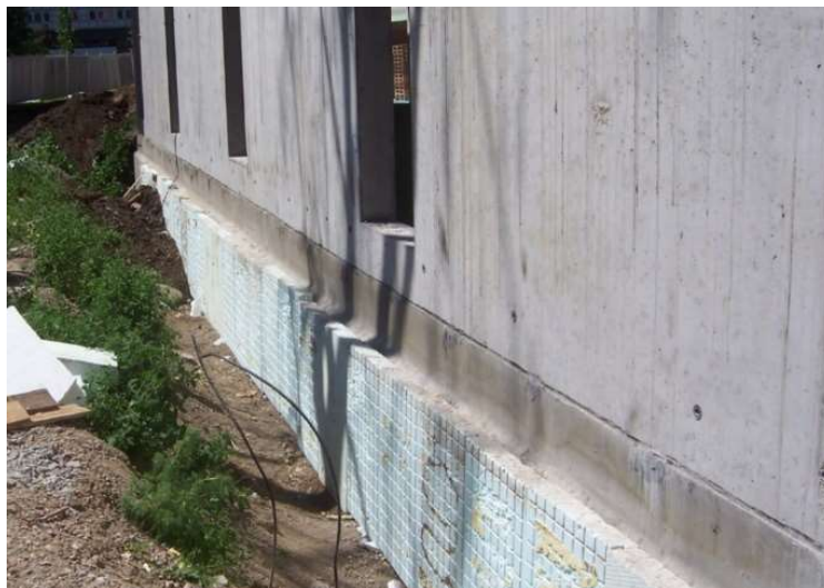
Obr. 52 - Správné provedení soklu [4]
