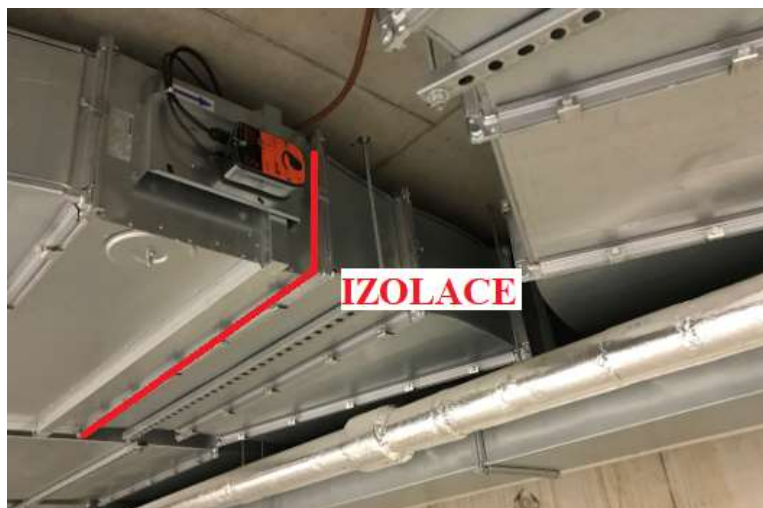
Obr. 80 - Pohled na požární úsek VZT [4]
