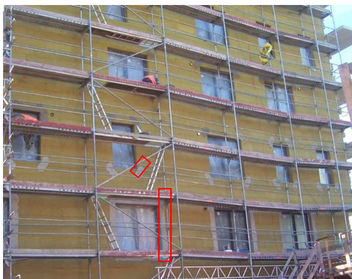
Obr. 35 - Vyztužení fasádních otvorů [4]
