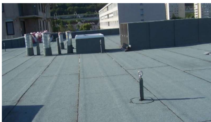
Obr. 64 - Vrstva asfaltových pásů na objektu "A" [4]
