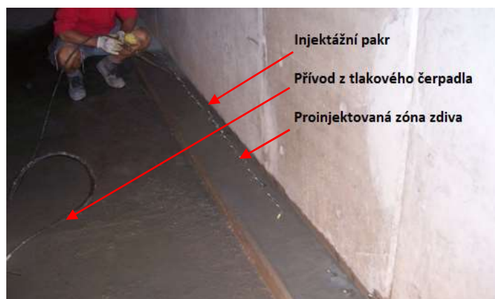
Obr. 74 - Injektáž [4]
