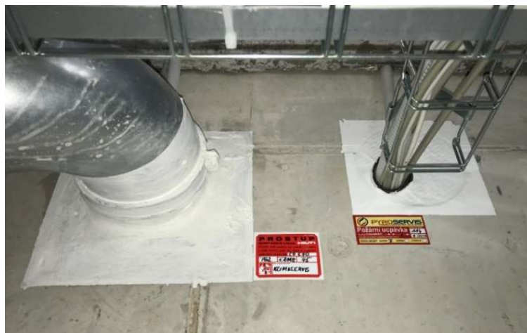
Obr. 79 - Prostupy požární stěnou [4]
