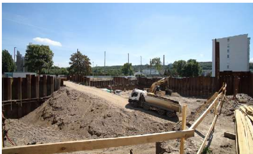
Obr. 7 - Vjezdová rampa do stavební jámy [3]
