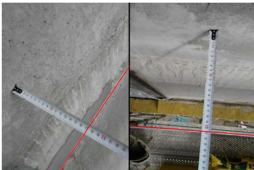
Obr. 31 - Naměřené odchylky na objektu "C" [4]
