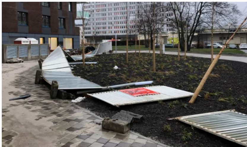
Obr. 47 - Popadaná strana oplocení na severní straně [4]
