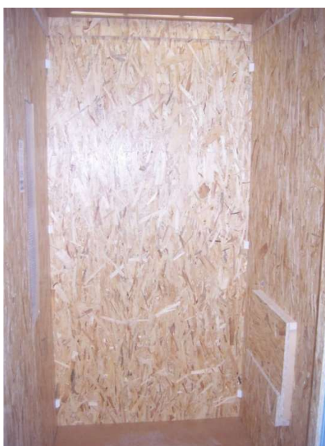
Obr. 81 - Bednění výtahu [4]
