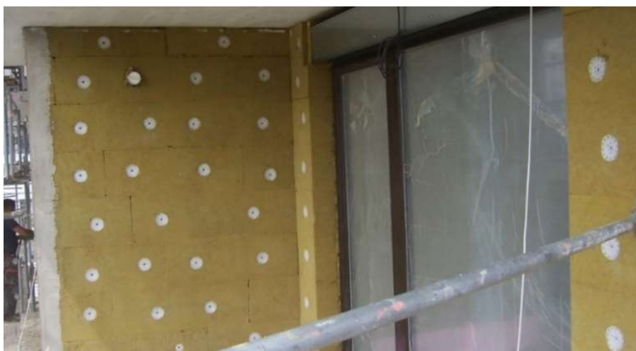
Obr. 33 - Kotvení izolantu v části balkonu [4]
