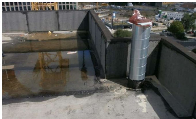
Obr. 70 - Atika s vytaženou parotěsnou vrstvou [4]
