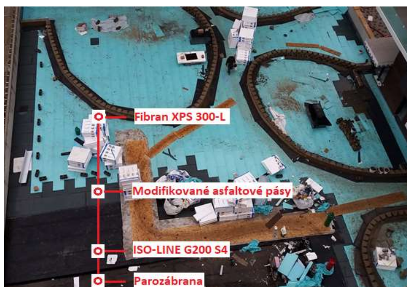
Obr. 28 - Skladba střechy terasy [4]
