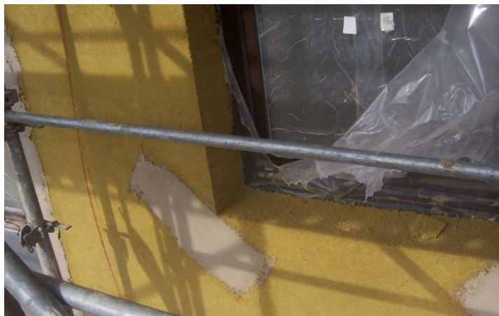
Obr. 34 - Vyztužené rohy otvorů [4]
