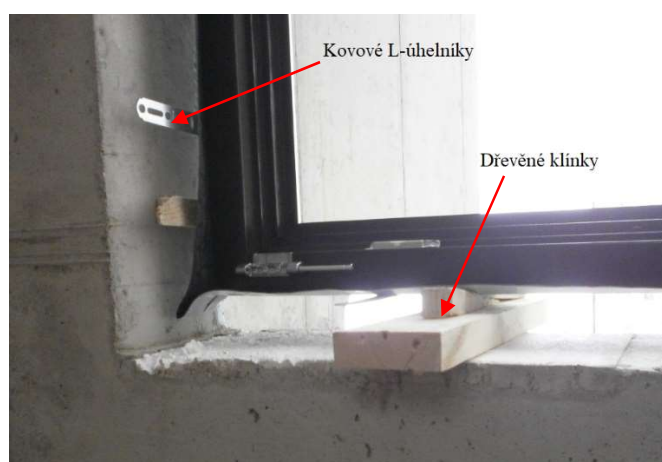
Obr. 60 - Ukotvení rámu okna [4]
