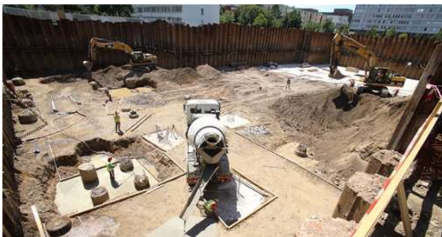
Obr. 6 - Stavební jáma před základovou deskou [3]
