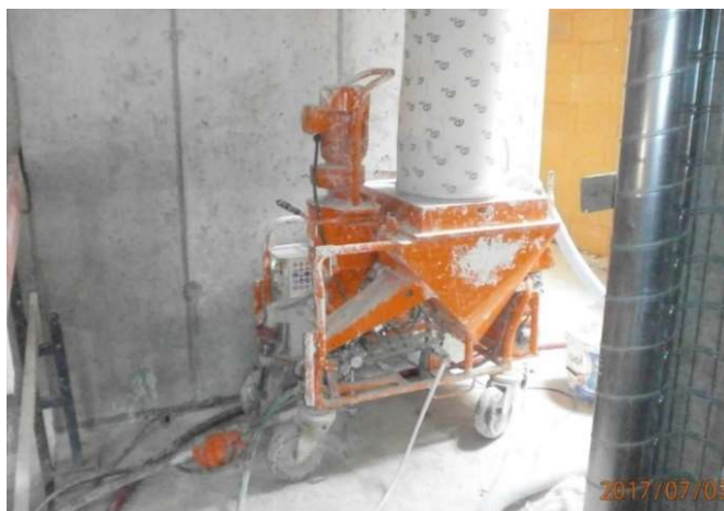
Obr. 22 - Omítací stroj v provozu [4]
