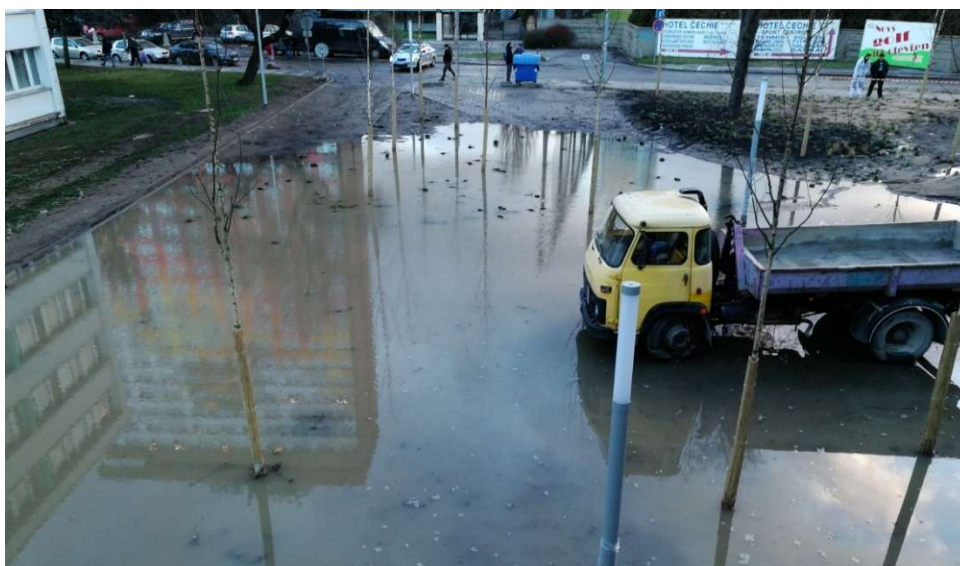
Obr. 90 - Hlavní vjezd na staveniště těsně po havárii [4]
