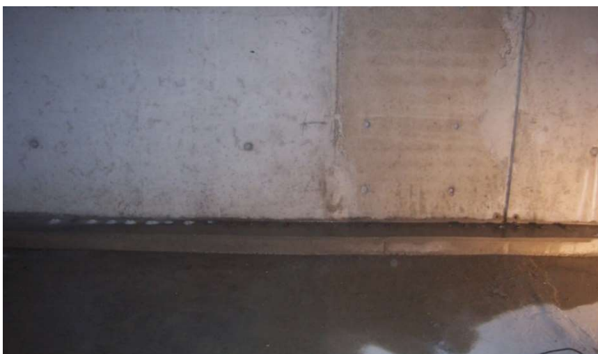
Obr. 73 - Zatýkání do prostor garáží [4]
