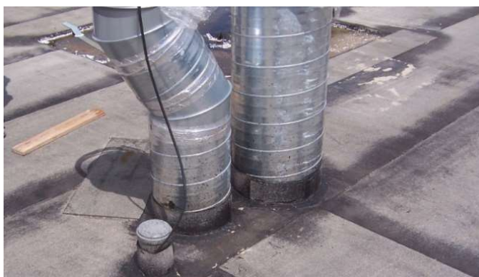
Obr. 65 - Detail u prostupu vzduchotechniky [4]
