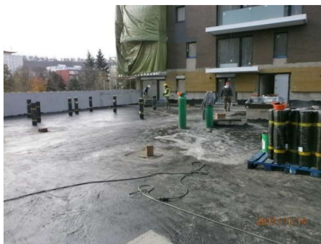
Obr. 26 - Terasa po nanesení penetrace [4]
