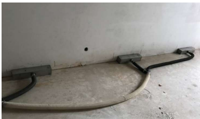
Obr. 94 - Technologie dilatační spárou – přetlakové turbíny [4]
