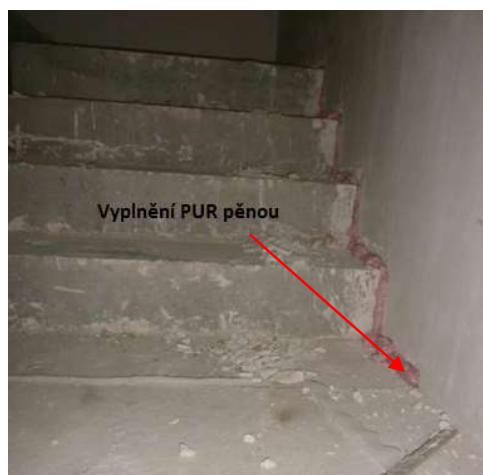
Obr. 75 - Vyplnění mezery PUR pěnou [4]
