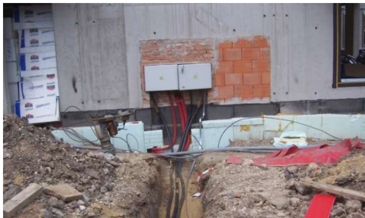
Obr. 54 - Pohled na sokl kolem hlavního rozvodu elektřiny [4]
