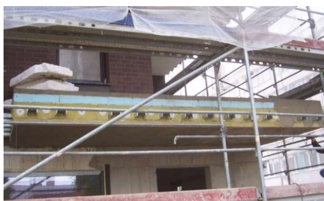
Obr. 56 - Pohled na obalenou balkonovou desku [4]
