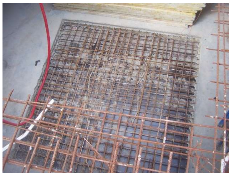
Obr. 50 - Armování otvoru v 1.PP po demontáži jeřábu [4]
