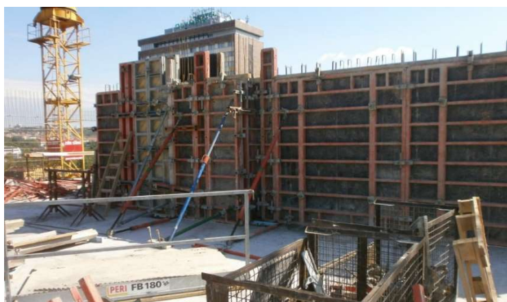
Obr. 10 - Bednění svislých konstrukcí [4]
