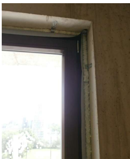
Obr. 61 - Rám vyplněný PUR pěnou [4]
