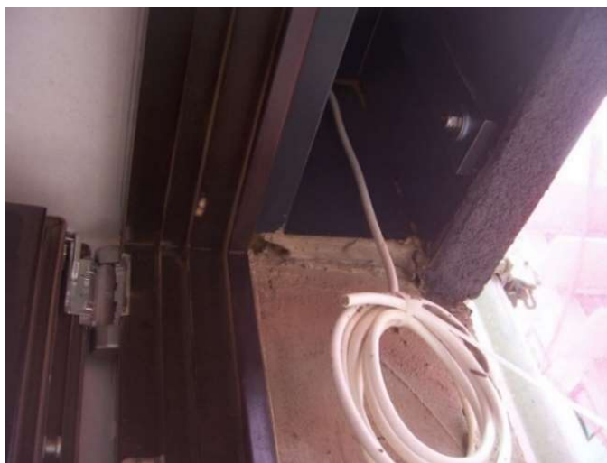
Obr. 21 - Příprava pro venkovní žaluzie v boxu [4]
