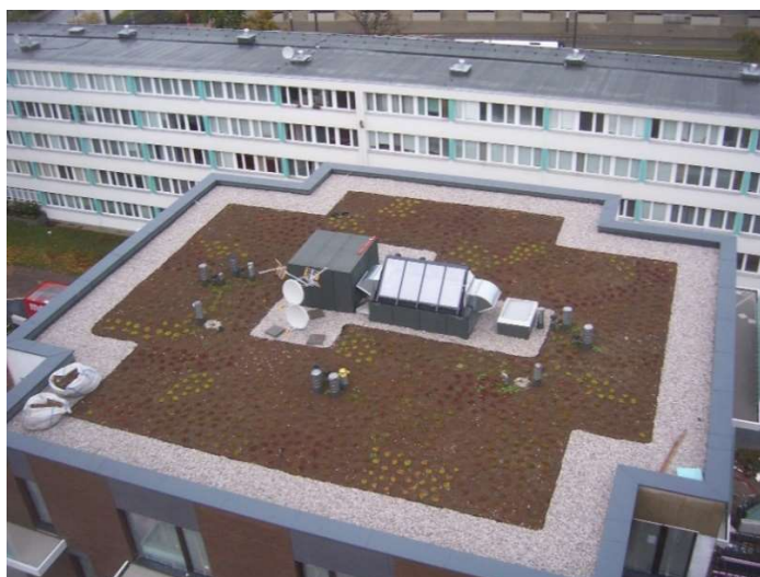
Obr. 18 - Pohled na střechu objektu "A" [4]
