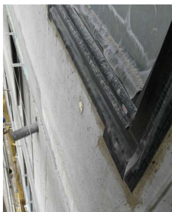
Obr. 62 - Difúzně otevřená páska v exteriéru [4]
