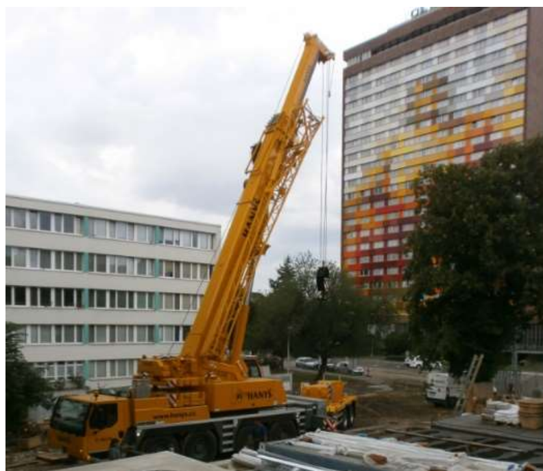
Obr. 51 - Autojeřáb v provozu [4]
