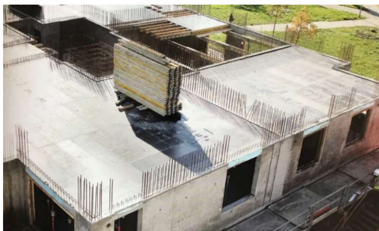
Obr. 9 - Vytažená výztuž [3]
