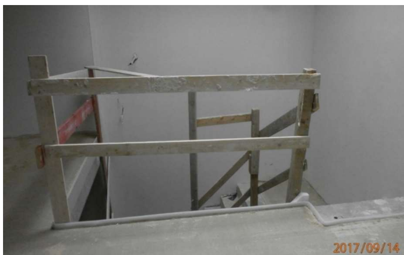
Obr. 86 - Dočasná konstrukce zábradlí [4]
