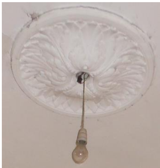
Stávající stav stropní rozety
