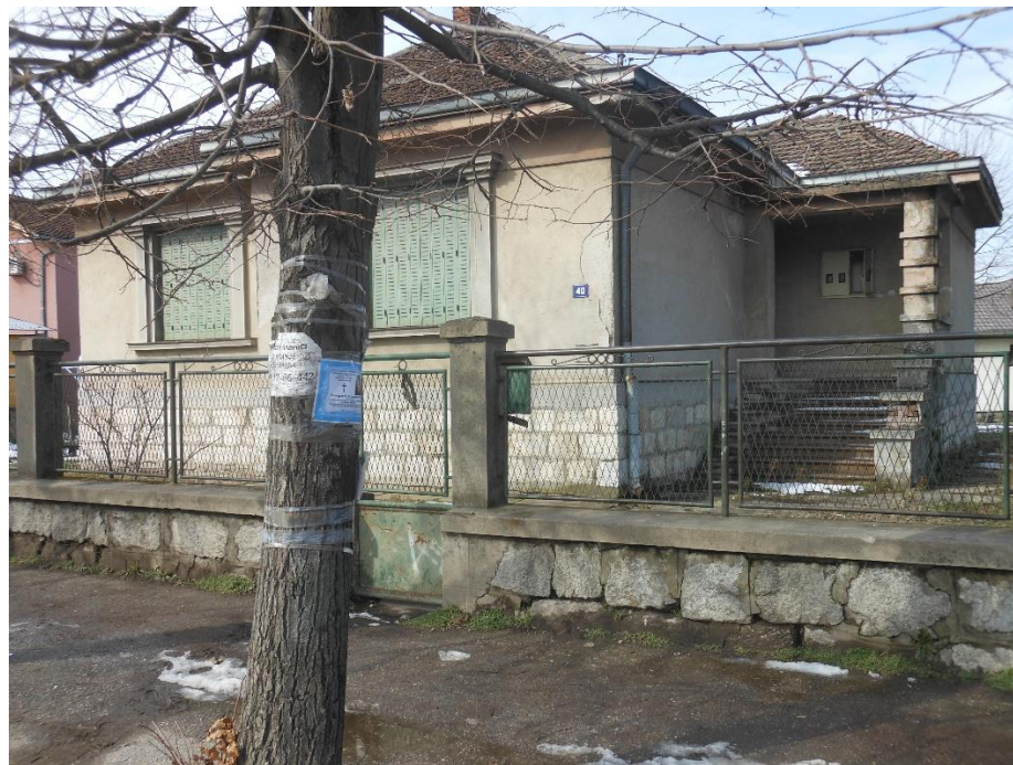
Uliční fasáda objektu A 1
