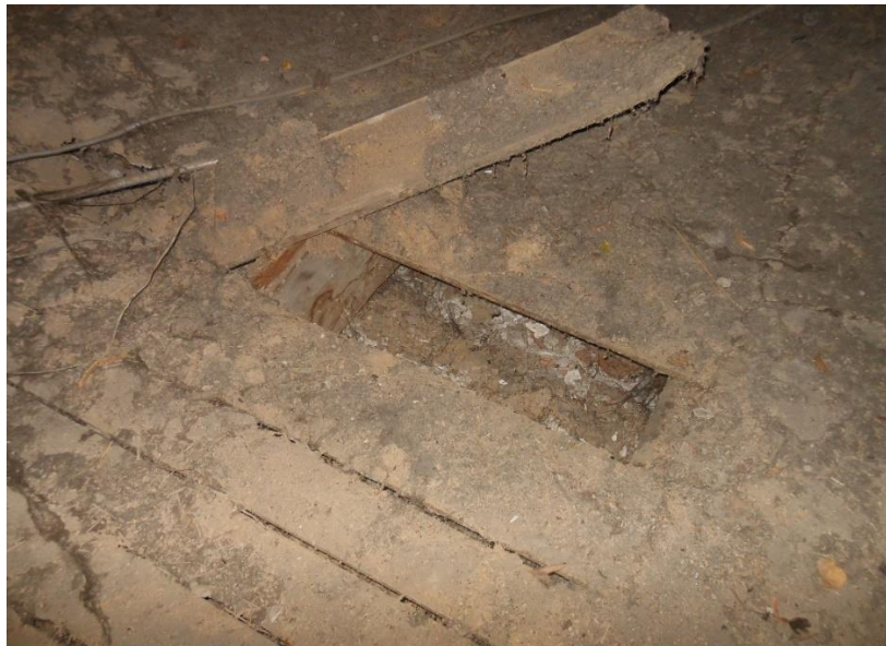
Krov ovlivněný dřevokaznou houbou 1
