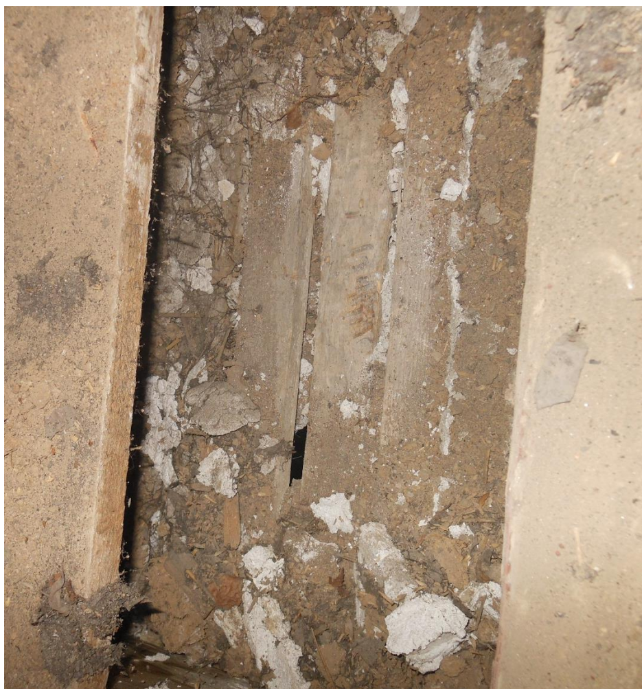
Stav jednotlivých prvků krovu 2
