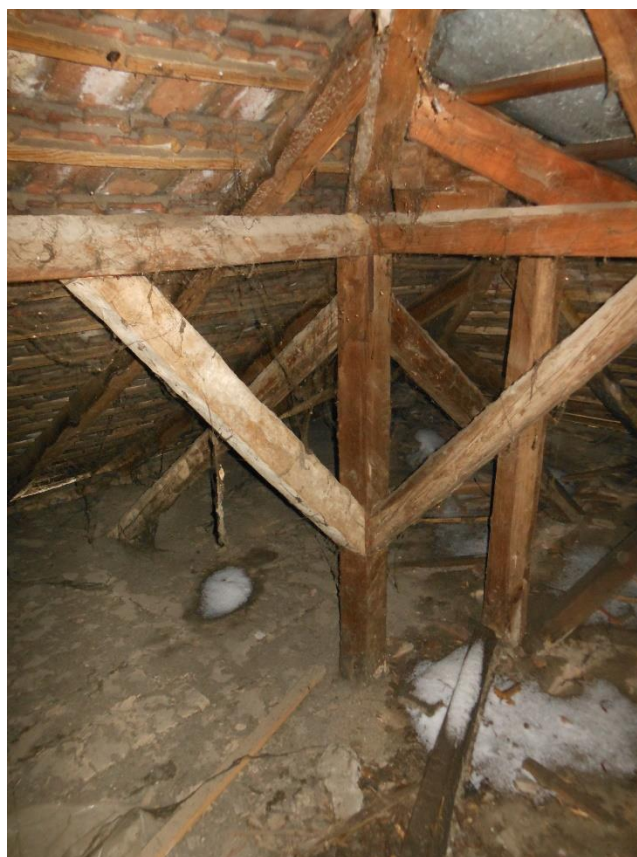
Stav jednotlivých prvků krovu 1
