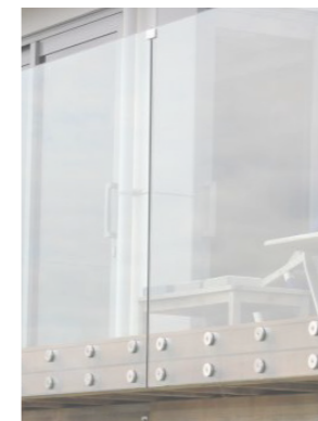
1 SKLENĚNÉ ZÁBRADLÍ
