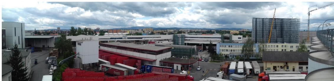
Obrázek 17 - Pohled na rozestavěné logistické centrum Budějovického Budvaru. Zdroj Ing. Pavel Pánek, vedoucí oddělení nákupu a logistiky Budějovického Budvaru
