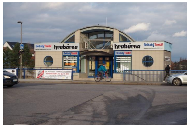
Obr. 28) Komerční objekt na mostu Jana Palacha [25]
