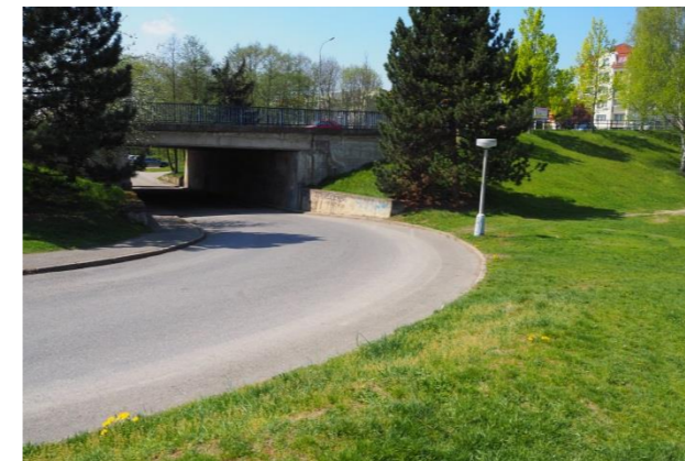
Obr. 58) Podjezd Ellerovy ulice [25]
