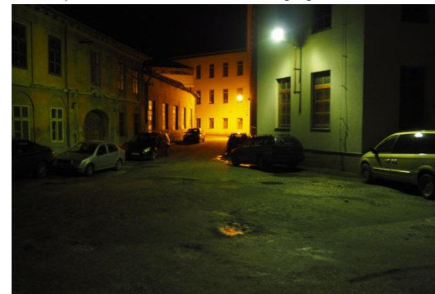
Obr. 48) Nevhovující osvětlení – ulice Na Ostrově [25]
