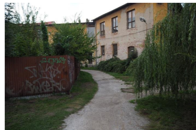
Obr. 95) Cesta přes průmyslový areál – U1 [25]
