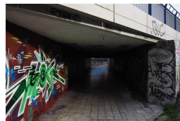
Obr. 88) Podchod pod Katovickou ulicí – D2 [25]
