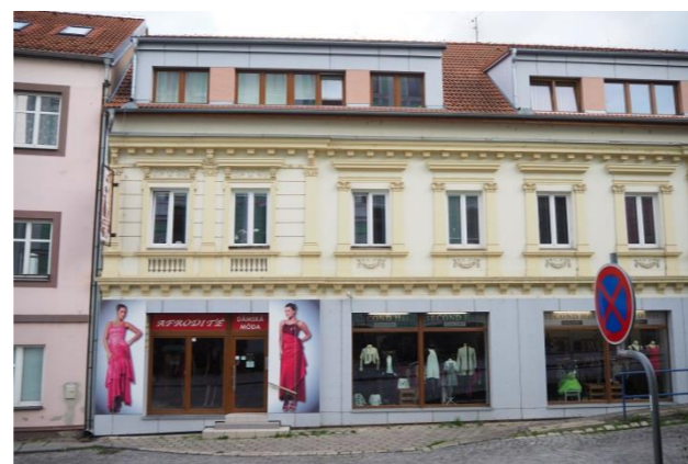
Obr. 61) Úprava parteru pro reklamní účely – R2[25]
