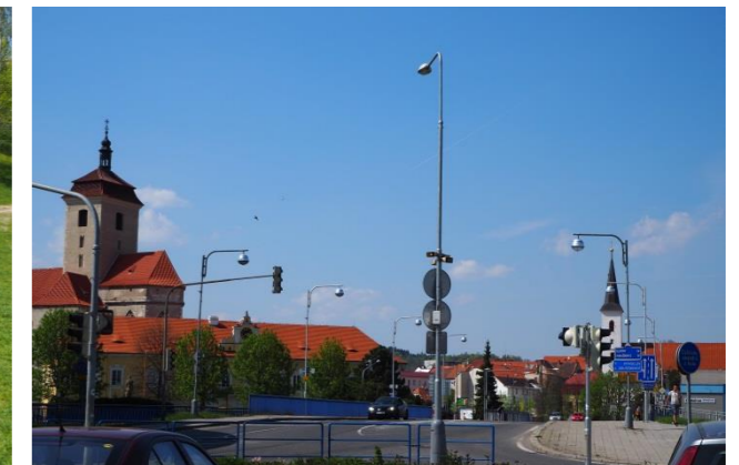
Obr. 54) Městský rozhlas na stožáru veřejného osvětlení [25]
