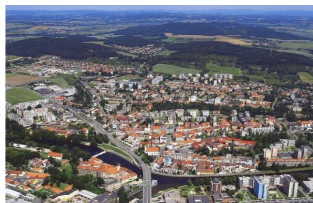
Obr. 86) Letecký snímek na hodnotné historické centrum [25]
