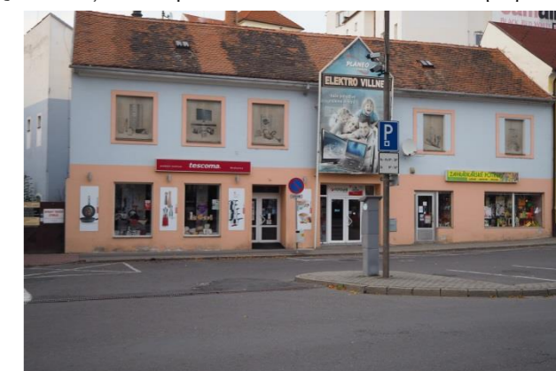
Obr. 65) Maximální využití oken a fasády – ul.Podskalská – R1 [25]
