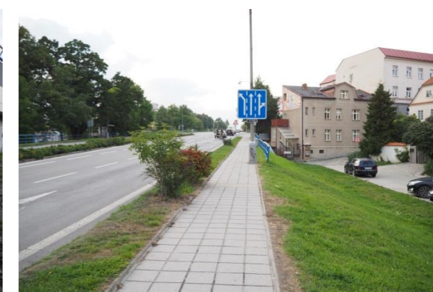
Obr. 89) Veřejný prostor Katovické ulice – D1 [25]
