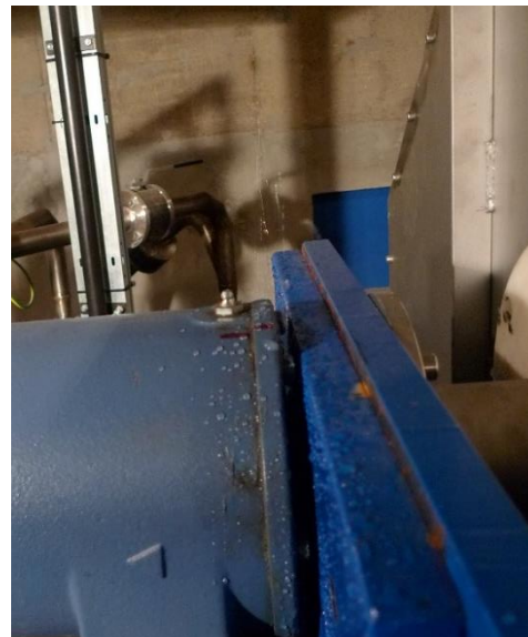
Obr 5.7 Průsaky kolem hřídele 2
