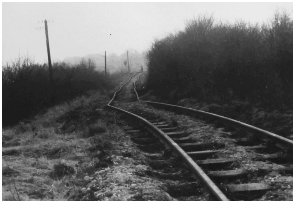
Obr. 3: Deformace na trati (zdroj: Rybář, 1982)
