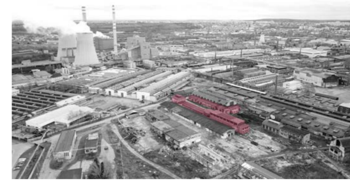
Odstranění a očištění hal
