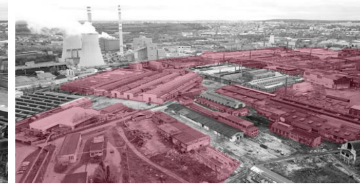
Odstranění chátrajících hal
