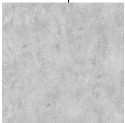
POCHOZÍ POVRCH Z LITÉHO BETONU
