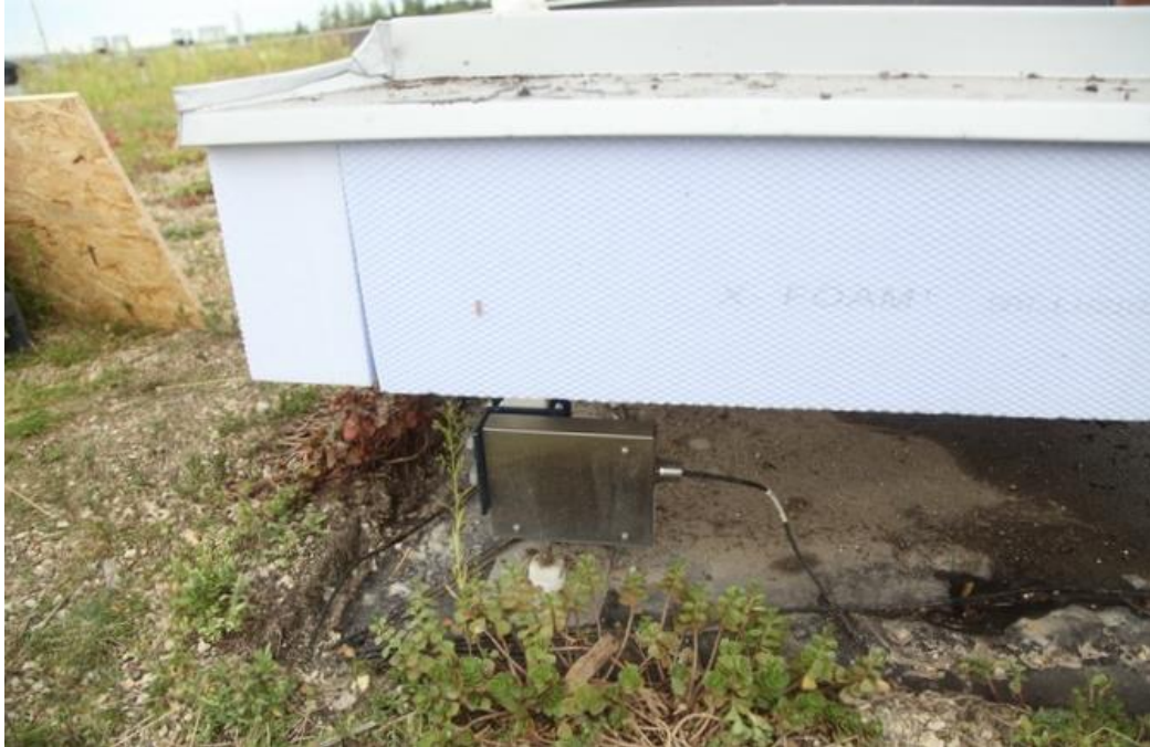
Obrázek 6: Detail izolace segmentu
