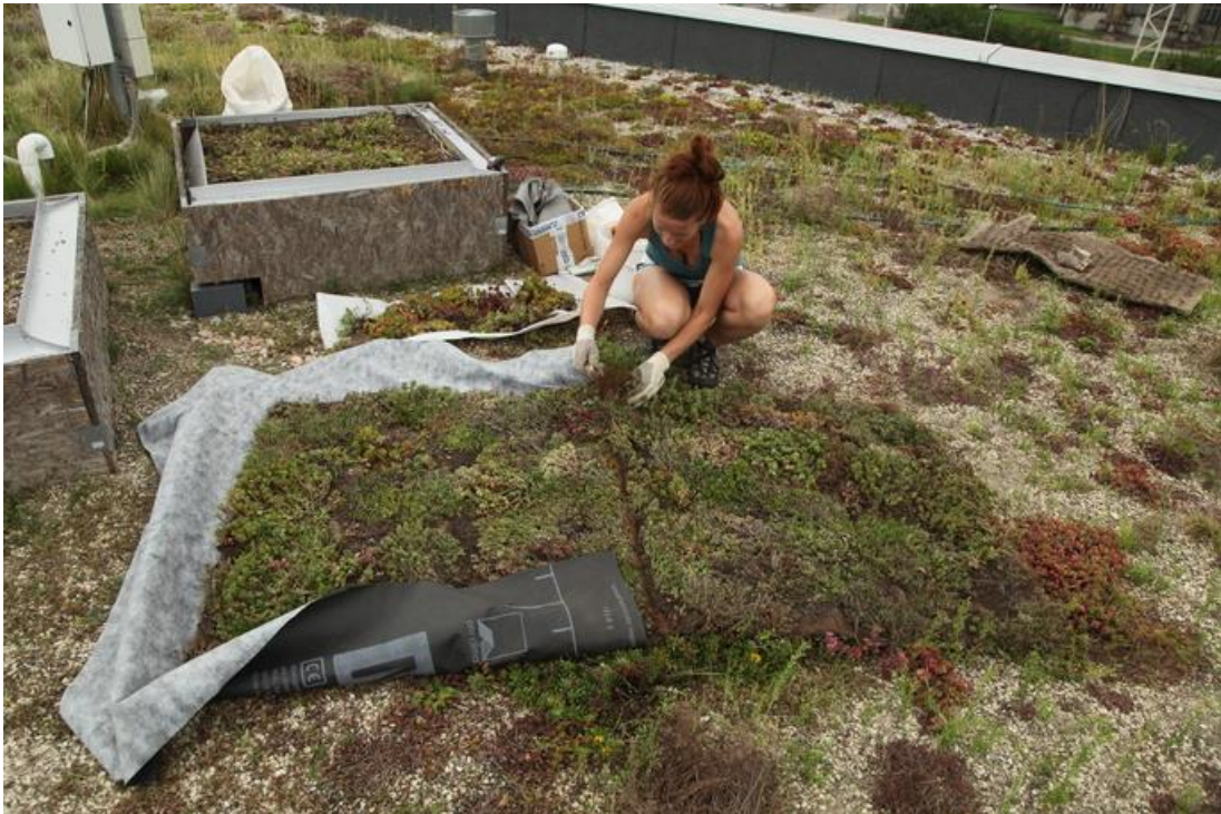
Obrázek 12: Půlení rozchodníkového koberce (2 x 1,1 m)
