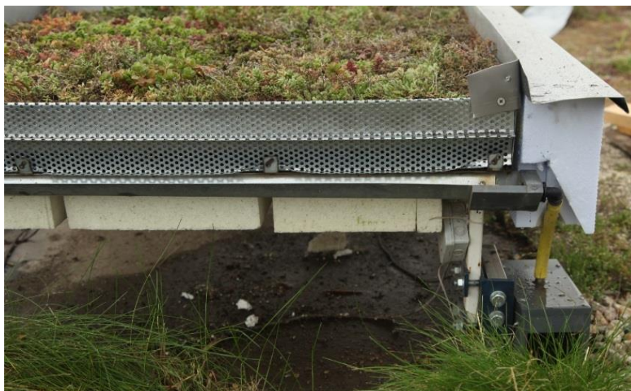
Obrázek 5: Detail perforované mřížky, žlabu a krytu s překlápěcím člunkem
