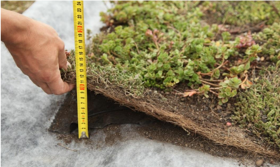
Obrázek 14: Detail tloušťky rozchodníkového koberce
