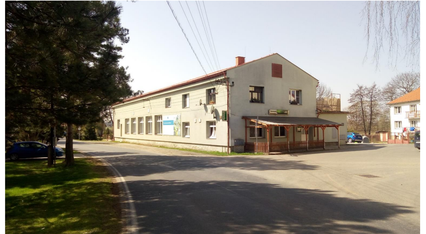
Obrázek 13: Problém 2: Neoznačený a zapadlý vstup k obecnímu úřadu, vlastní fotografie (duben 2018)
