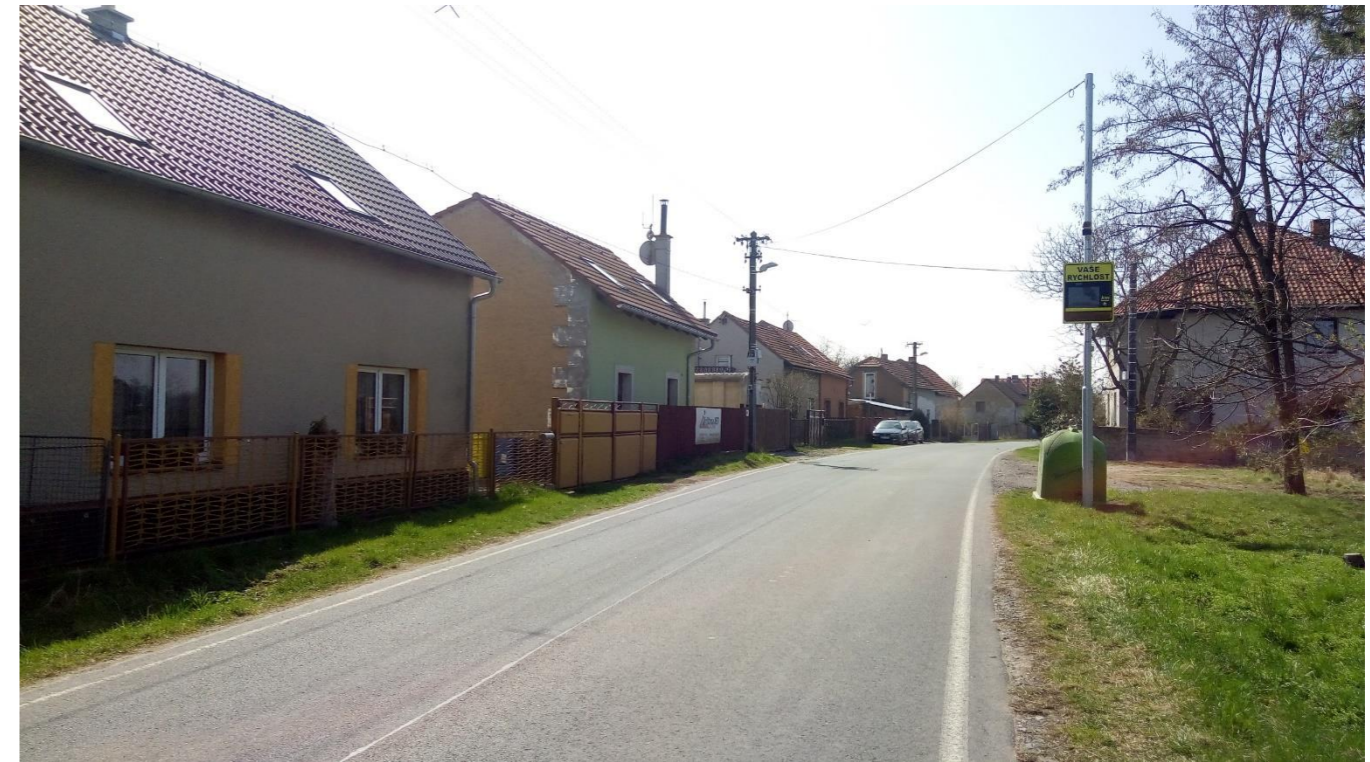
Obrázek 25: Zástavba na silnici II/334, vlastní fotografie (duben 2018)
