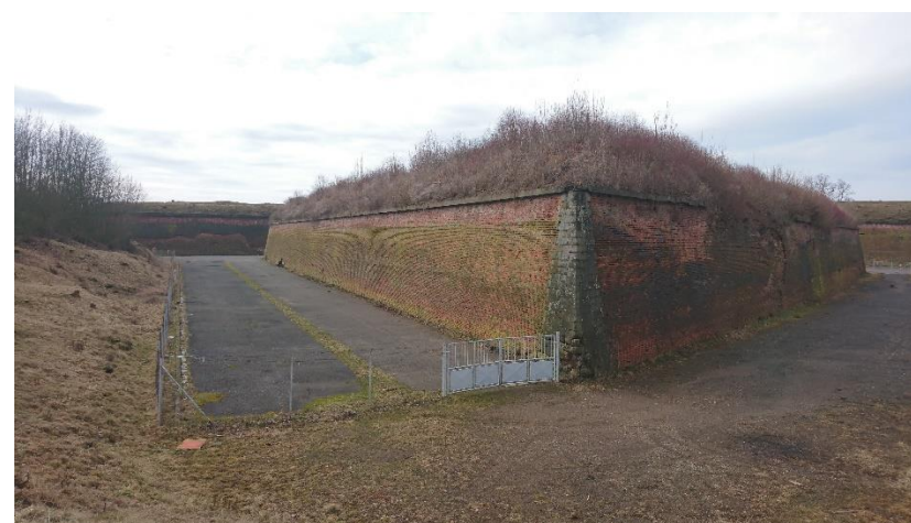
Obrázek 37 – Pohled na část pevnosti
