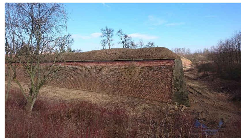
Obrázek 48 - Pohled na část pevnosti
