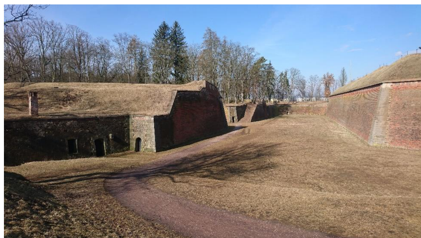
Obrázek 45 - Pohled na část pevnosti
