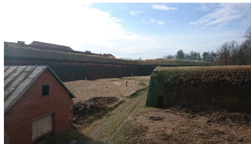
Obrázek 42 - Pohled na část pevnosti
