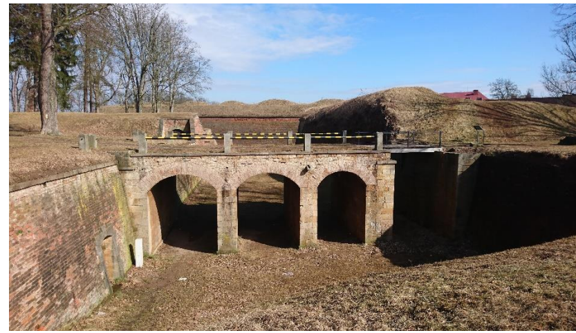
Obrázek 44 - Pohled na most, který byl součástí pevnosti, nalezen a vykopán byl až začátkem tisíciletí
