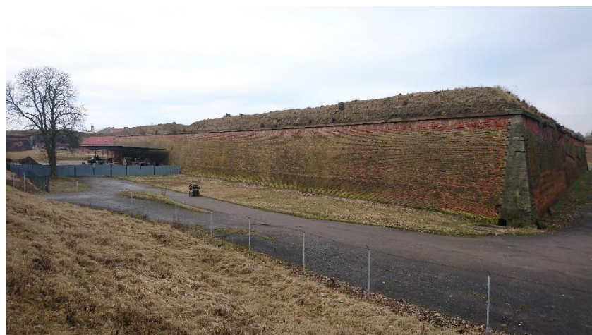
Obrázek 35 – Pohled na část pevnosti
