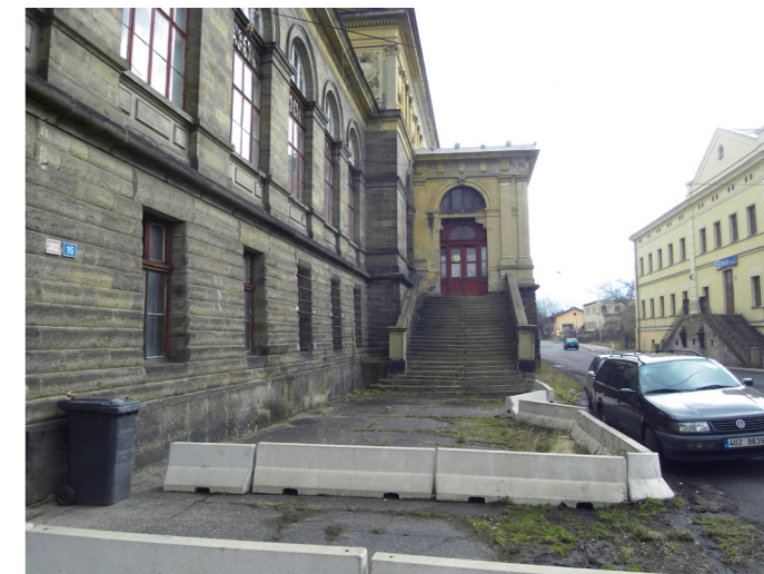
PROSTOR MEZI SEVERNÍ A JIŽNÍ BUDOVOU
