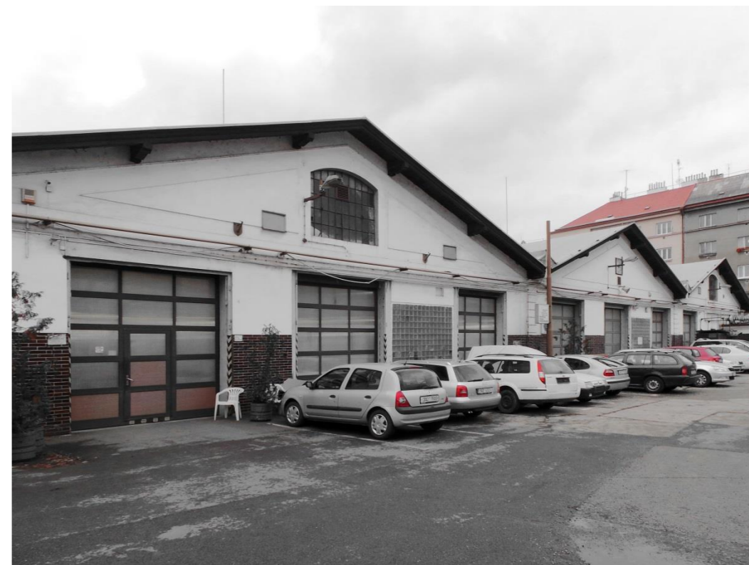
severná fasáda- súčasný stav
