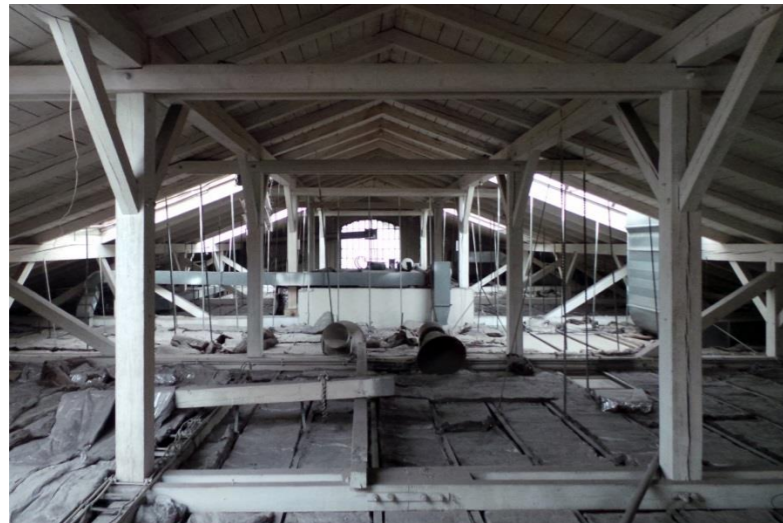
pohľad do krovu nad podhľadom
