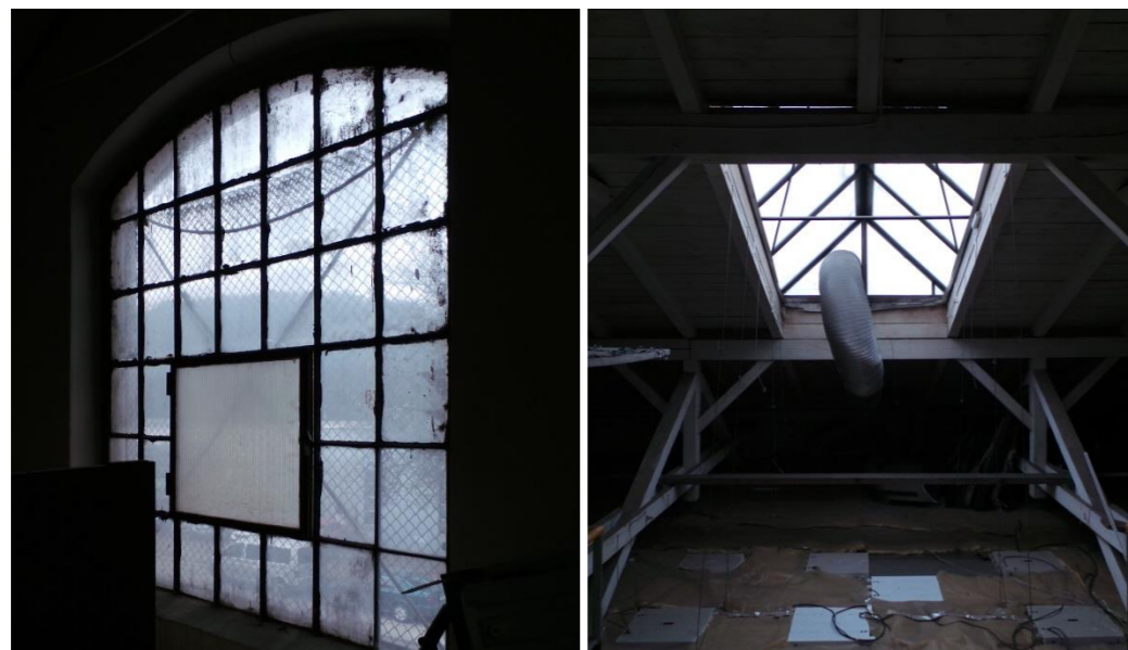
pôvodné výplne- okno a svetlík
