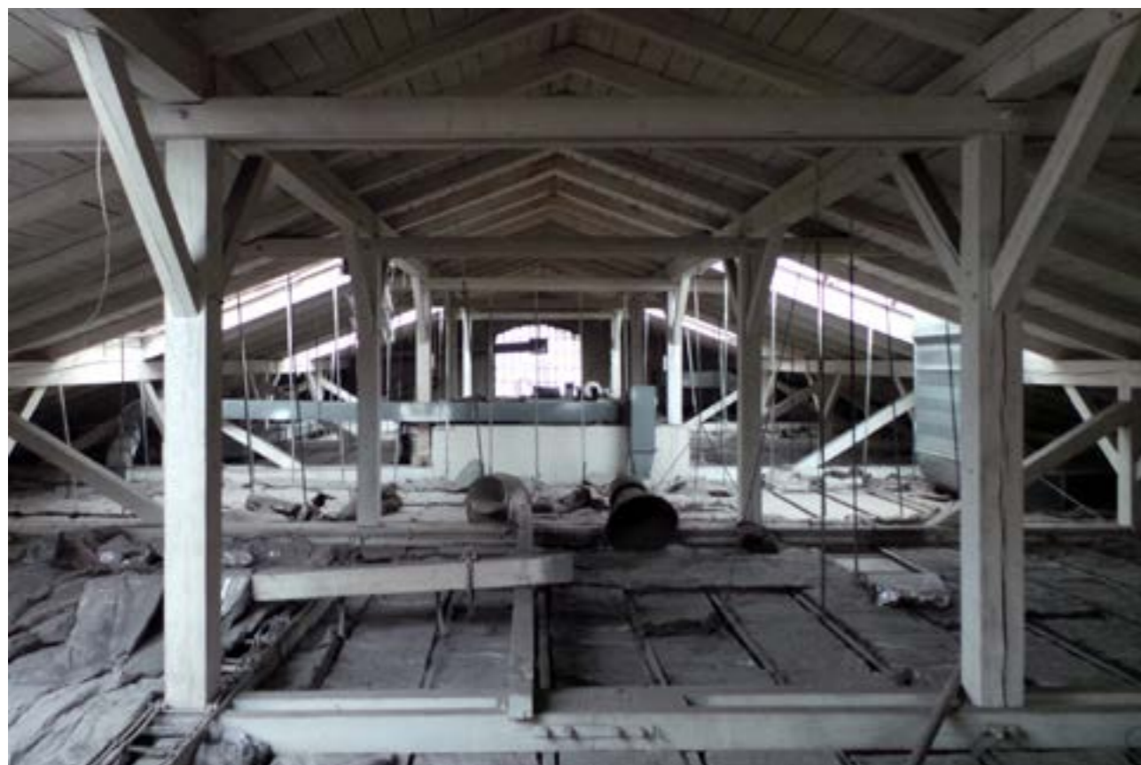
pohled do krovu nad podhledem
