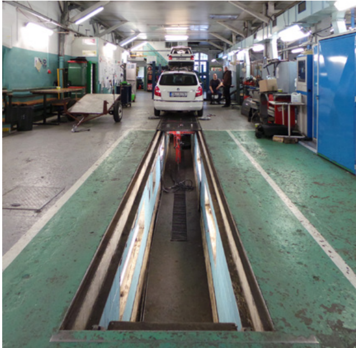
Povrch stávající stěrkové podlahy a montážní jáma
