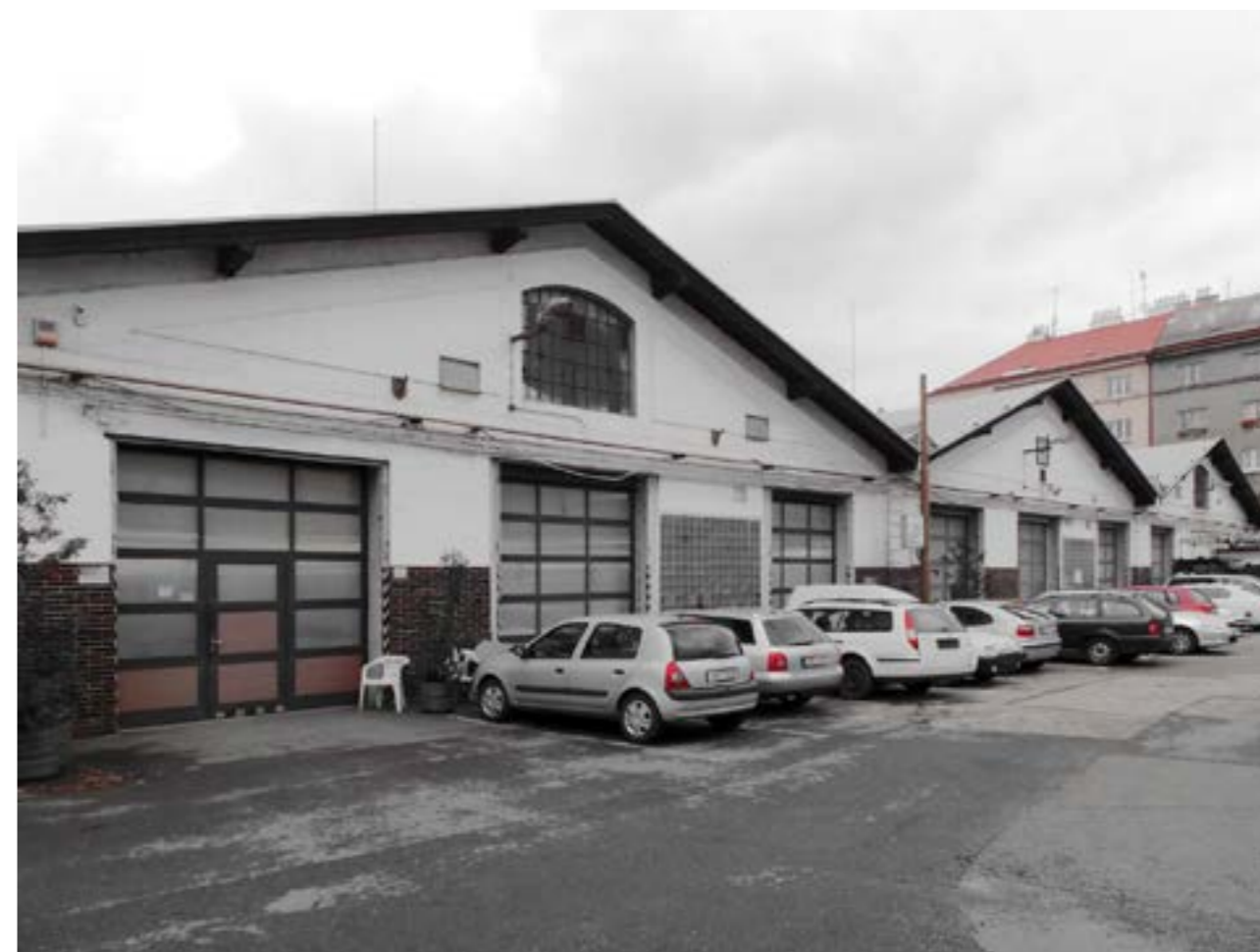
Současný stav severní fasády
