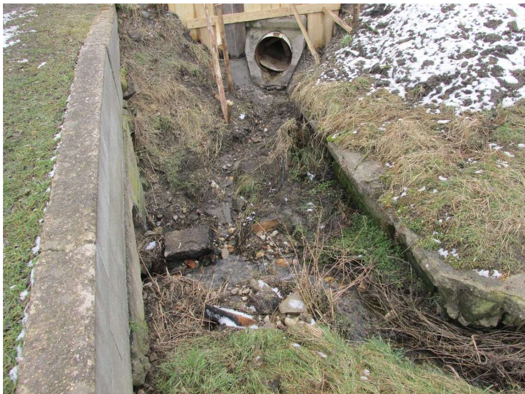
Obr. č. 5 – Propustky pod hrází, pohled na pravostranný přítok
