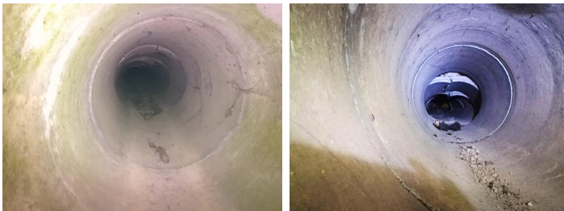
Obr. 23 - Přeliv proti toku vody, zdroj: vlastní archiv
