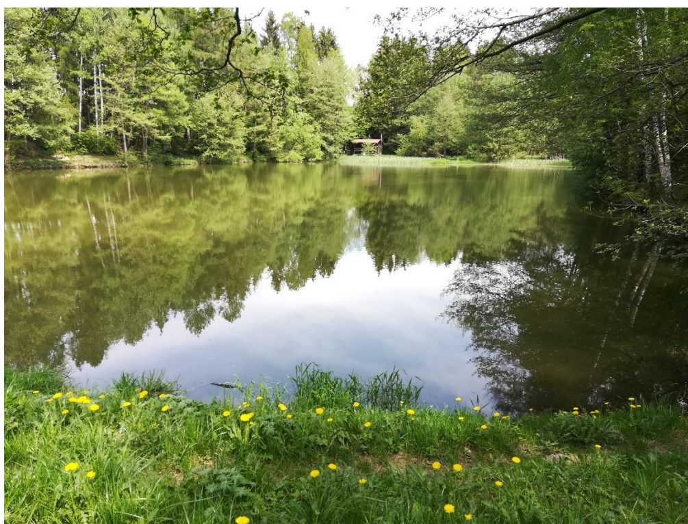
Obr. 7 - Pohled na nádrž z hráze, zdroj: vlastní archiv
