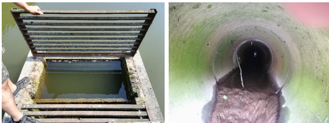
Obr. 16 – Odpadní potrubí spodní výpusti, zdroj: vlastní archiv
