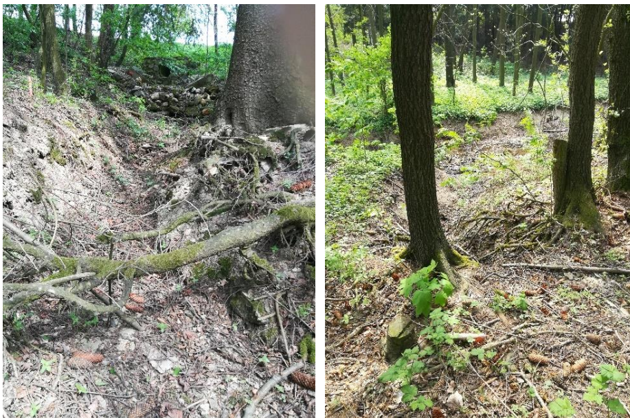
Obr. 29 - Odpadní koryto od přelivu, pohled po toku, zdroj: vlastní archiv
