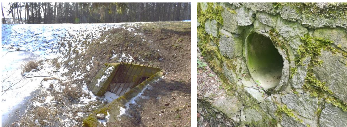
Obr. 21 - Výtokové čelo, zdroj: vlastní archiv
