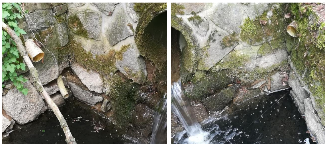
Obr. 12 - Zaústění levobřežní drenáže do vývaru, zdroj: vlastní archiv
