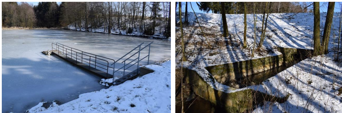
Obr. 14 - Vývar spodní výpusti, zdroj: vlastní archiv
