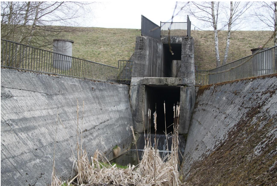
Obrázek 10 - Pohled na odpadní koryto sruženého objektu
