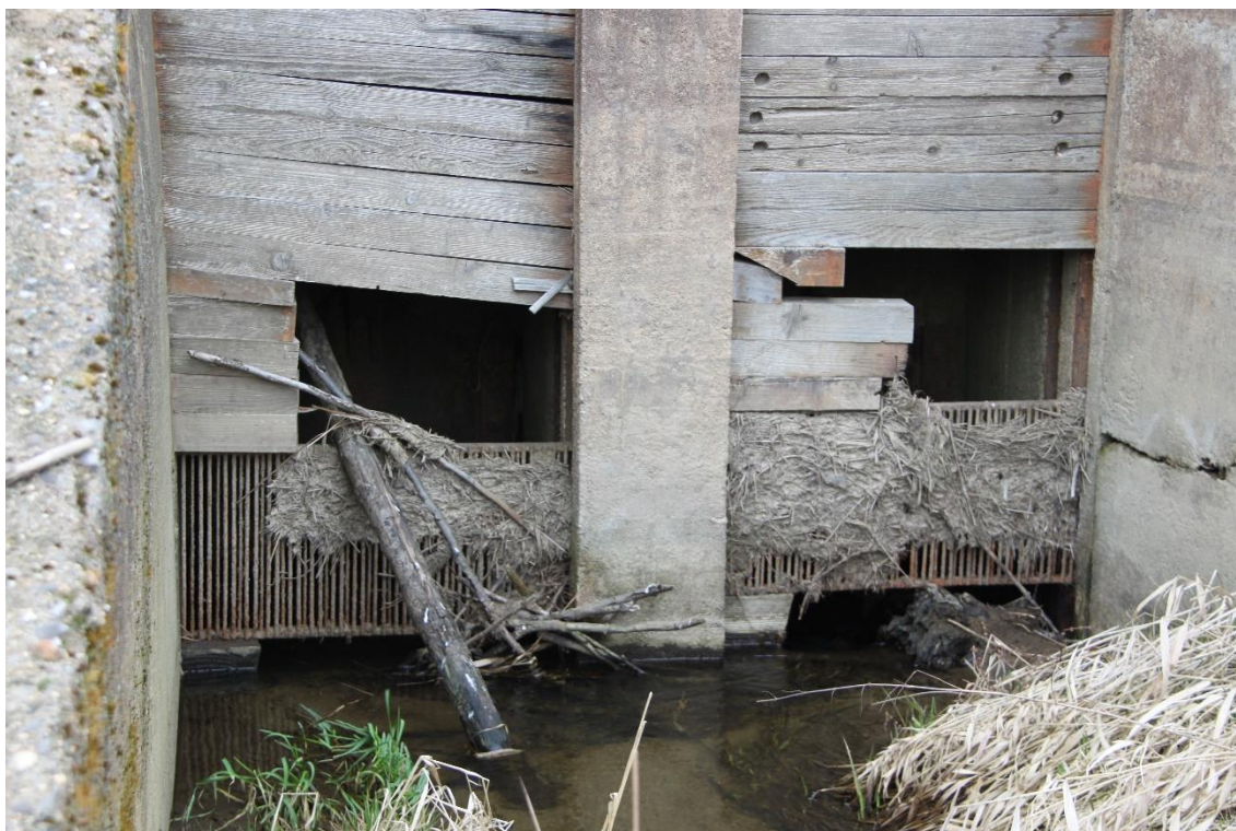
Obrázek 16 - Zanesené česle požeráku
