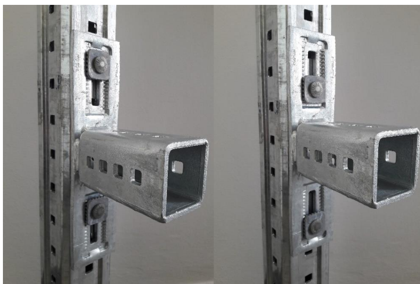
Obr. 22: Různé konfigurace šroubů přípoje
