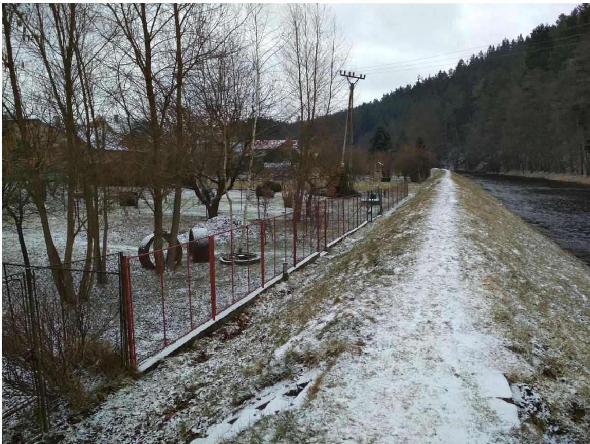
Obr. 11.1 Stávající protipovodňová hráz
