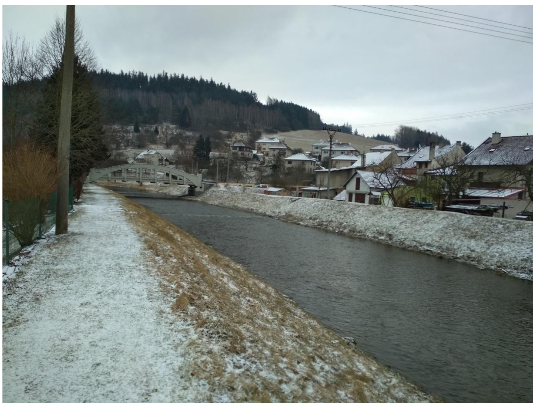
Obr. 14.13 Upravené koryto Svatky v obci Jimramov a protipovodňové hráze
