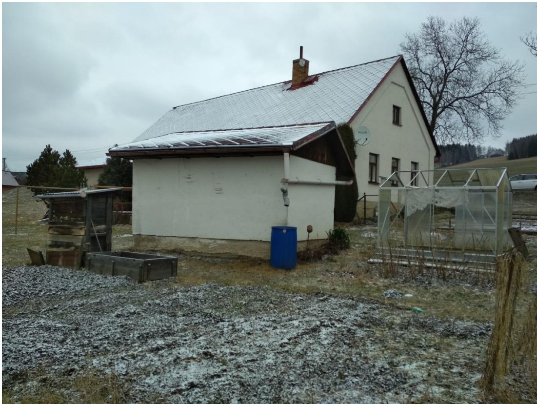
Obr. 14.5 Ohrožená budova pro skladování
