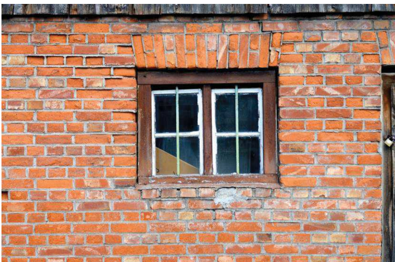
Obr. 5 Stěna realizovaná z plných cihel 1
