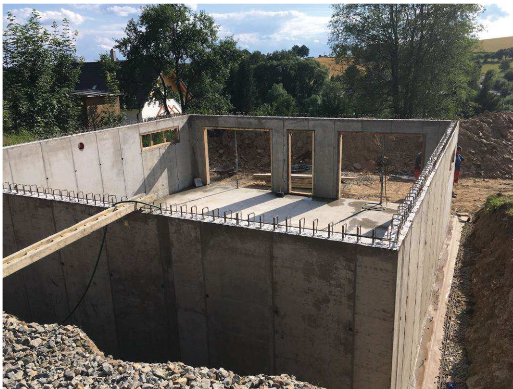
Obr. 1 Stěna z monolitického železobetonu 1
