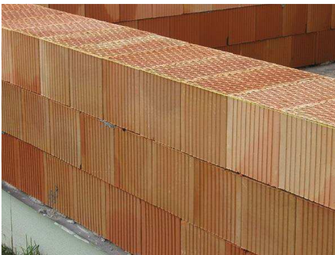
Obr. 6 Stěna realizovaná z vylehčených tvárnic P+D na maltu pro tenké spáry 2
