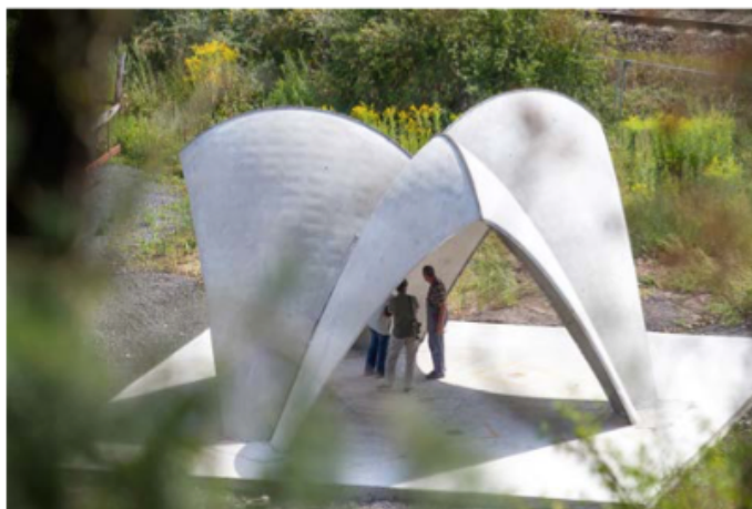
Obr.14 – TRC konstrukce ze šesti odlitých součástí, zdroj:[25].
