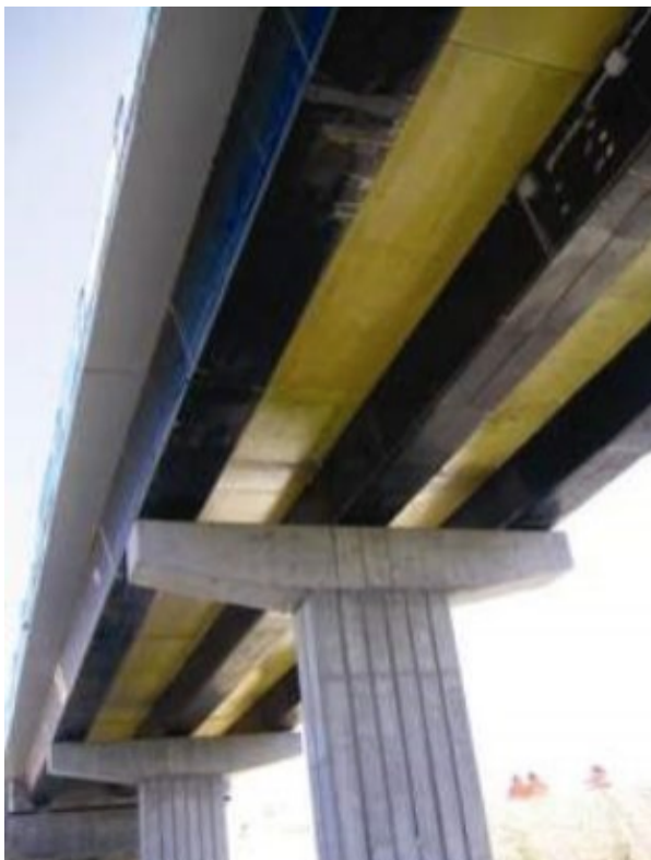
Obr.11 – Zesilování mostu pomocí kompozitních materiálů., zdroj: [21].
