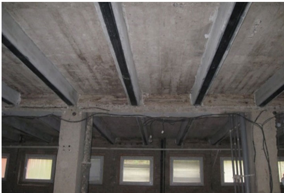
Obr.26 – Zesílení ž.b. trámů pomocí CRFP lamel, Nemocnice Hořovice, zdroj: [33].
