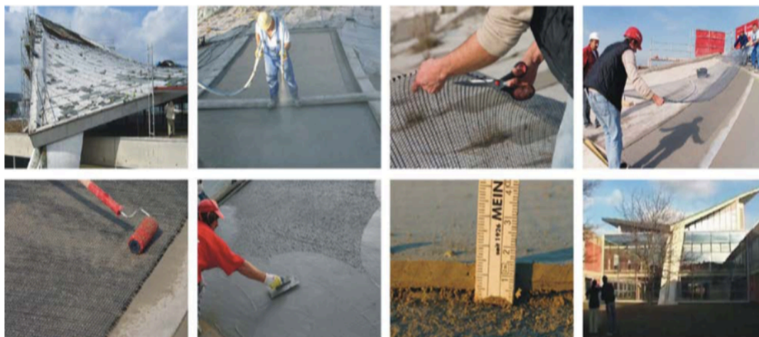
Obr.16 – zesilování střechy , zdroj:[25].
