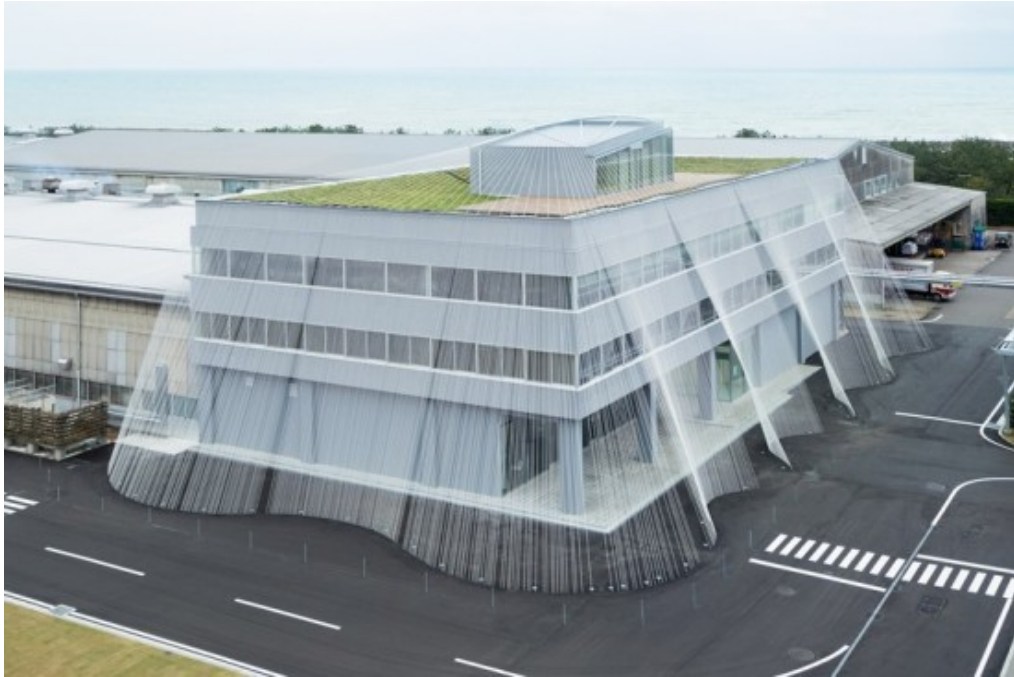
Obr.22 – Budova Komatsu Seiren v Japonsku s tyče z uhlíkových vláken jako seizmická výztuž., zdroj:[31].
