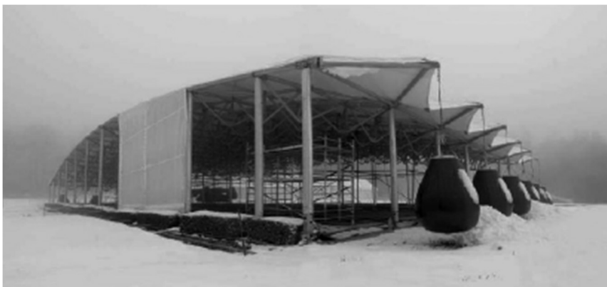
Obr. č. 33:Zavěšená zátěž z pytlů s pískem, zdroj [3] str. 306
