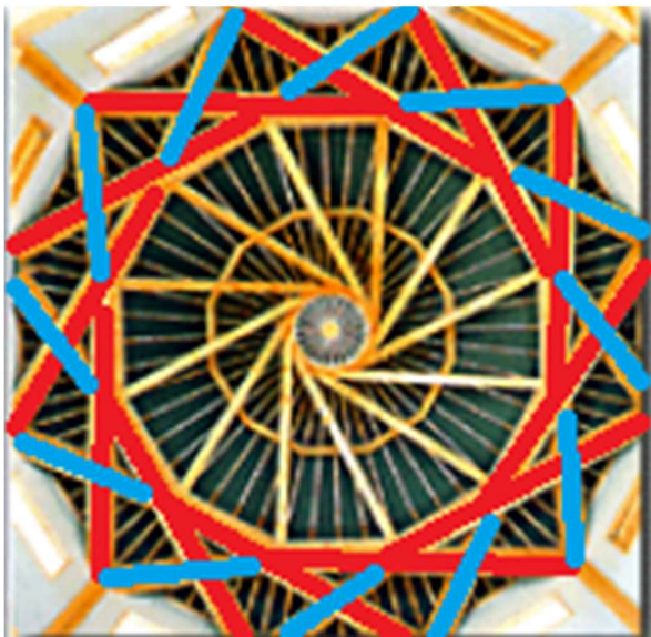
Obr. č. 26: Prstenec, zdroj [9], zvýraznění reciproční konstrukce vlastní
