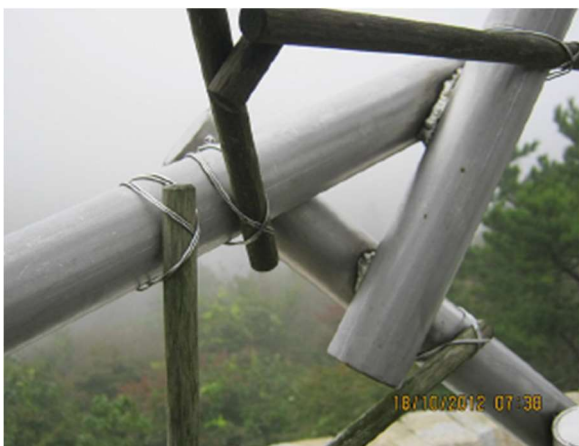
Obr. č. 20: Svařovaný spoj – observatoř Rocco-Shidare, zdroj [7] str. 124
