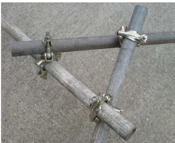
Obr. č. 21. Reciproční jednotka spojená pomocí objímkových otočných spojek, zdroj [5] str. 24
