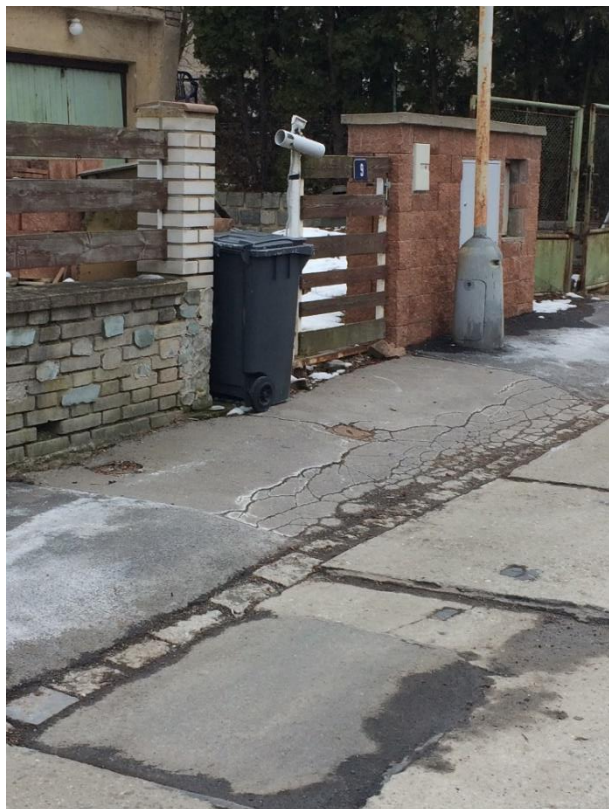
Obr. 26 a 27 Ulice Duchcovská – poruchy vozovky a chodníku
