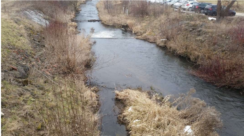
Obr. 3 – Pohled na koryto toku, foceno ze silničního mostu v ř. km 3,005
