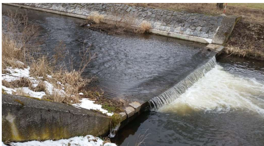
Obr. 12 – Stupeň ve dně v ř. km 3,533
