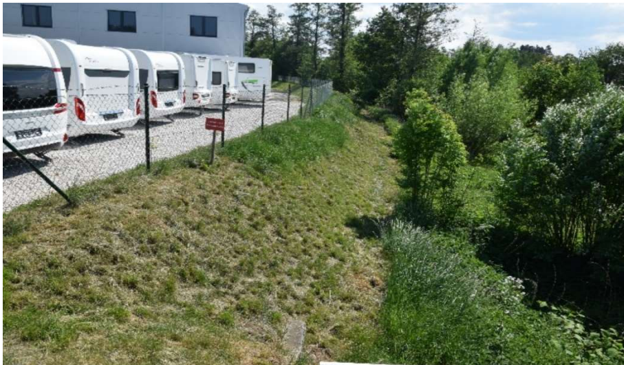
Obr. 26 – Pohled na hráz objektu s prodejem karavanů
