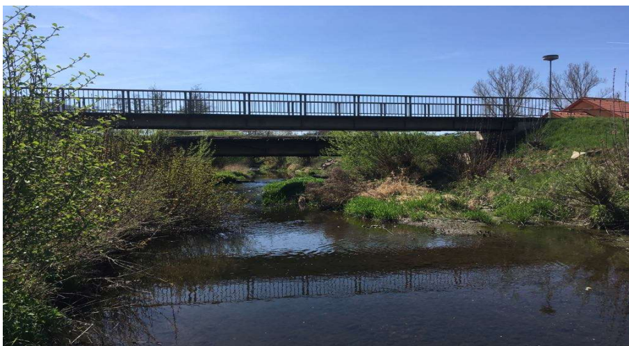
Obr. 8 – Most pro pěší v ř. km 3,005
