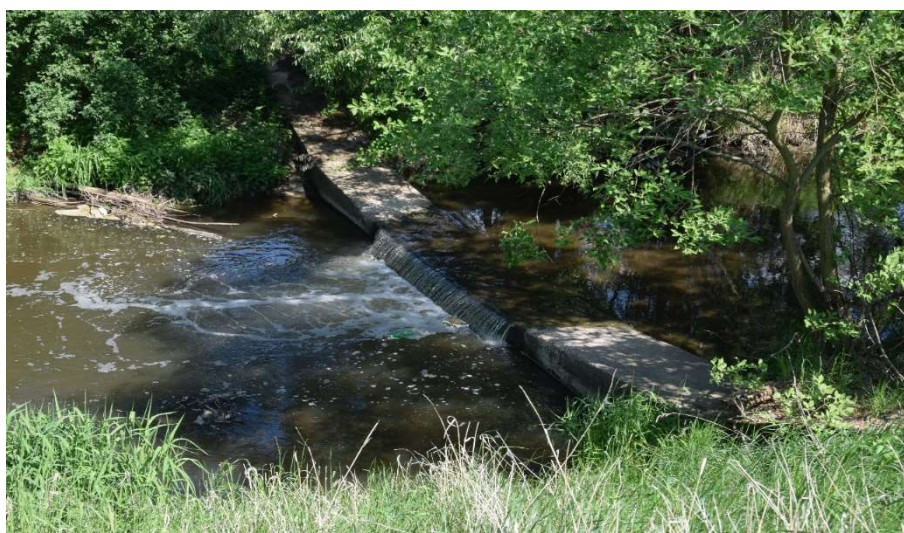
Obr. 10 – Stupeň ve dně v ř. km 3,082
