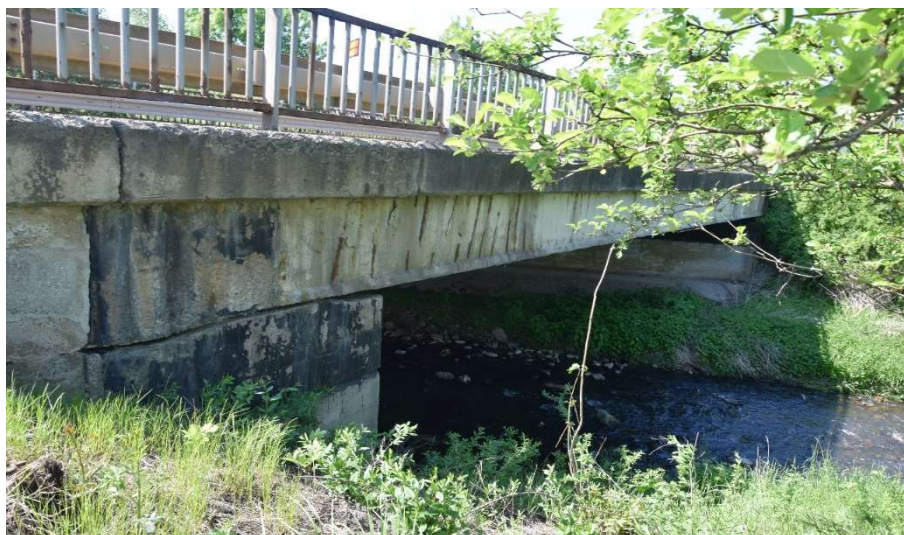
Obr. 11 – Silniční most v ř. km 3,480
