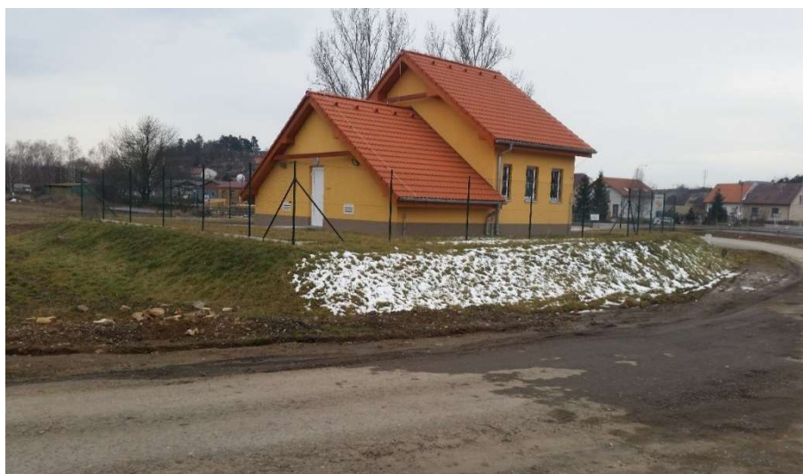
Obr. 23 – Pohled na ohrázovaný objekt ČOV
