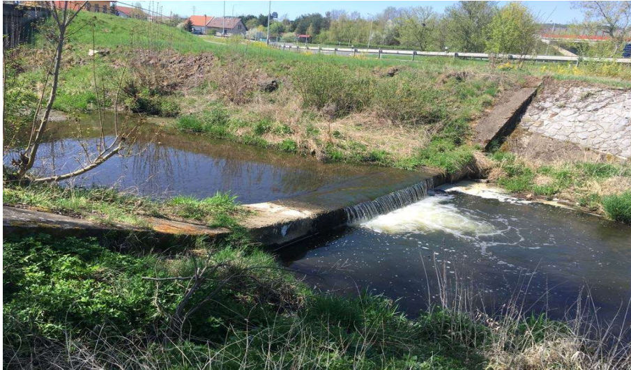
Obr. 7 – Stupeň ve dně v ř. km 2,984
