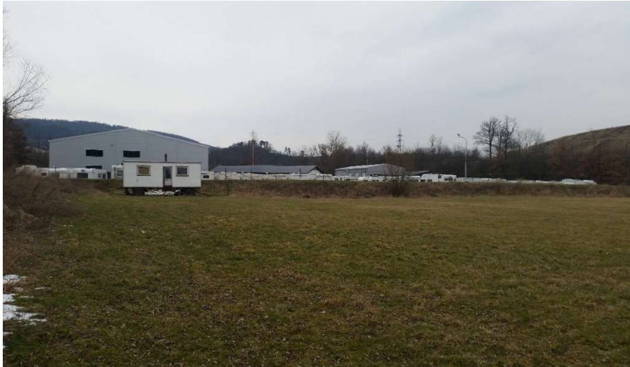
Obr. 25 – Pohled na ohrázený objekt prodejny karavanů
