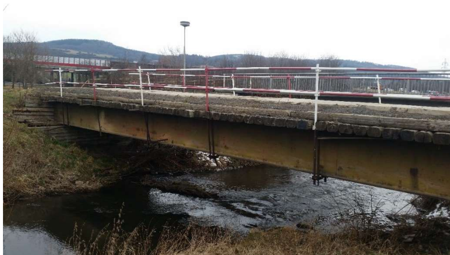
Obr. 9 – Silniční most v ř. km 3,017
