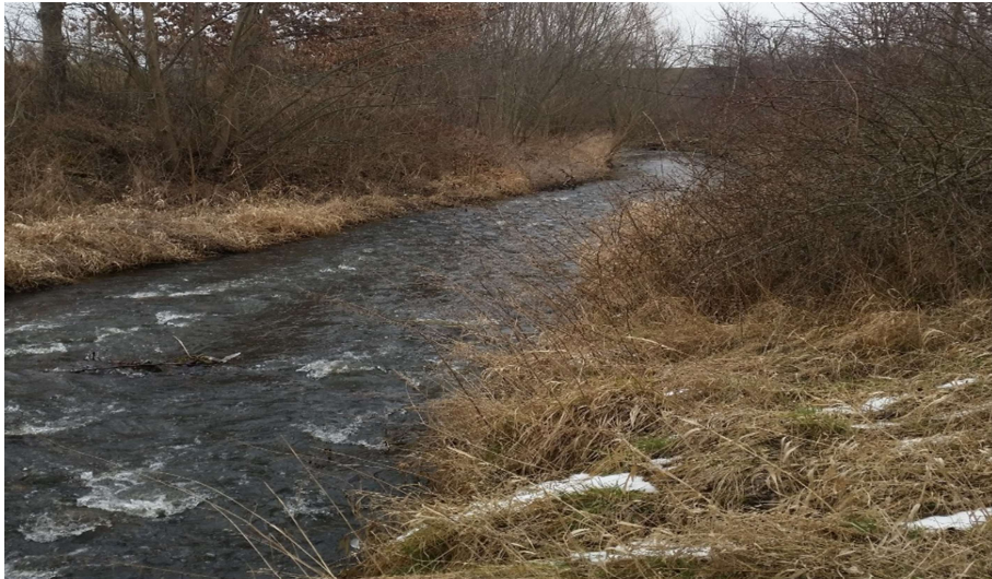
Obr. 5 – Pohled na koryto toku, foceno za silničním mostem v ř. km 3,480
