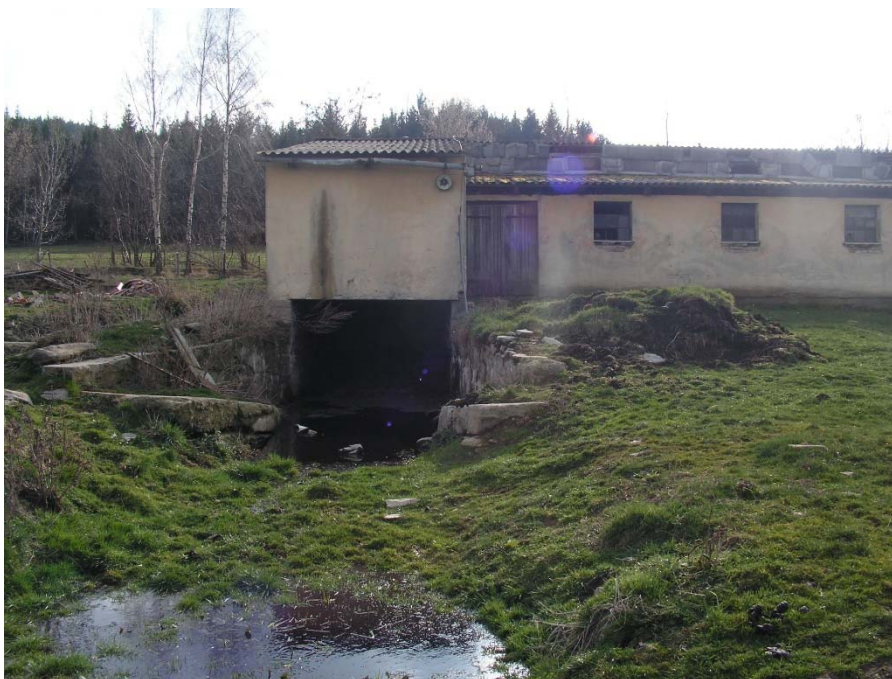
obr.4 – Podsklepená část určená pro shoz mrvy
