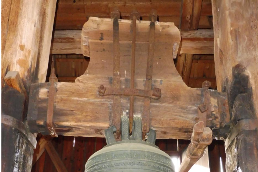
Obrázek 57 - Rovný dřevěný závěs zvonu
