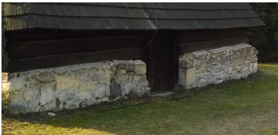
Obrázek 10 – Zděný přízemek s roubenými trámy
