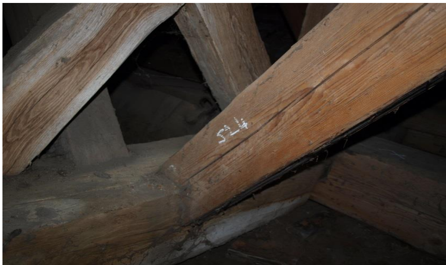
Obrázek 22 - Sedlový spoj vzpěry „S24“
