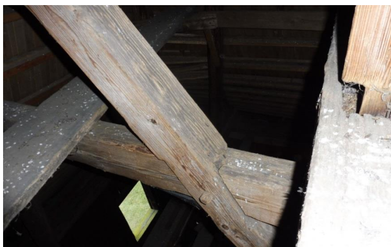
Obrázek 27 – Částečné překlátování šikmého a vodorovného prvku věže
