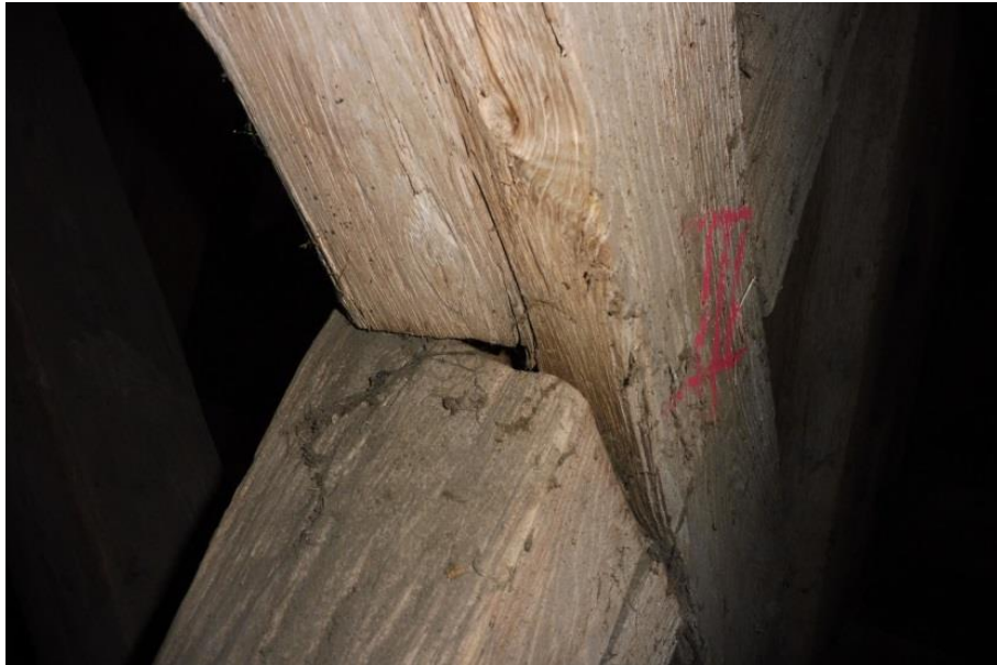
Obrázek 23 - Překlátování prvků zavětrovacích křížů
