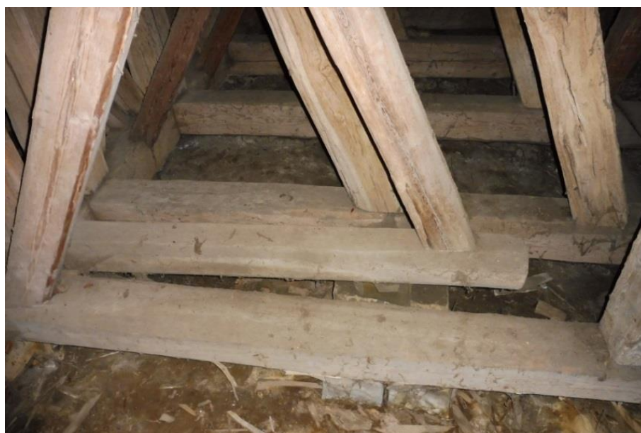
Obrázek 14 - Umístění šikmých vzpěr „S“ na vodorovných trámech č. 1 až 9
