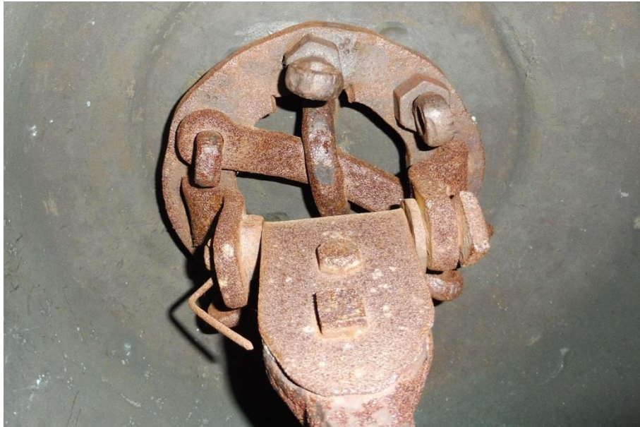
Obrázek 55 - Detail úchytu srdce
