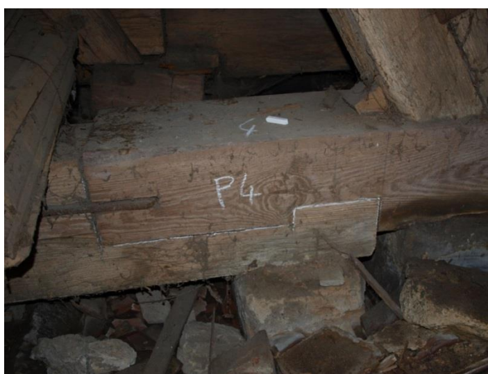
Obrázek 28 - Plátový spoj s ozubem na trámu č. 4 s využitím tesařské skoby
