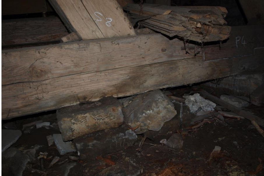
Obrázek 9 - Kamenná podpěra vodorovného trámu
