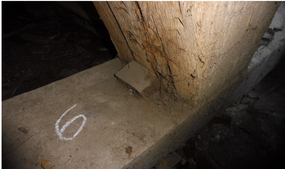
Obrázek 21 - Čepový spoj doplněný klínem
