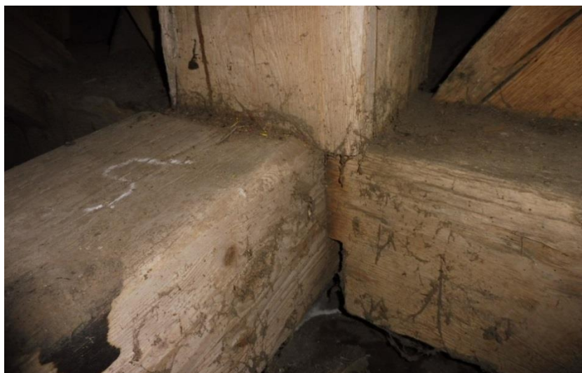
Obrázek 39 - Spoj přeplátováním mezi trámy č. 5 a č. 2
