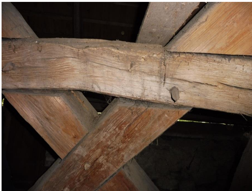
Obrázek 24 - Překlátování doplněné dřevěným kolíkem
