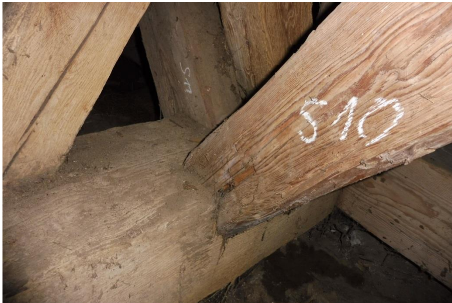
Obrázek 92 - Posuzovaný spoj vzpěry „S10“ a trámu č. 2
