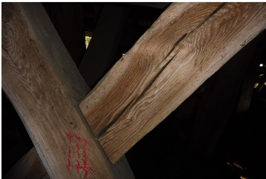
Obrázek 7 - Výsušné trhliny
