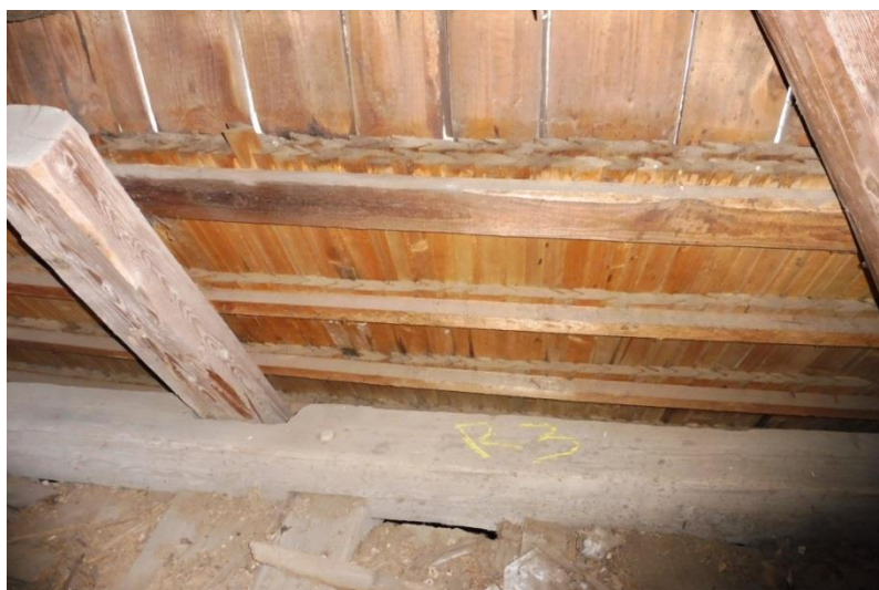
Obrázek 47 - Přesah střešního pláště do 2.NP
