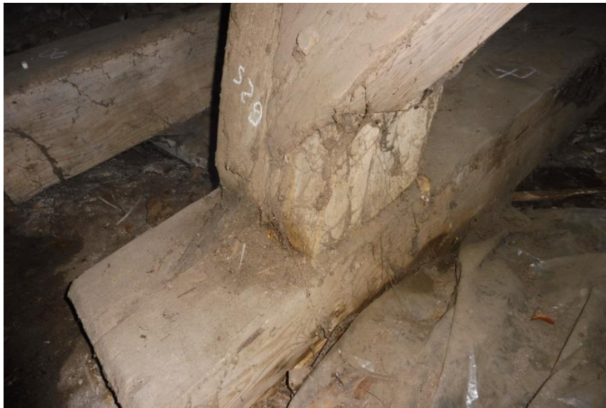
Obrázek 96 - Posuzovaný spoj vzpěry „S29“ a trámu č. 7
