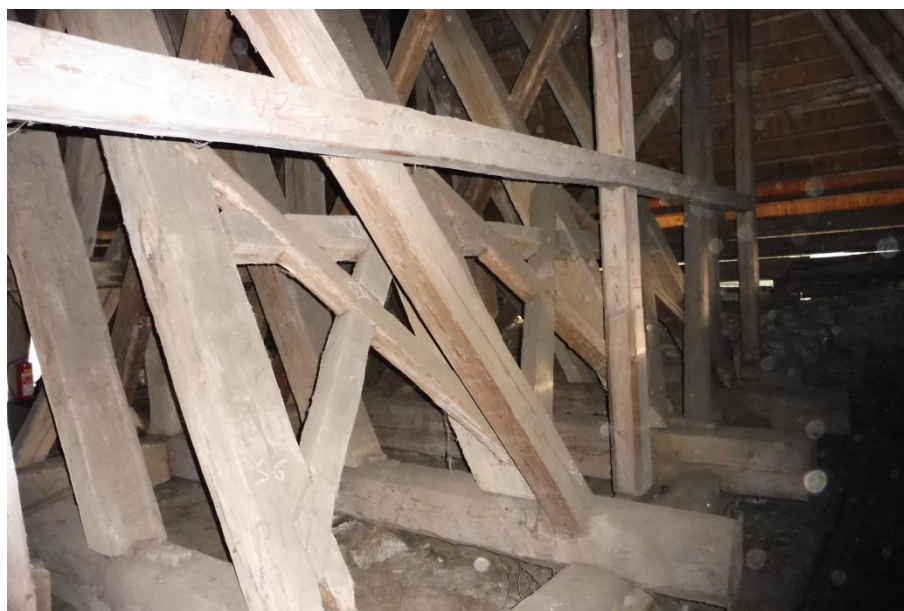
Obrázek 12 - Pohled na konstrukci 1.NP z jižní strany objektu
