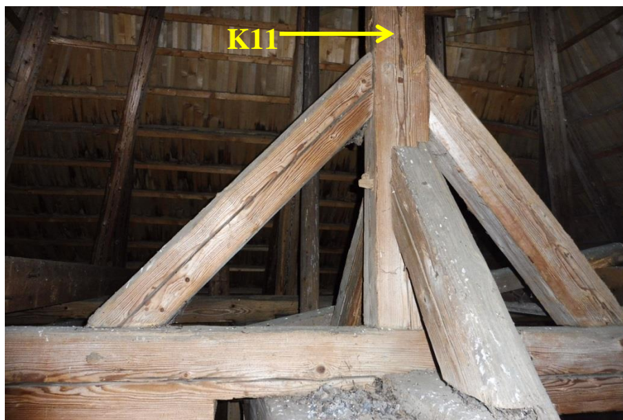
Obrázek 19 – Vzpěry v patě vřetena „K11“
