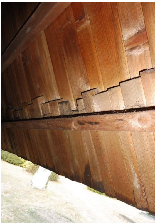
Obrázek 45 - Pohled zespodu na latování
