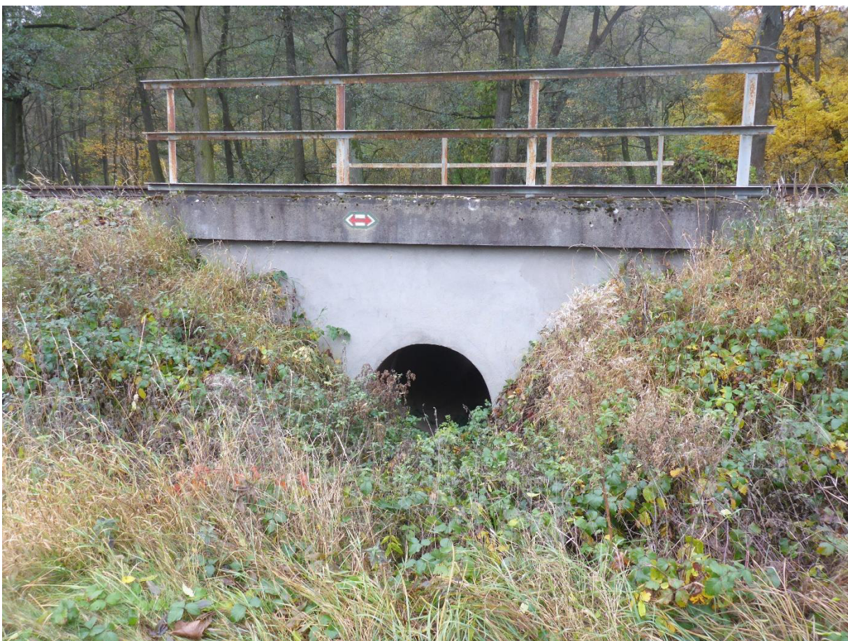
Obrázek 3-5: Příklad propustku pod železničním tělesem
