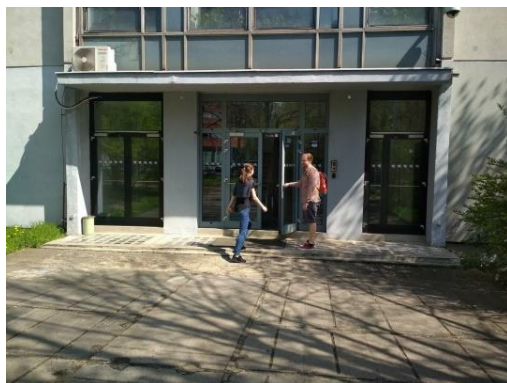
Obr. 27: Pohled na vstup č. 5
