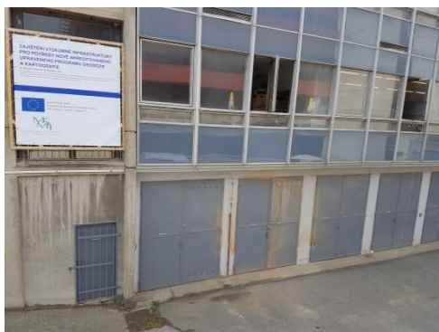
Obr. 37: Pohled na vstup č. 10
