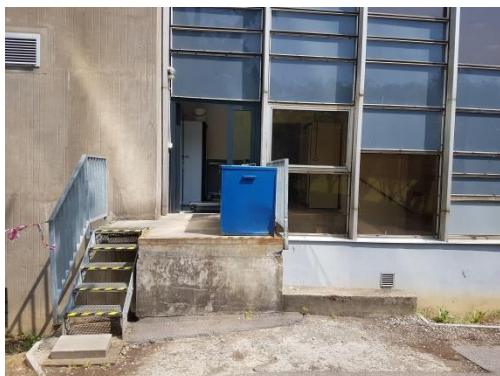
Obr. 35: Pohled na vstup č. 9
