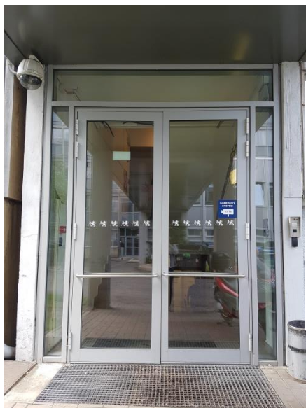
Obr. 23: Pohled na vstup č. 3
