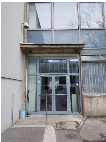
Obr. 25: Pohled na vstup č. 4
