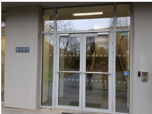
Obr. 31: Pohled na vstup č. 7
