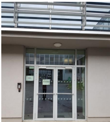
Obr. 29: Pohled na vstup č. 6
