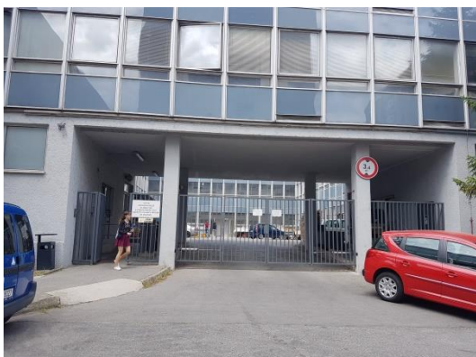
Obr. 19: Pohled na vstup č. 2
