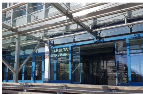
Obr. 16: Pohled na vstup č. 1
