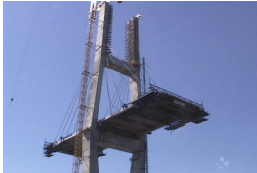
Obr. 9: Letmá betonáž zavěšeného mostu
