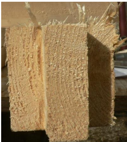
Obrázek 64 Průběžný čep
