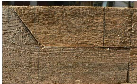
Obrázek 31 – Šikmočelný plát spojený
