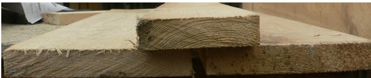
Obrázek 94 – Dvoustranné překládání
