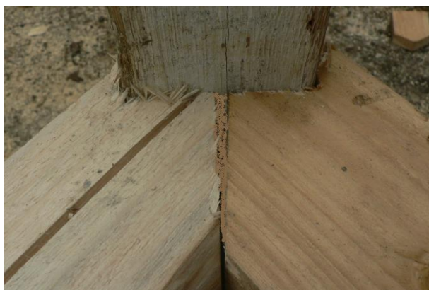
Obrázek 44 – Zadrápnutí spojené
