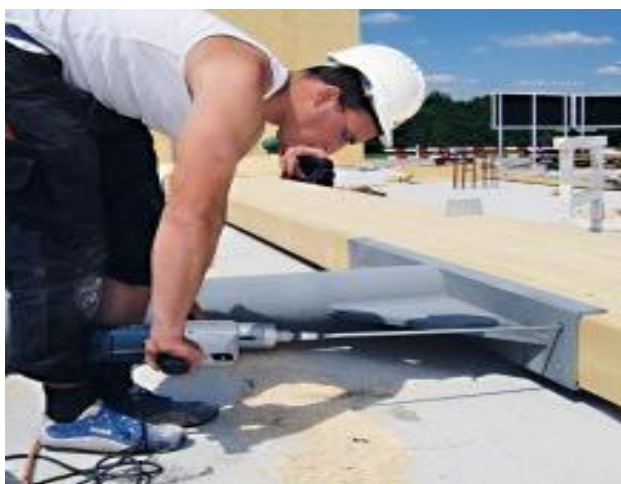
Obrázek 129 – Instalace vrutu systému WR-T
