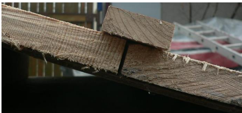
Obrázek 92 – Prostý sraz doplněný lištou
