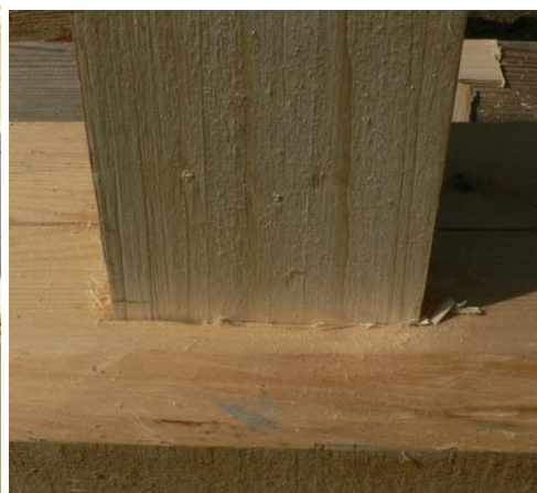
Obrázek 79 – Zapuštění kryté oboustranné
