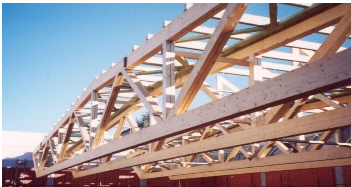
Obrázek 124 – Příklad spojů MKD na střešních vaznících
