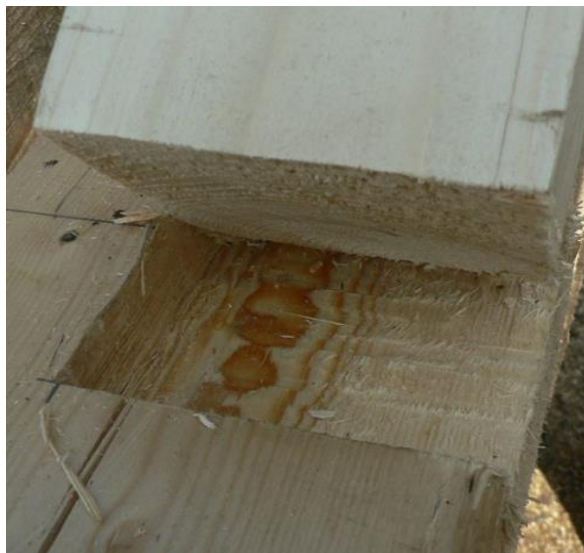
Obrázek 76 – Zapuštění kryté jednostranné
