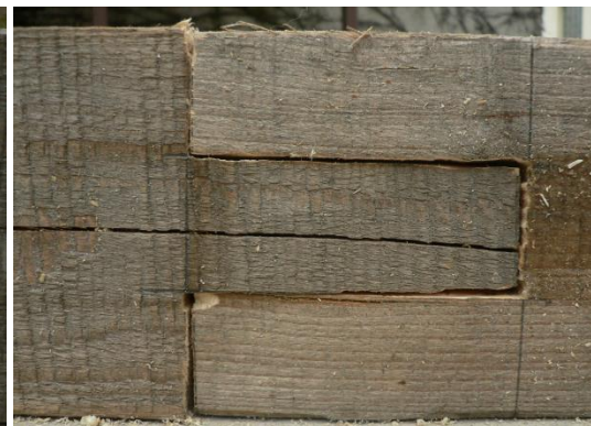
Obrázek 25 – Dvojitý rovný plát spojený
