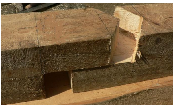
Obrázek 32 – Klínočelný plát před spojením
