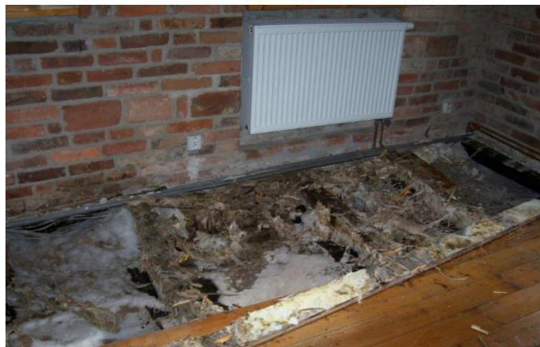
Obrázek 11 – Napadená podlaha Dřevomorkou domácí
