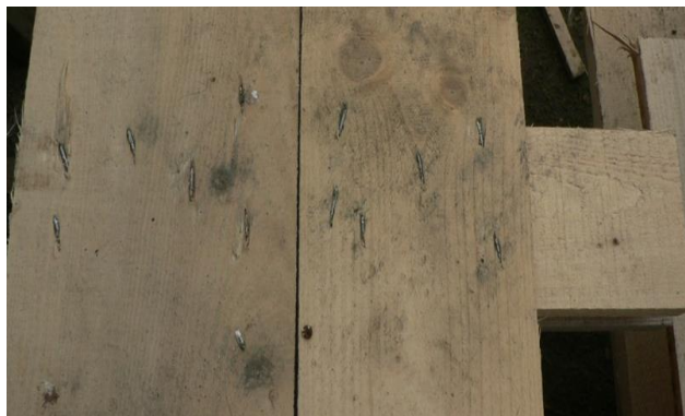
Obrázek 101 – Spojení svlakem u plenty k bedně
