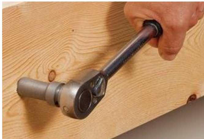
Obrázek 132 – Dotahování tyče WB-T
