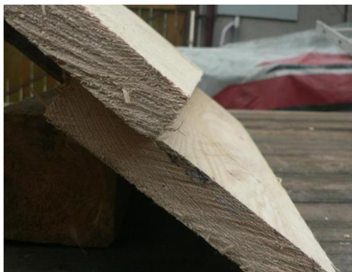
Obrázek 93 – Jednostranné překládání
