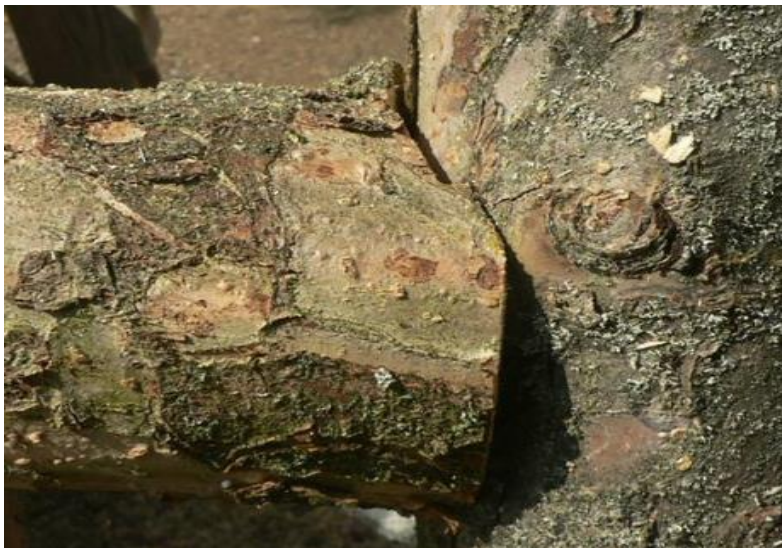
Obrázek 47 – Lípnutí zaoblené
