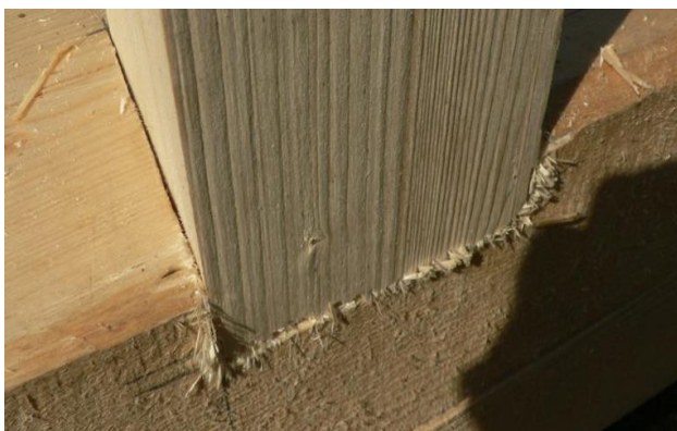
Obrázek 80 – Zapuštění kolmé
