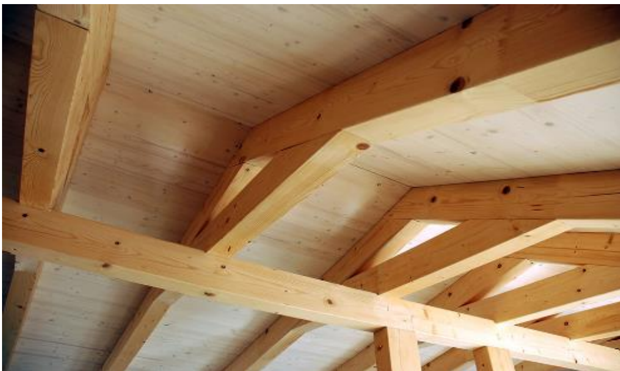
Obrázek 141 – Konstrukce z KVH profilů
