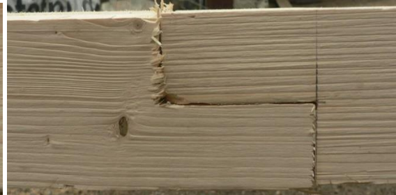
Obrázek 23 – Jednoduchý rovný plát spojený
