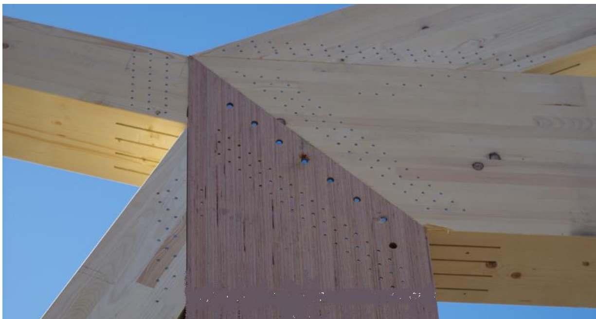
Obrázek 125 – Styčnick spojený BSB systémem
