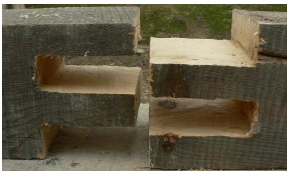
Obrázek 26 – Vicenásobný rovný plát před spojením
