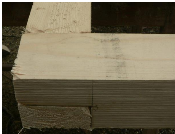
Obrázek 42 – Překlátování rohové
