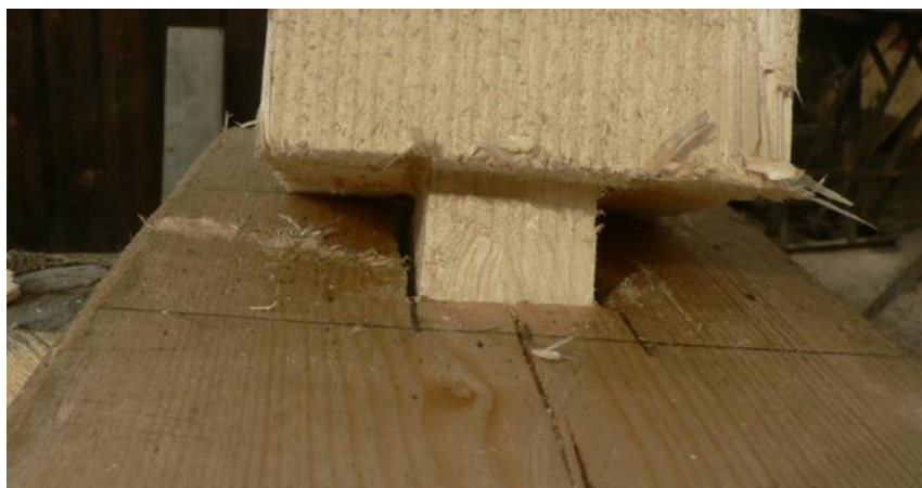
Obrázek 63 – Spojení čepu a dlabu
