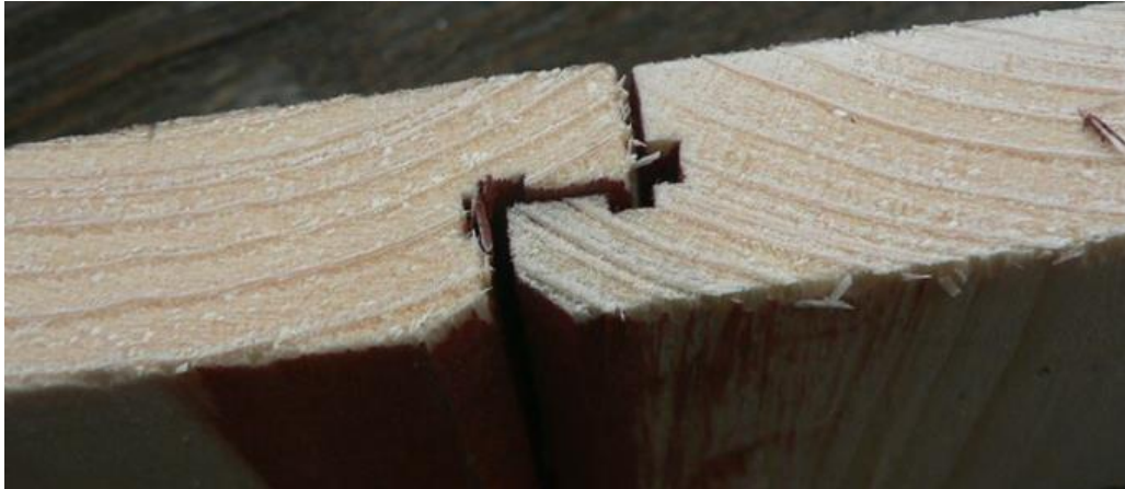
Obrázek 97 – Spojení prken polodrážkami
