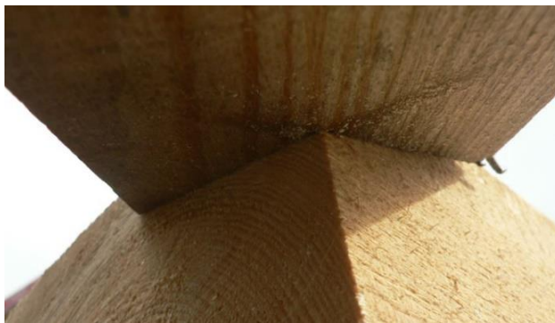
Obrázek 56 – Pohled ze spodku krokve na nárožní sedlo
