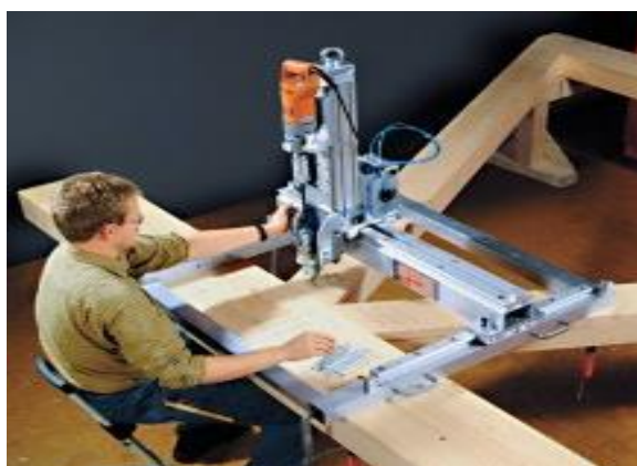
Obrázek 135 – Provádění spoje systému WS-T
