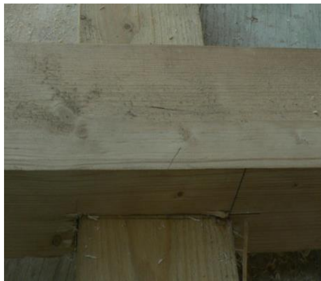
Obrázek 73 – Rybinové karpování po spojení
