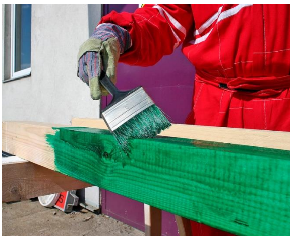
Obrázek 18 – Ruční impregnace dřeva nátěrem
