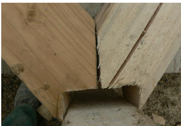
Obrázek 43 – Zadrápnutí před spojením
