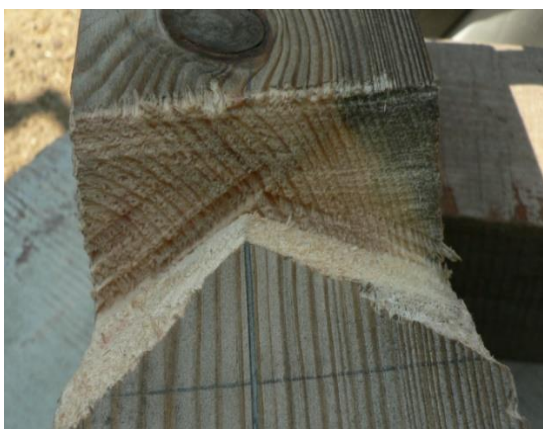
Obrázek 58 – Pohled na úžlabní sedlo ze spodu
