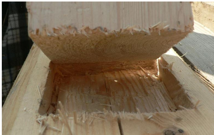
Obrázek 78 – Zapuštění kryté oboustranné
