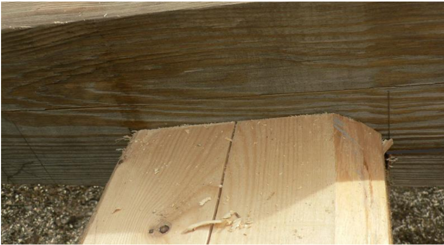
Obrázek 68 – Dvoustranné kamповání – zářezy na obou prvcích
