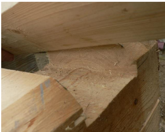
Obrázek 70 – Rovné karpování před spojením
