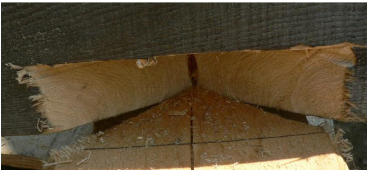
Obrázek 74 – Křížové kámpování před spojením
