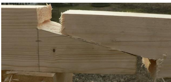
Obrázek 28 – Šikmý plát před spojením
