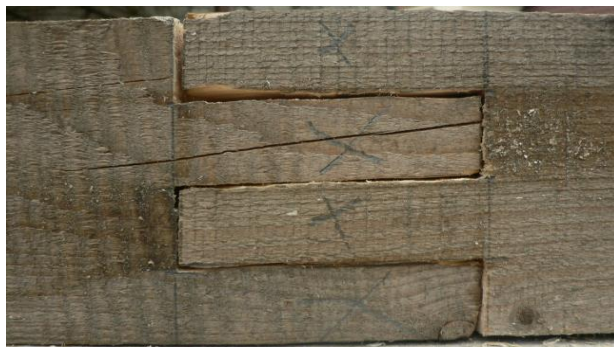
Obrázek 27 – Vicenásobný rovný plát spojený
