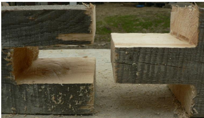
Obrázek 24 – Dvojitý rovný plát před spojením
