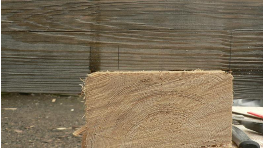
Obrázek 67 – Jednostranné kamповání – zářez jen na jednom prvku
