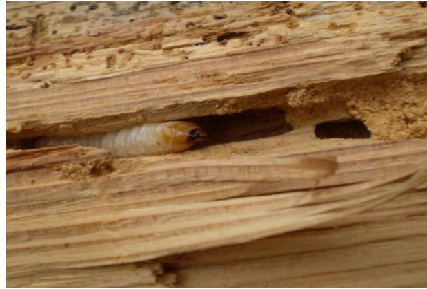
Obrázek 17 – Larva Tesaříka krovového
