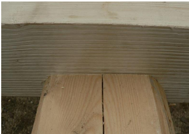
Obrázek 71 – Rovné karpování po spojení
