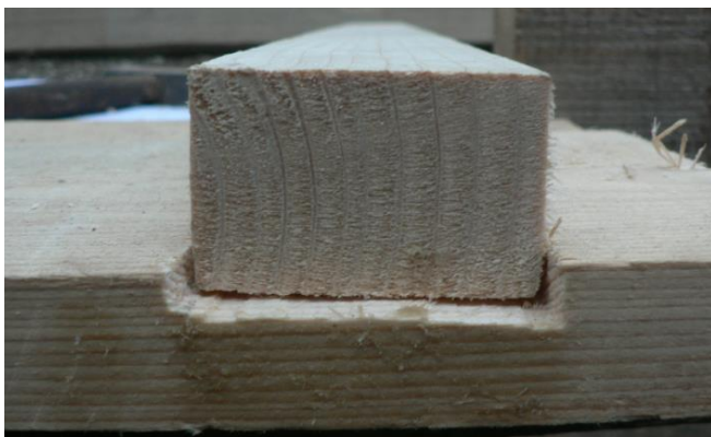
Obrázek 102 – Částečně zapuštěný svlak
