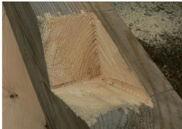
Obrázek 52 – Pohled na půl sedlo
