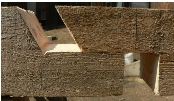
Obrázek 30 – Šikmočelný plát před spojením
