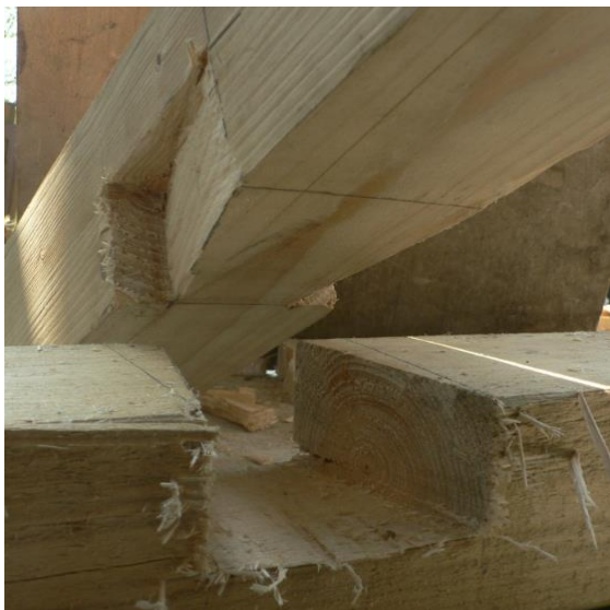
Obrázek 72 – Rybinové karpování nespojené
