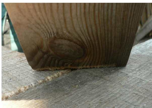
Obrázek 59 – Pohled na úžlabní sedlo
