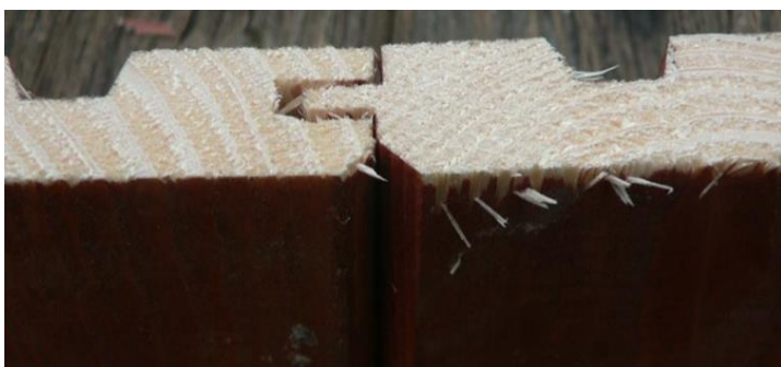
Obrázek 95 – Spojení palubky přes pero a drážku
