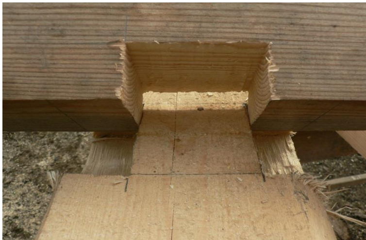
Obrázek 69 – Dvojité kamповání – na jednom prvku jeden zářez, na druhém dva zářezy
