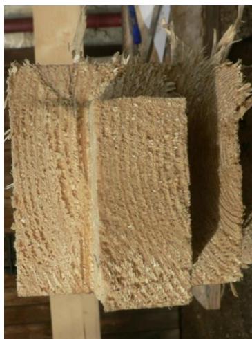
Obrázek 65 Jednostranně odsazený čep
