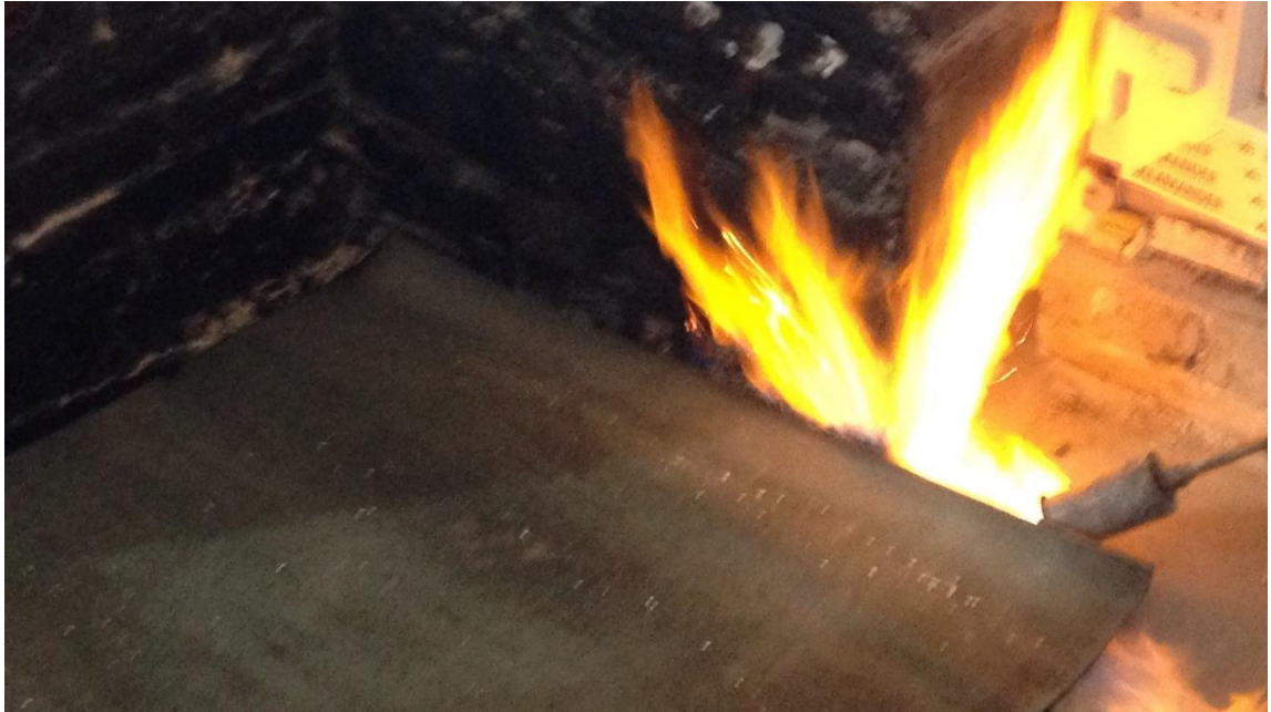
Obr. 9 Natavení hydroizolačních asfaltových pásů 2 (autor Jan Illetško)
