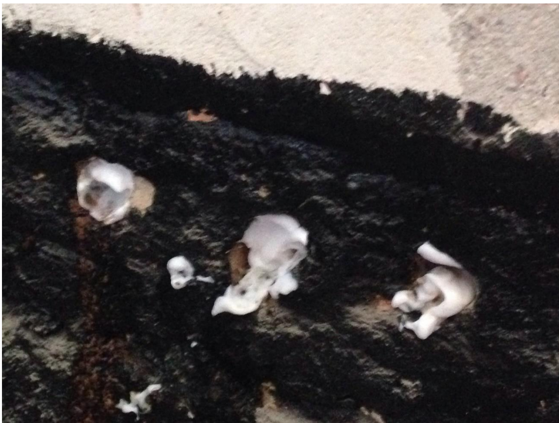
Obr. 13 Detail zainjektovaného vrtu (autor Jan Illetško)
