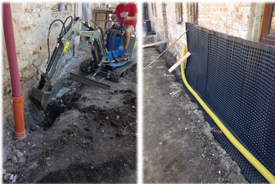
Obr. 15 a Obr. 16 Odkopání objektu a kladení nopové fólie a drenážní trubky (autor Jan Illetško)
