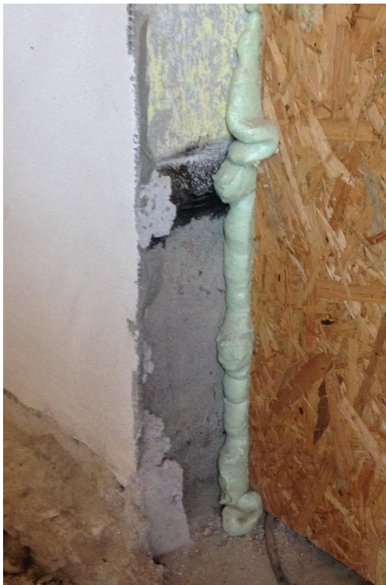
Obr. 14 Detail nově provedené vnitřní omítky (autor Jan Illetško)
