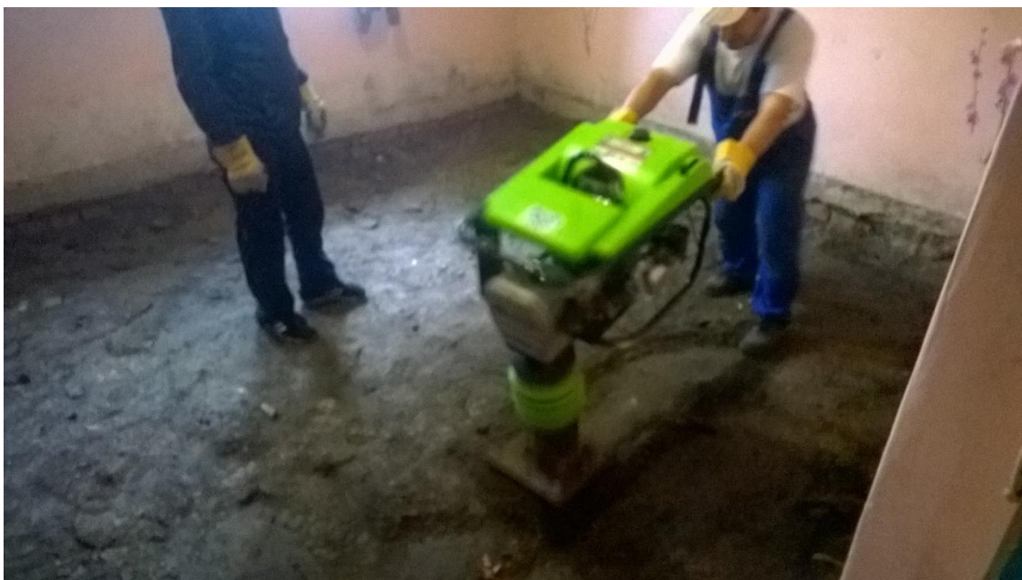
Obr. 6 Hutnění zeminy před provedením podkladního betonu (převzato od Ing. Jan Klatovec)
