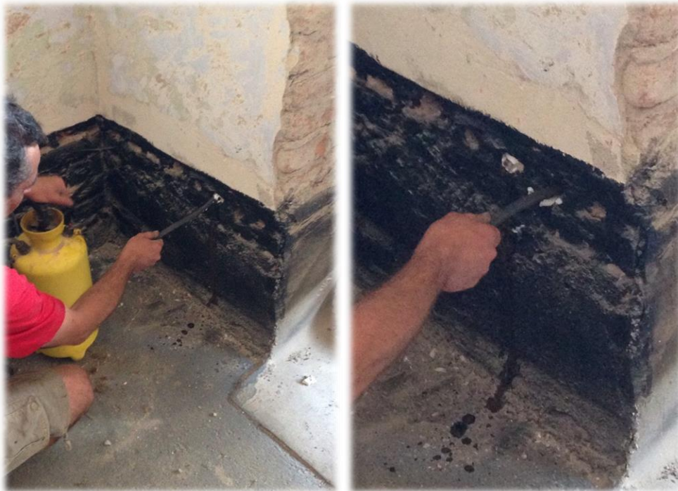
Obr. 11 a Obr. 12 Aplikace injektážního krému do injektážních vrtů (autor Jan Illetško)
