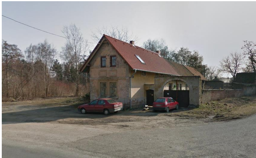
Obr. 1 foto objektu (převzato z 14)
