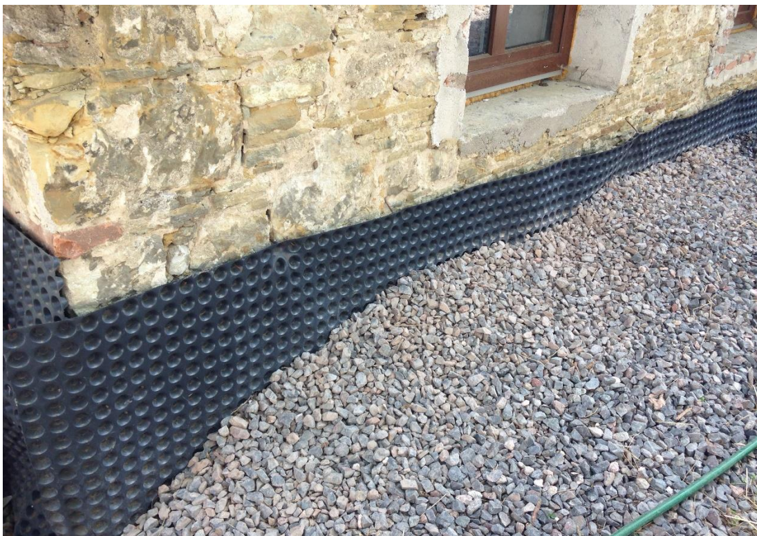
Obr. 17 Zásyp drenážního systému štěrkem (autor Jan Illetško)
