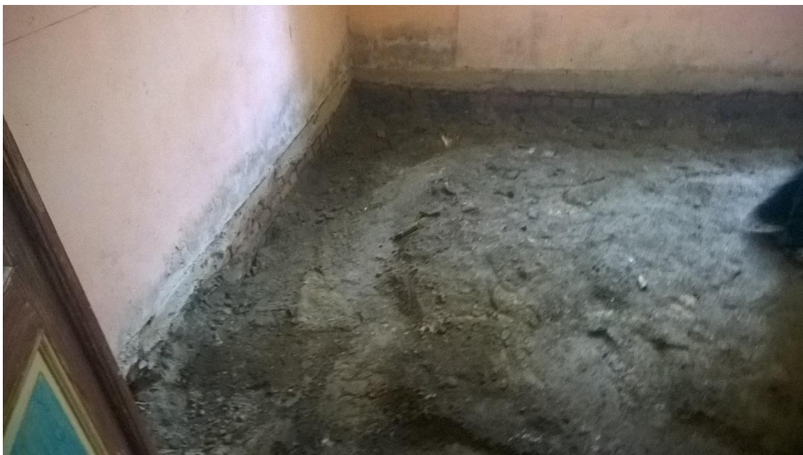
Obr. 5 Nezhuťněná podkladní zemina (převzato od Ing. Jan Klatovec)
