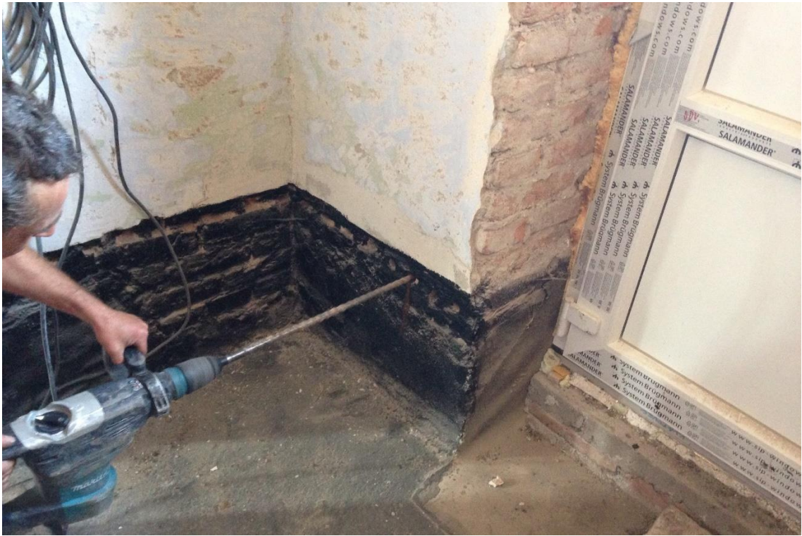
Obr. 10 Provedení injektážních vrtů (autor Jan Illetško)
