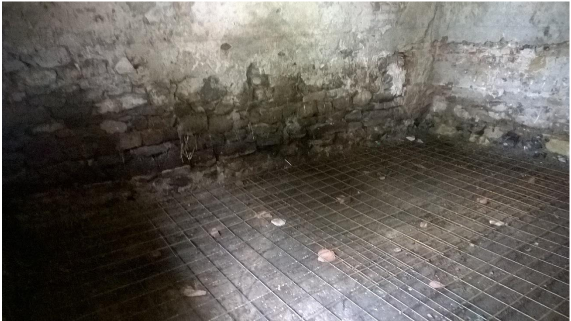
Obr. 7 Pokládka kari sítí (převzato Ing. Jan Klatovec)
