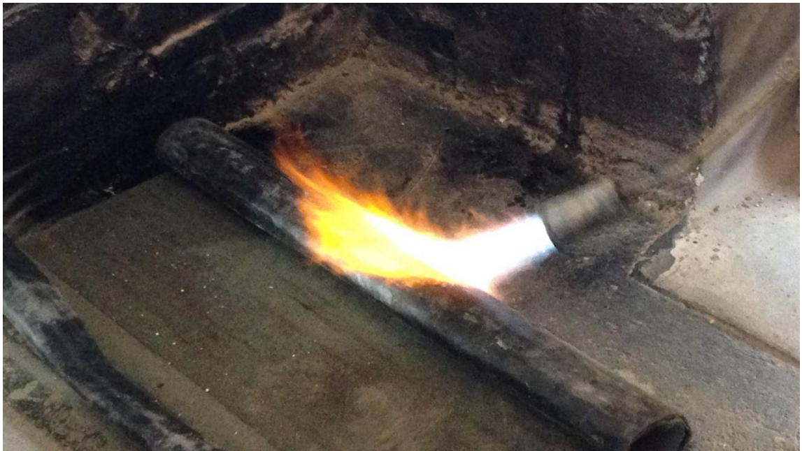
Obr. 8 Natavení hydroizolačních asfaltových pásů (autor Jan Illetško)
