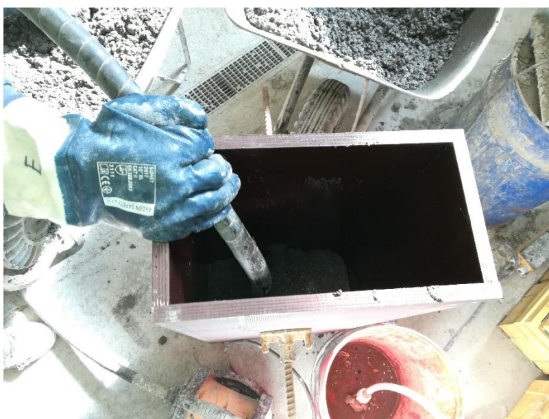
17 Ukládání betonu pro výrobu referenční plochy [Ondřej Boroš]
