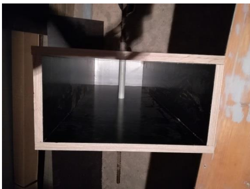
10 Pohled do bednění - spínací tyč [Ondřej Boroš]
