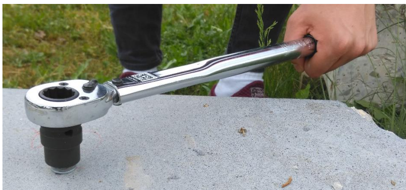
Obrázek 30 Utahování momentovým klíčem
