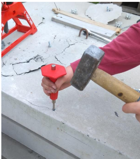
Obrázek 32 Aktivace pomocí osazovacího nástroje HSD-G M10 3/8 X30 a kladiva
