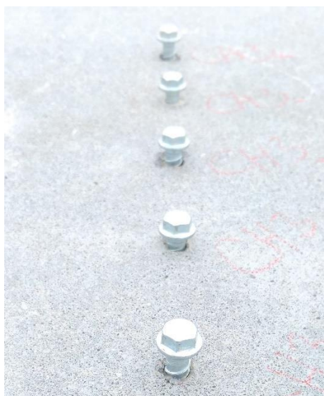
Obrázek 43 Nedodržení min. osových vzdáleností mezi šrouby HUS3-H M10x90
