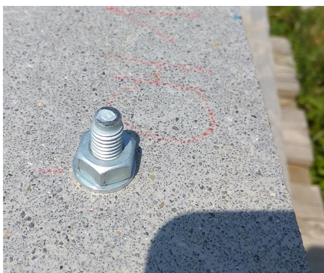
Obrázek 36 Expanzní kotva HST3 M10x100 příliš blízko od kraje podkladního materiálu
