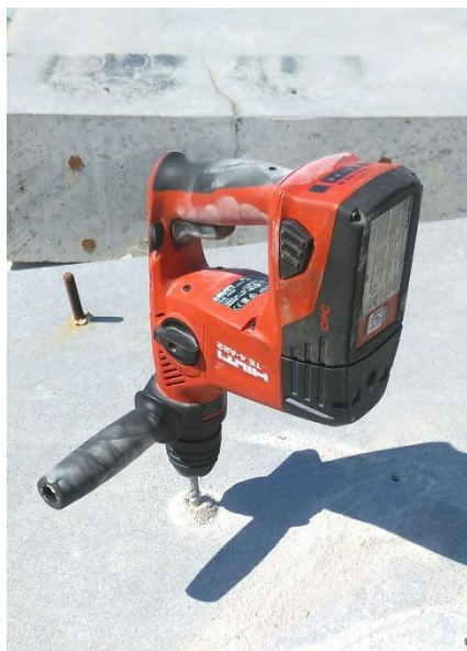
Obrázek 27 Vrtání otvoru pomocí akumulátorového vrtacího kladiva TE - 4 A22
