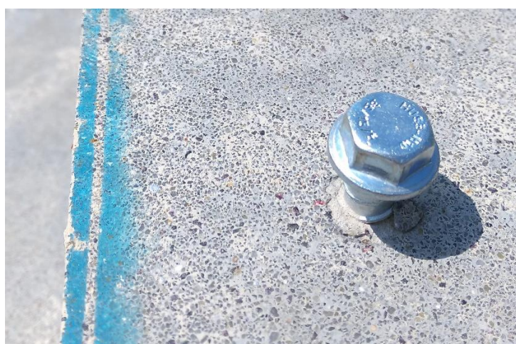
Obrázek 37 Upevňovací kotevní šroub HUS3-H M10x90 příliš blízko od kraje podkladního materiálu
