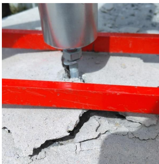
Obrázek 60 Poškození podkladního materiálu vlivem vytažení expanzní kotvy HST3 M10x100
