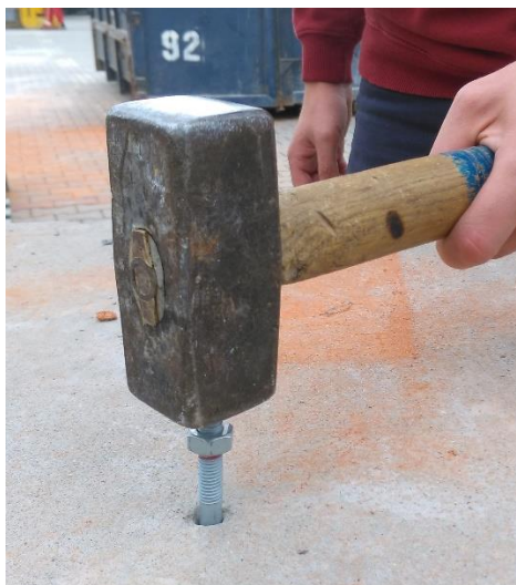
Obrázek 29 Osazení kotvy pomocí kladiva
