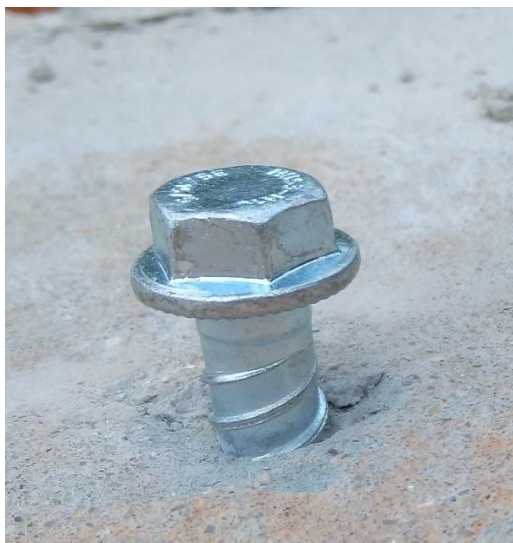
Obrázek 44 Nedodržení minimální kotevní hloubky HUS3-H M10x90
