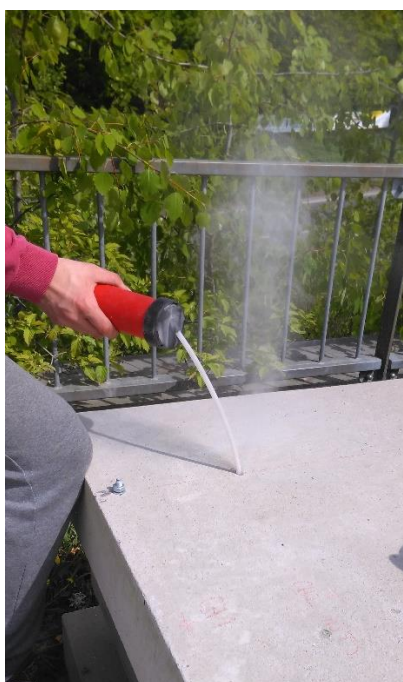
Obrázek 28 Čištění otvoru pomocí vzduchové pumpičky
