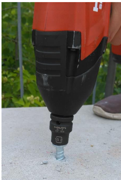
Obrázek 34 Utahování pomocí rázového utahováku
