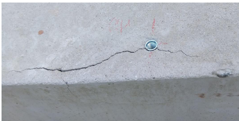
Obrázek 39 Chybně zrealizovaná úderová kotva HKD
