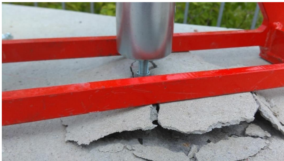
Obrázek 50 Úderová kotva HKD s vytrženým betonovým kuželem
