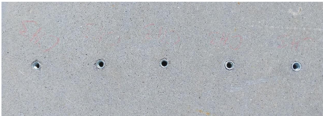
Obrázek 42 Nedodržení min. osových vzdáleností mezi kotvami HKD
