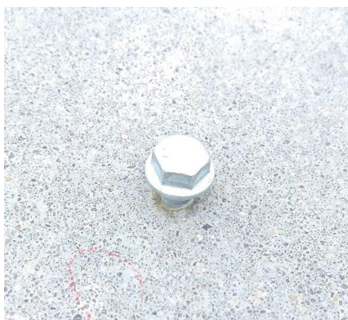
Obrázek 35 Hotový upevňovací kotevní šroub HUS3-H
