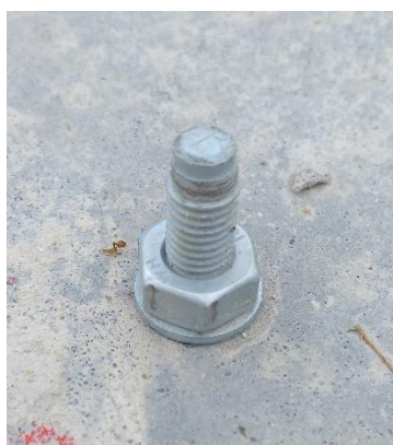
Obrázek 31 Hotová expanzní kotva HST3
