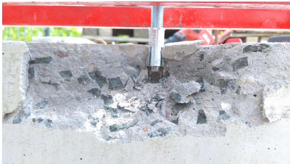
Obrázek 56 Poškození podkladního materiálu při vytažení kotvy
