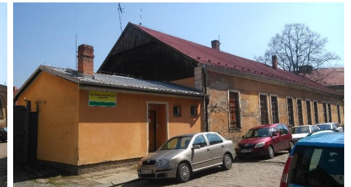
Obr. 30 Areál vojenské jízdárny spadající pod správu Armády ČR.
