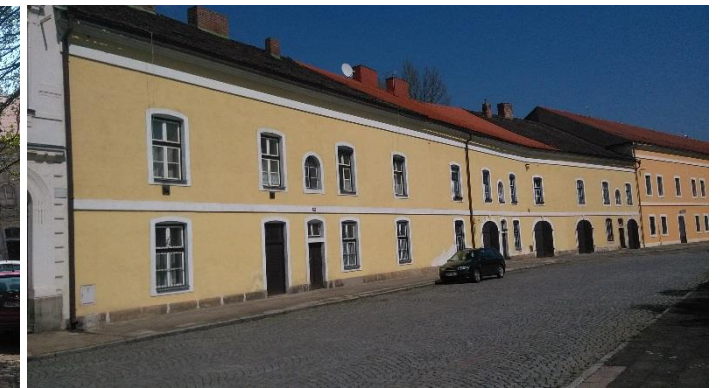
Obr. 29 Nově opravený objekt pracoviště památkového ústavu
