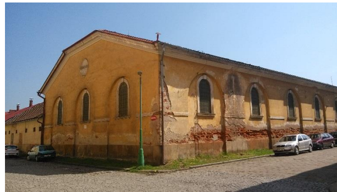
Obr. 27 Objekt bývalé jízdárny
