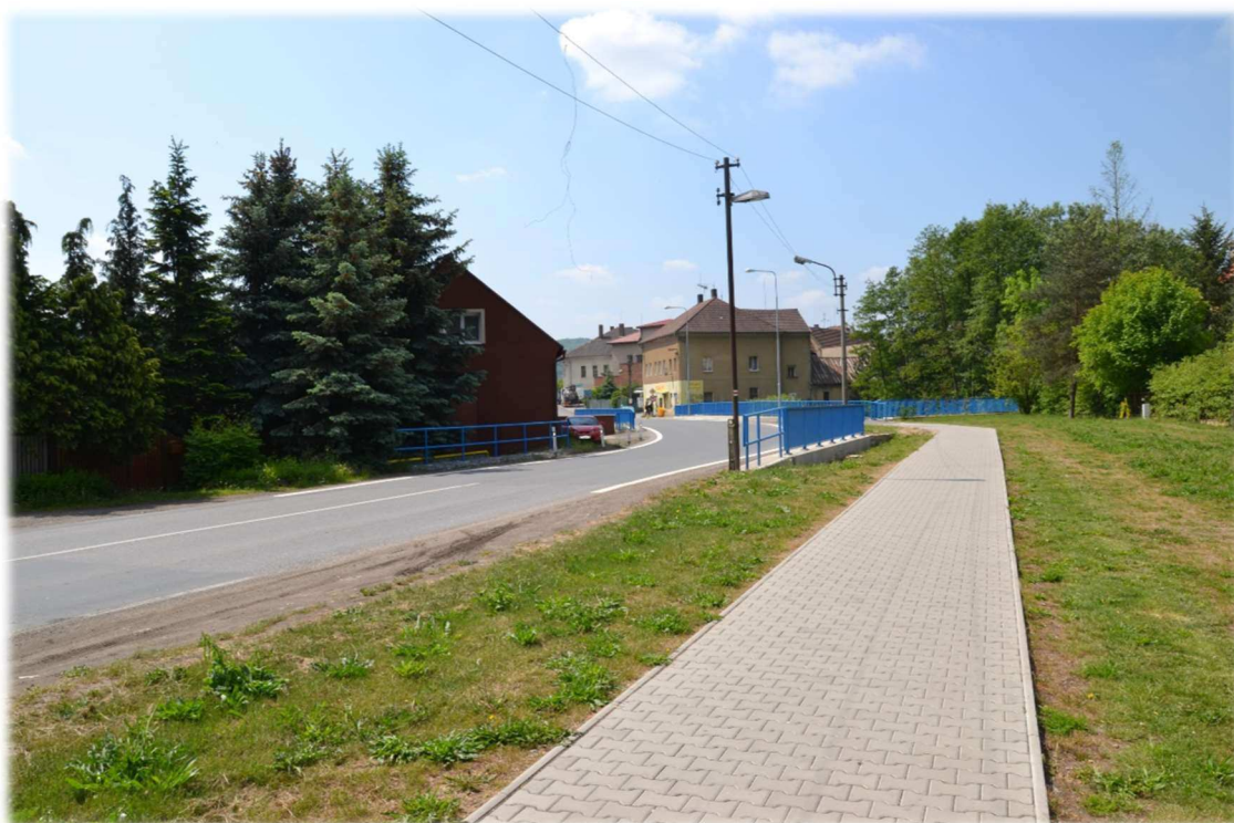
Obrázek 17 – Pohled na stávající most (rekonstruovaný v roce 2016) od křižovatky ulic Tovární a Pražské
