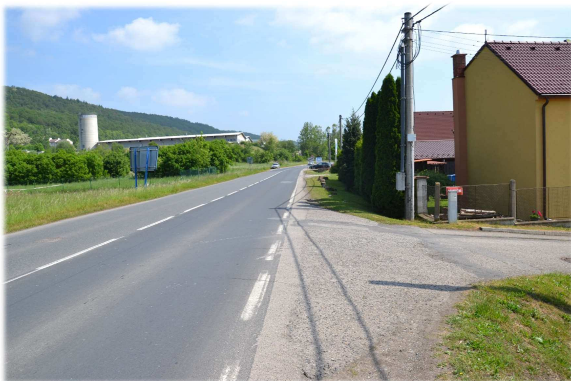
Obrázek 30 – Pohled na výjezd z obce z ulice Pražské v místě křižovatky s ulicí Dálniční
