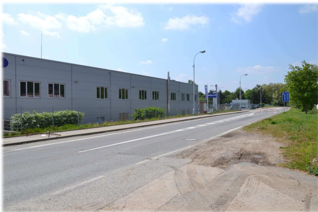
Obrázek 2 – Ulice Plzeňská před areálem společnosti Volvo z ulice k zámku
