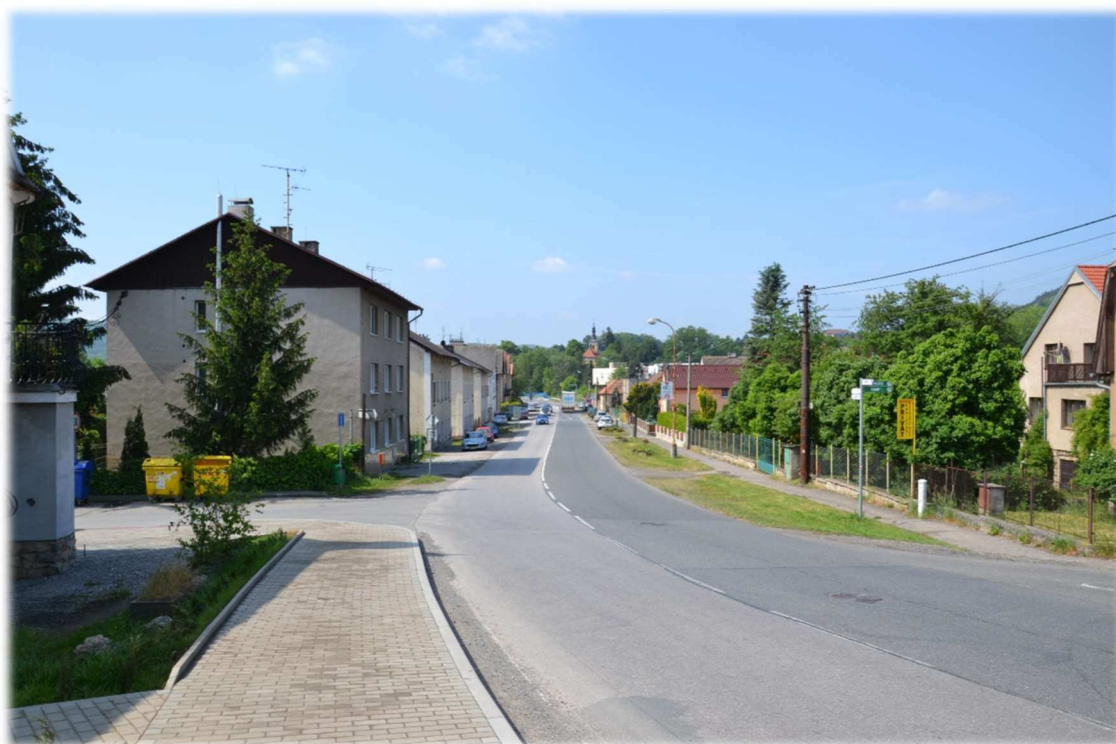
Obrázek 22 – Celkový pohled na ulici Pražskou v úseku mezi ulicemi Tovární a Žižkova
