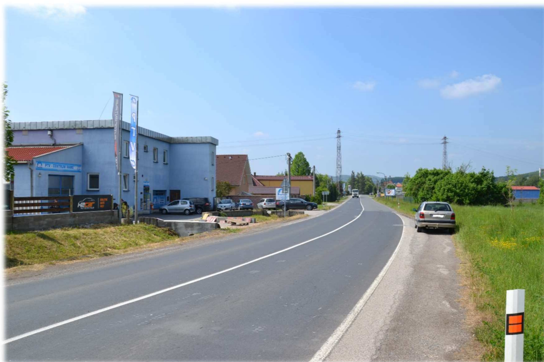
Obrázek 31 – Vjezd do obce Loděnice ze severovýchodu
