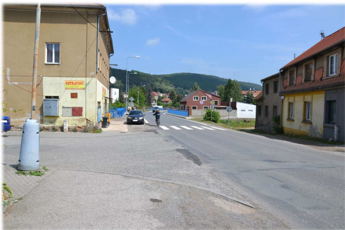
Obrázek 16 – Stávající most (rekonstruovaný v roce 2016) od křižovatky ulic Havlíčkova a Pražské
