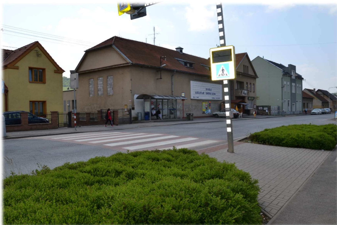
Obrázek 6 – Problematické místo v ulici Plzeňské (autobusová zastávka, vjezd a přechod pro pěší)
