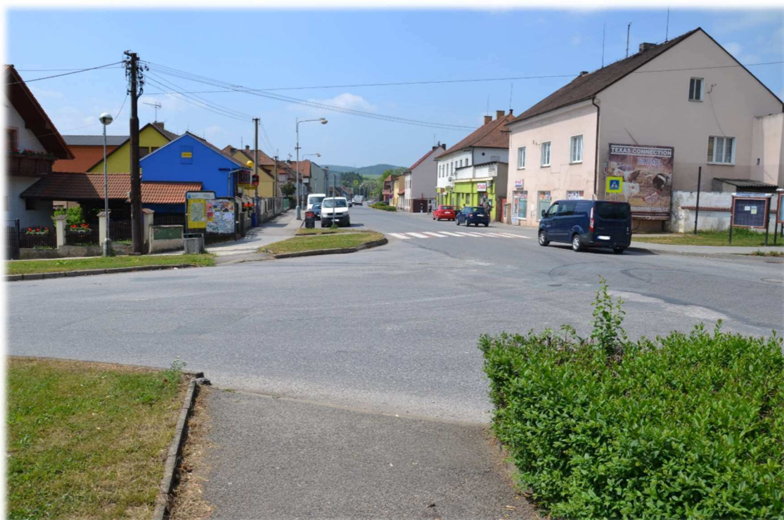
Obrázek 9 – Křižovatka silnice II/605 a III/11612 (chybějící přechod pro chodce)
