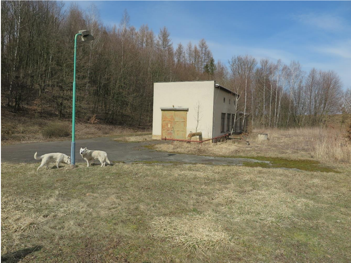
Obrázek 8.1: Pohled na budovu s čerpací stanicí
