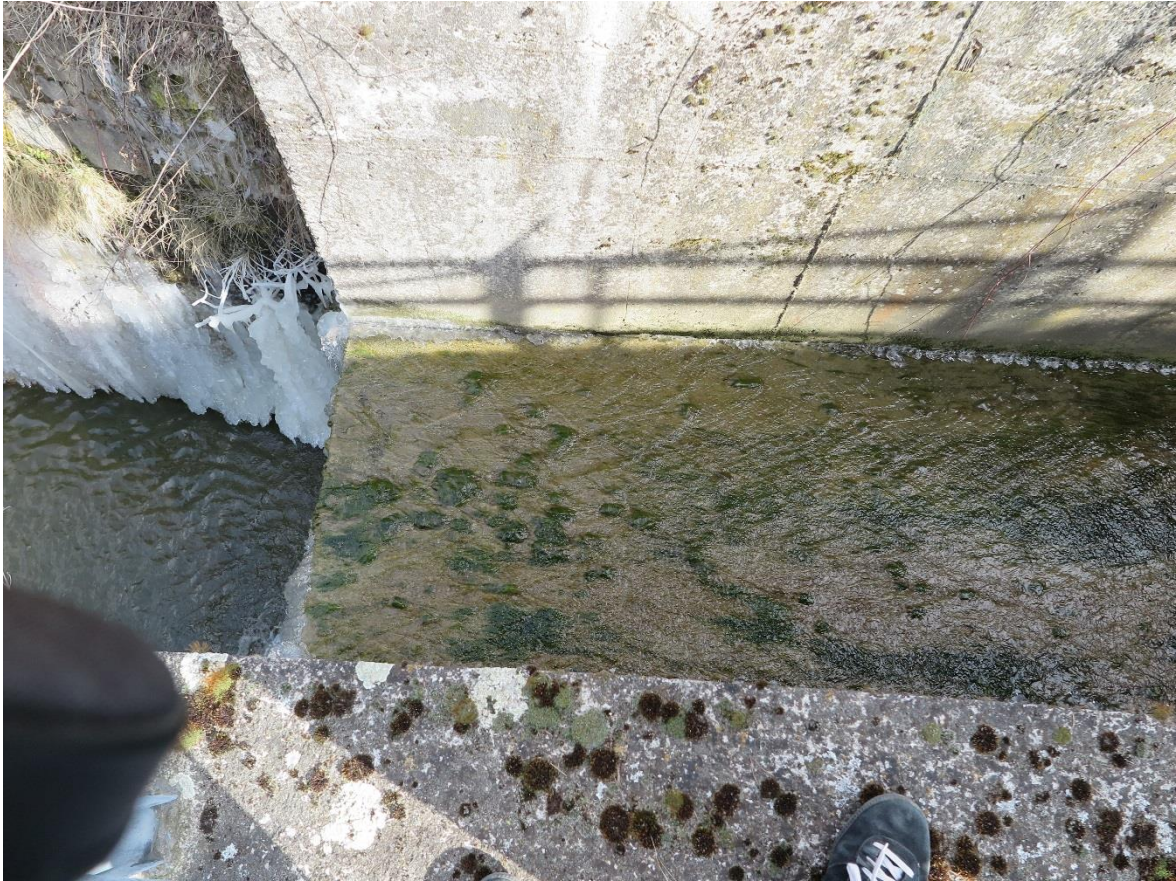
Obrázek 3.4: Pohled na přepad vody na konci horní štoly
