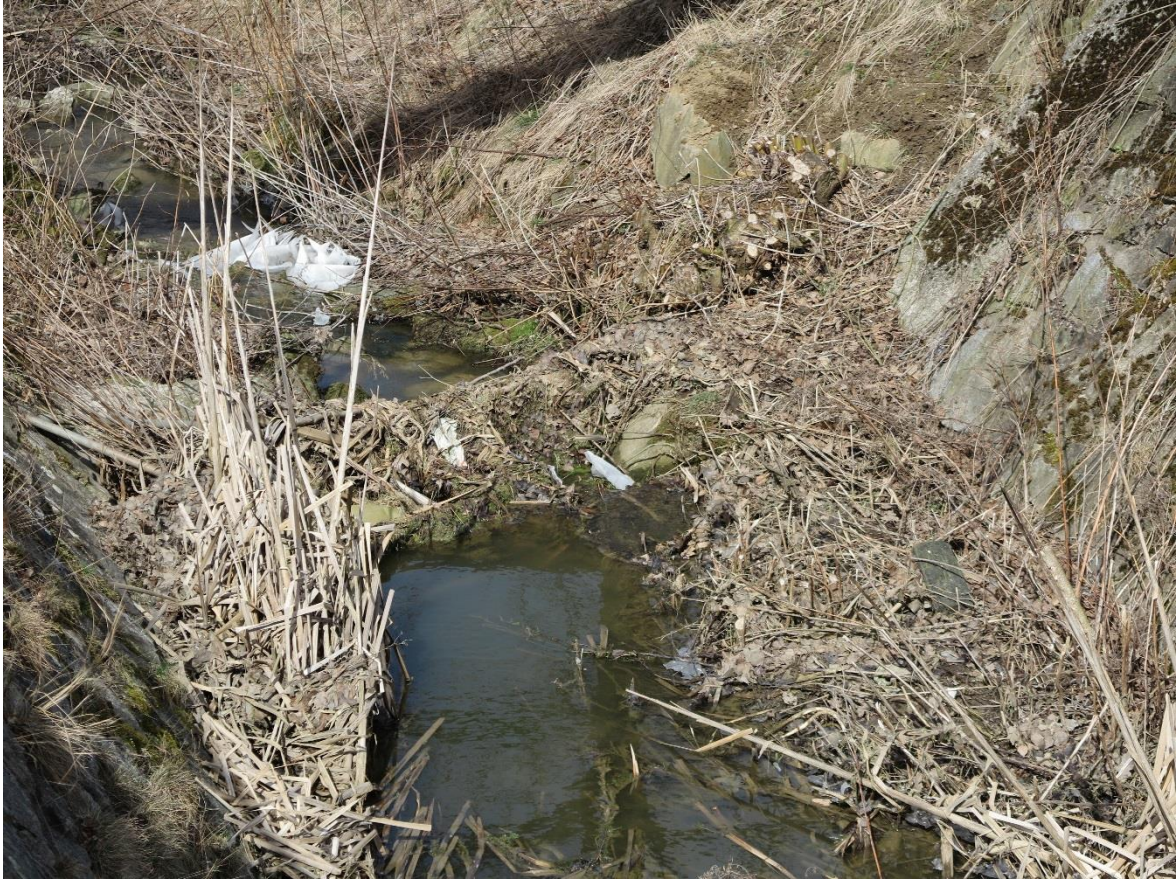
Obrázek 4.4.7: Pohled na zpevněné koryto
