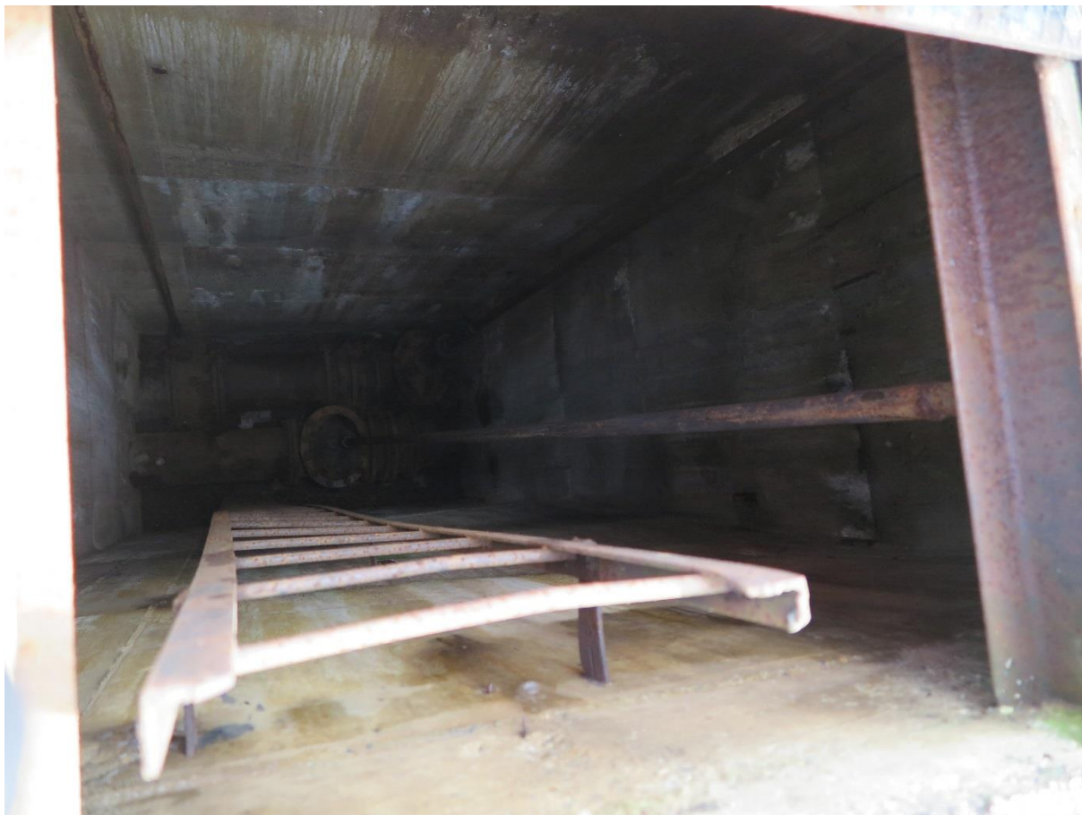
Obrázek 4.4.5: Pohled do šachty
