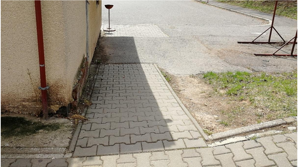
Obrázek 16 - Bezbariérový přístup na levé straně odbavovací budovy (zdroj: foto autor)
