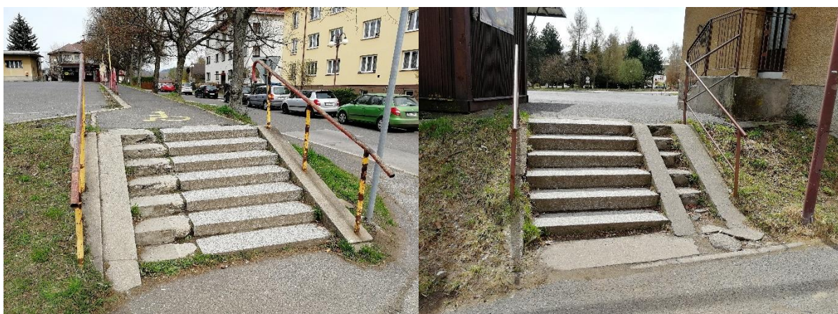
Obrázek 15 – Přístupová schodiště, vlevo bez rampy pro kočárky z ulice Žižkova, vpravo s rampou vpravo od odbavovací budovy (zdroj: foto autor)
