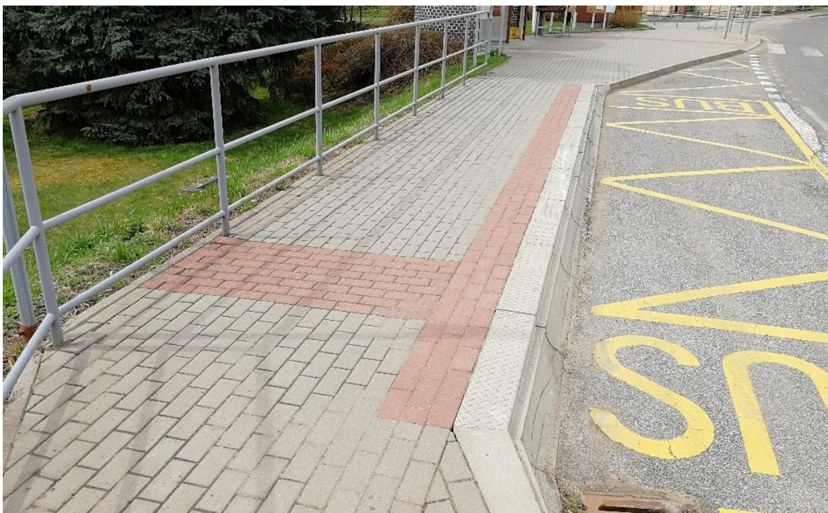
Obrázek 4 – Kasselský obrubník – Radostná pod Kozákovem, Lestkov (zdroj: foto autor)
