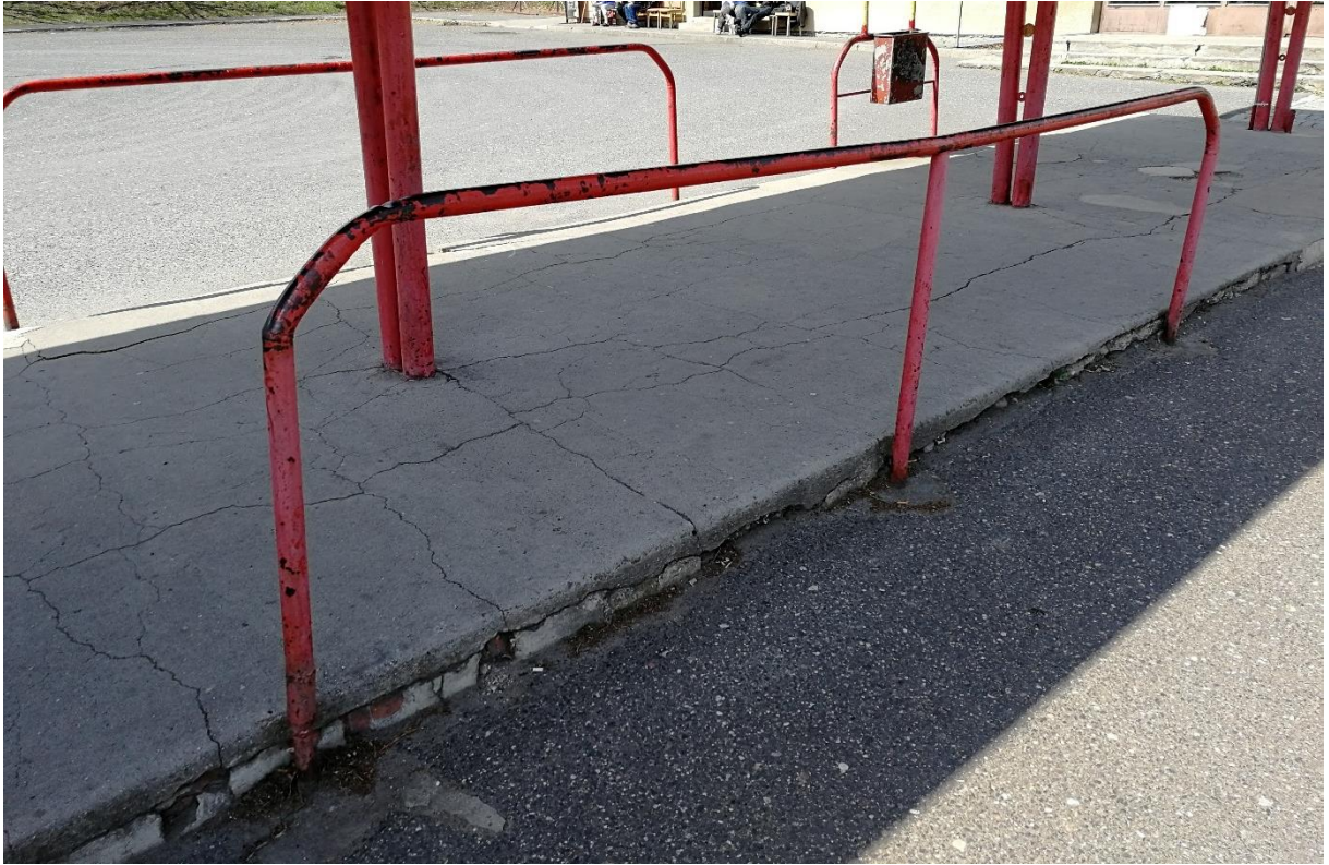
Obrázek 18 – Zábradlí u nástupišť (zdroj: foto autor)
