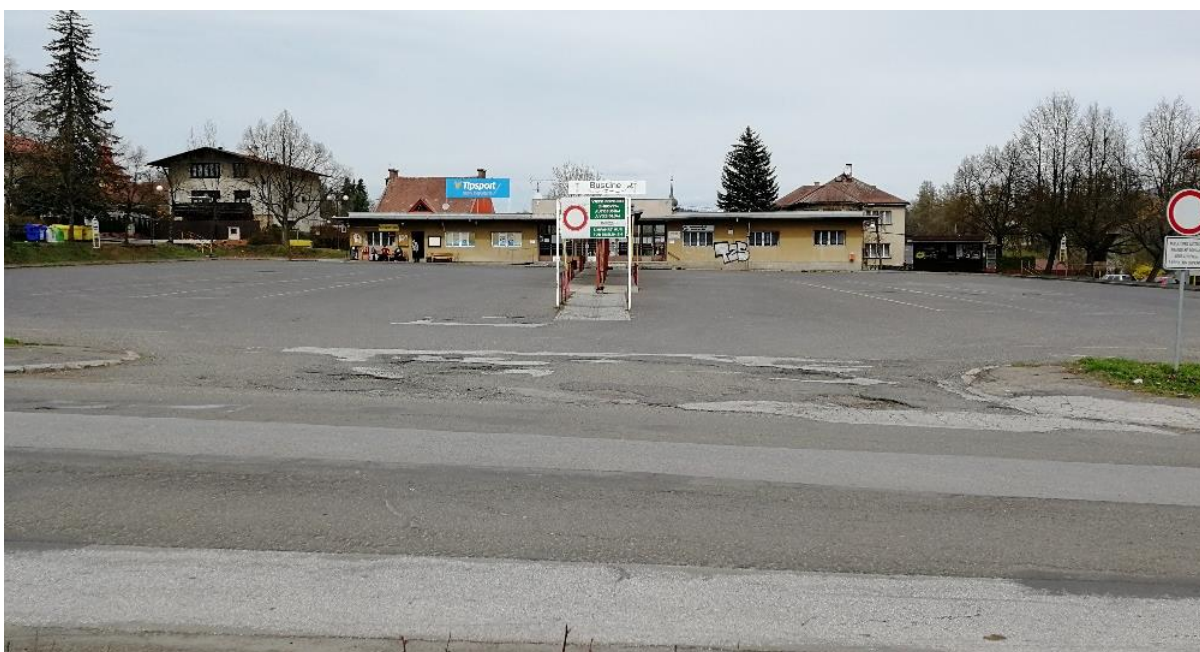
Obrázek 13 – Autobusové nádraží Jilemnice z Žižkovy ulice (zdroj: foto autor)
