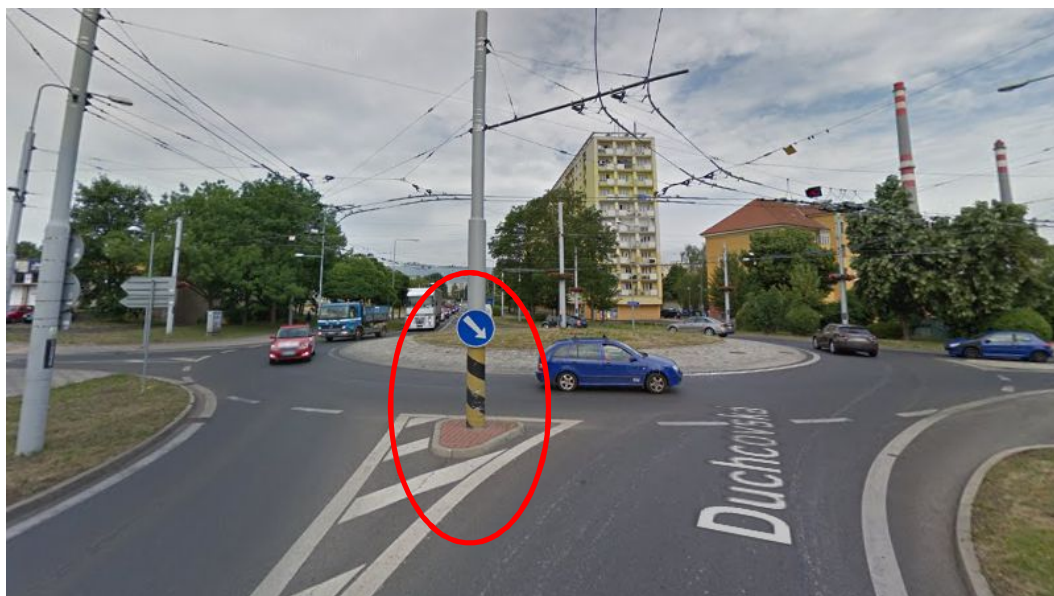
Obrázek 30 - Nevhodně umístěný sloup trakčního vedení (zdroj: maps.google.com, upravil: autor)
