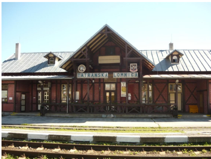
Obrázok 56 - Výpravná budova v žst. Tatranská Lomnica (Zdroj: autor)
