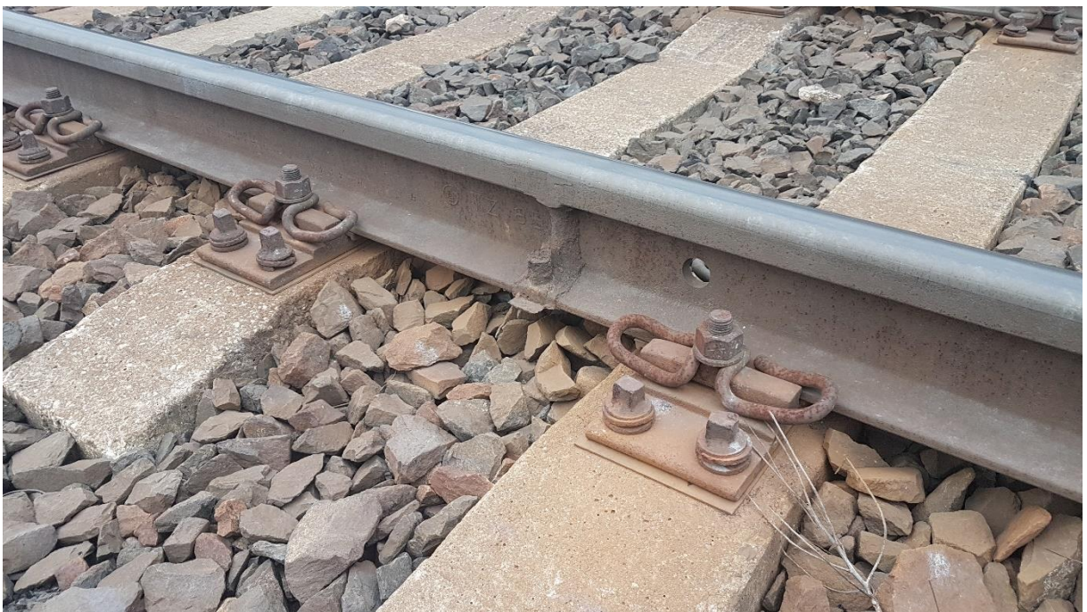
Obrázek č. 32 – km 65,000, kolej č. 1, svar – detail
