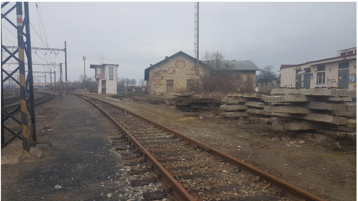
Obrázek č. 10 – km 64,400, směr Most, kolej č. 95
