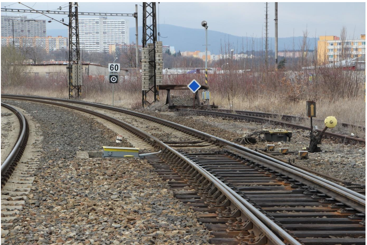
Obrázek č. 4 – km 64,200, směr Most, kolej č. 1
