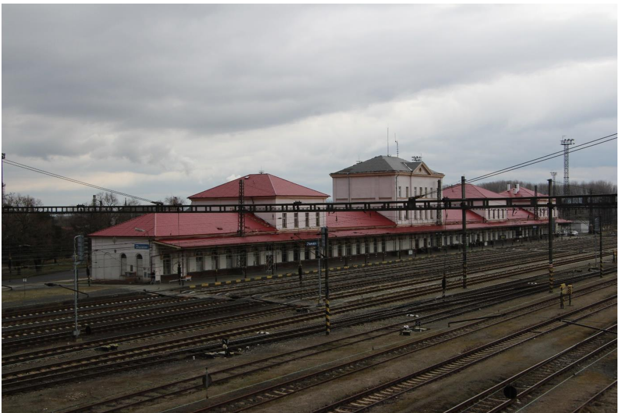
Obrázek č. 16 – pohled z lávky, výpravní budova
