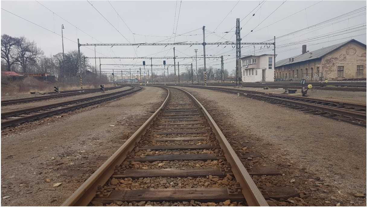
Obrázek č. 9 – km 64,400. směr Most, kolej č. 16
