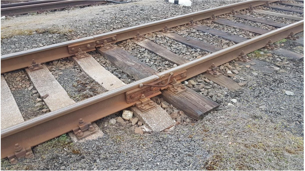
Obrázek č. 39 – km 65,250, kolej č. 5, změna kolejového roštu
