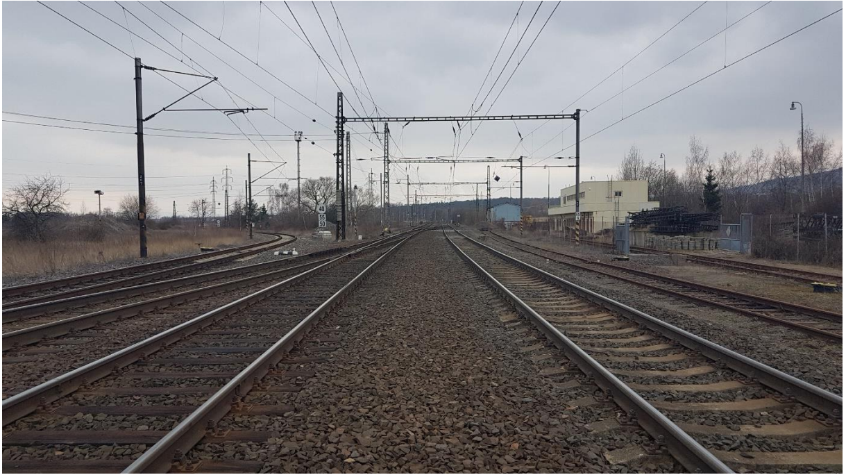
Obrázek č. 53 – km 65,600, směr Kadaň, koleje č. 1 a 2
