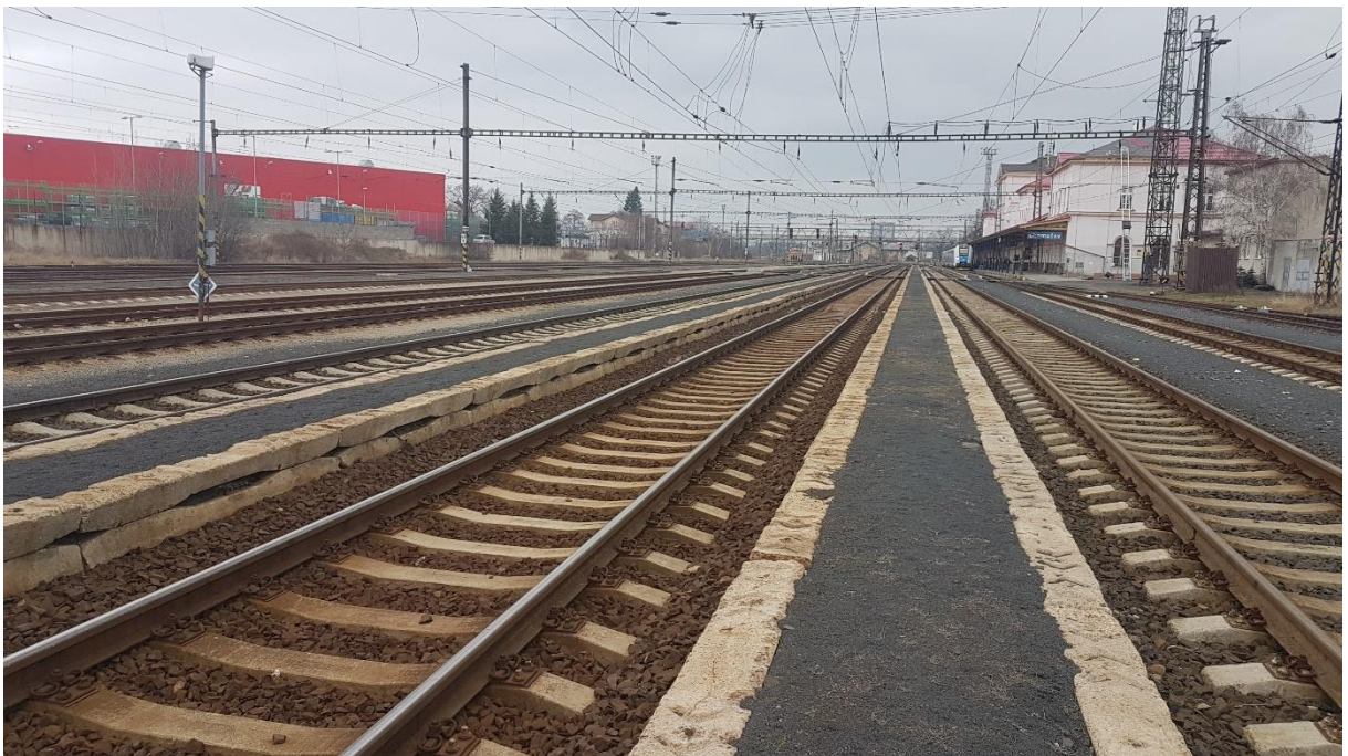
Obrázek č. 28 – km 64,850, směr Most, III. nástupiště
