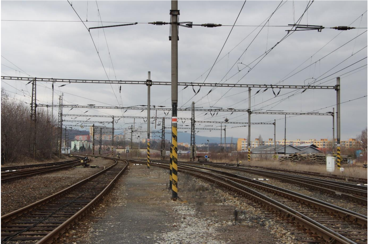
Obrázek č. 5 – km 64,200, směr Most, koleje č. 2 a 4a
