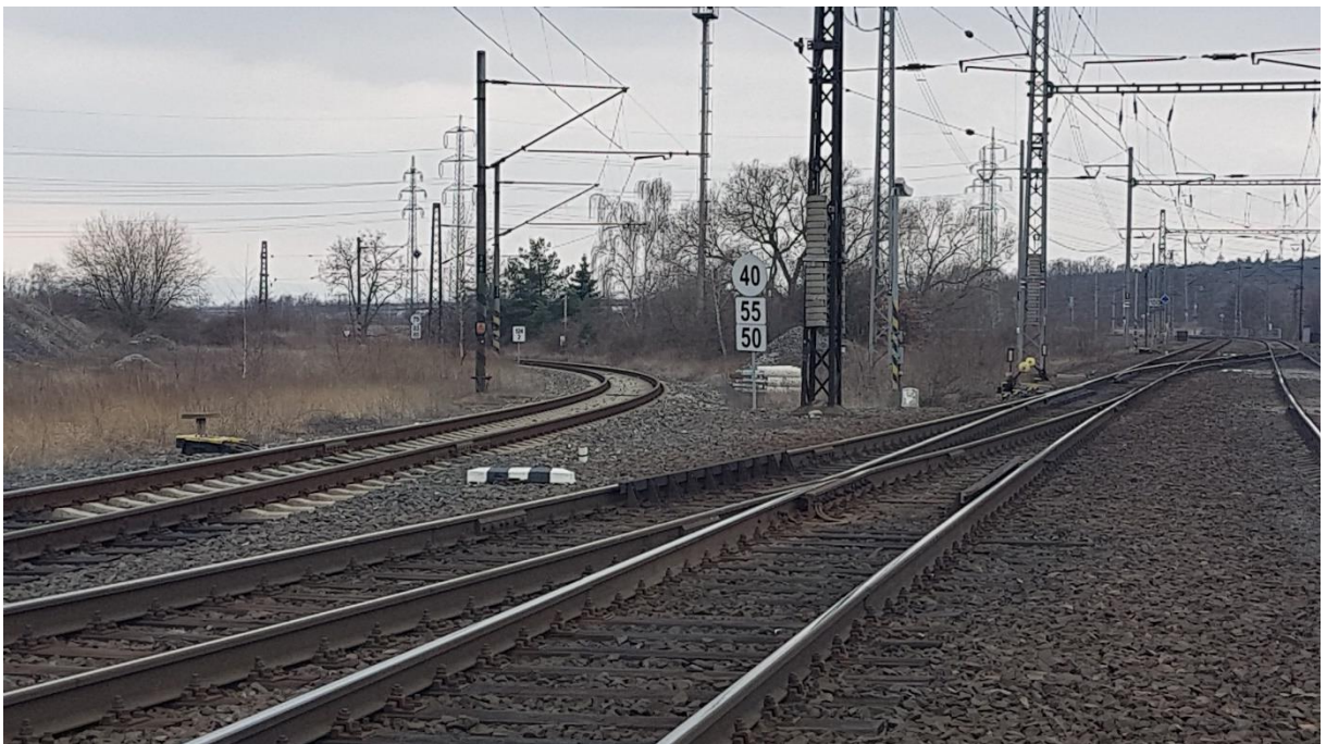
Obrázek č. 50 – km 65,600, směr Kadaň, kolej směr Žatec
