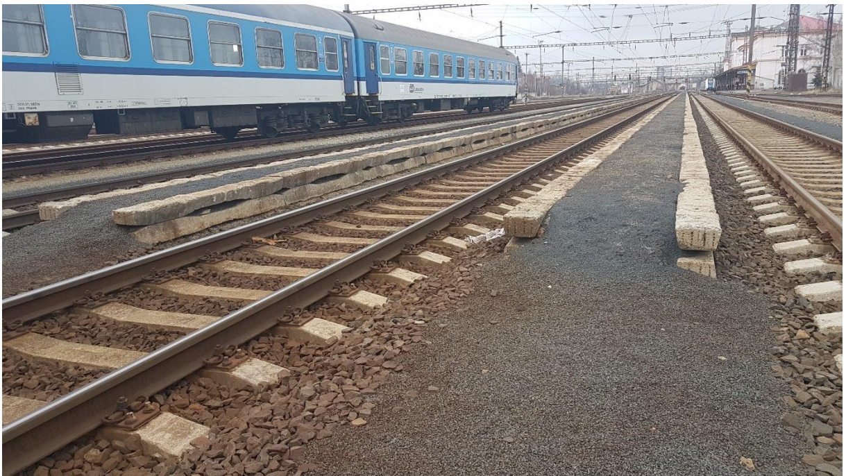
Obrázek č. 30 – km 64,900, směr Most, konec III. a IV. nástupiště
