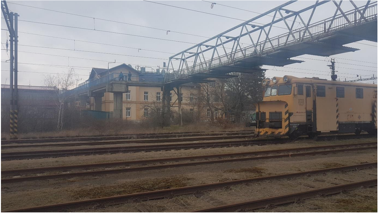
Obrázek č. 19 – km 64,550, pohled na severní část lávky
