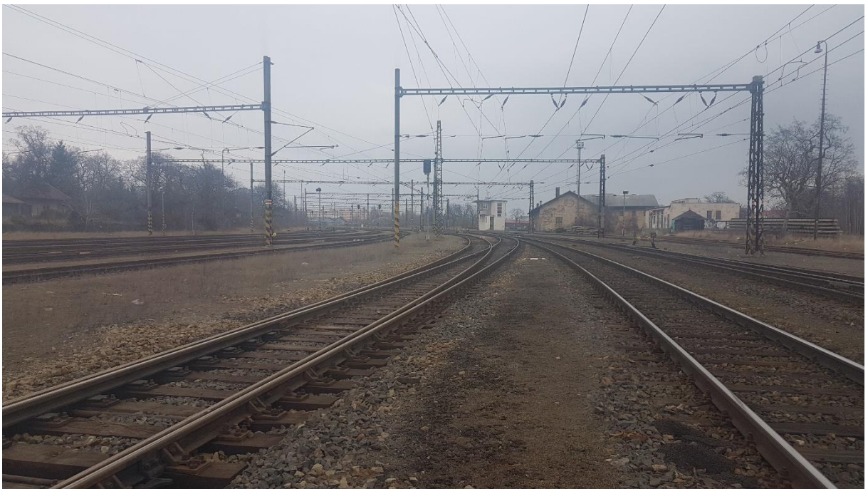
Obrázek č. 12 – km 64,450, směr Most, koleje č. 2 a 4
