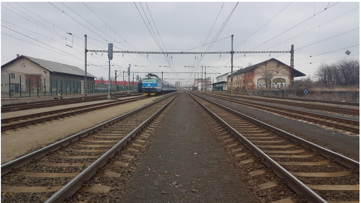
Obrázek č. 36 – km 65,100, směr Most, koleje č. 1 a 2
