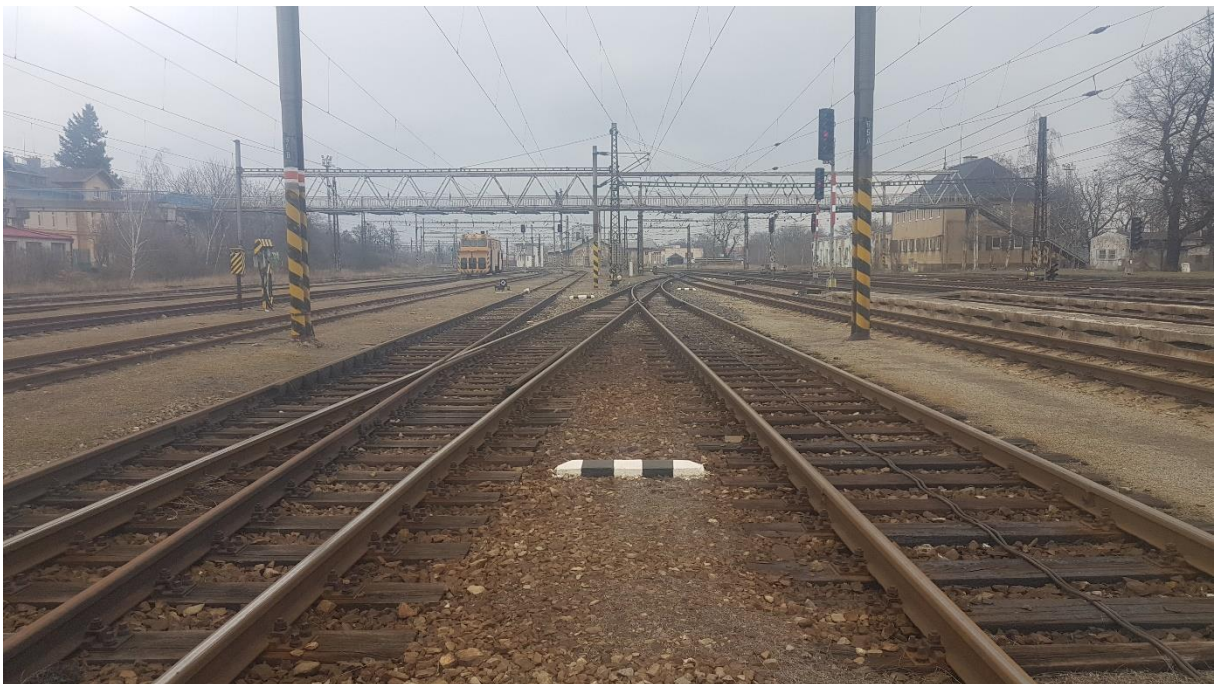
Obrázek č. 22 – km 64,600, směr Most, kolejová spojka mezi kolejemi č. 8 a 10
