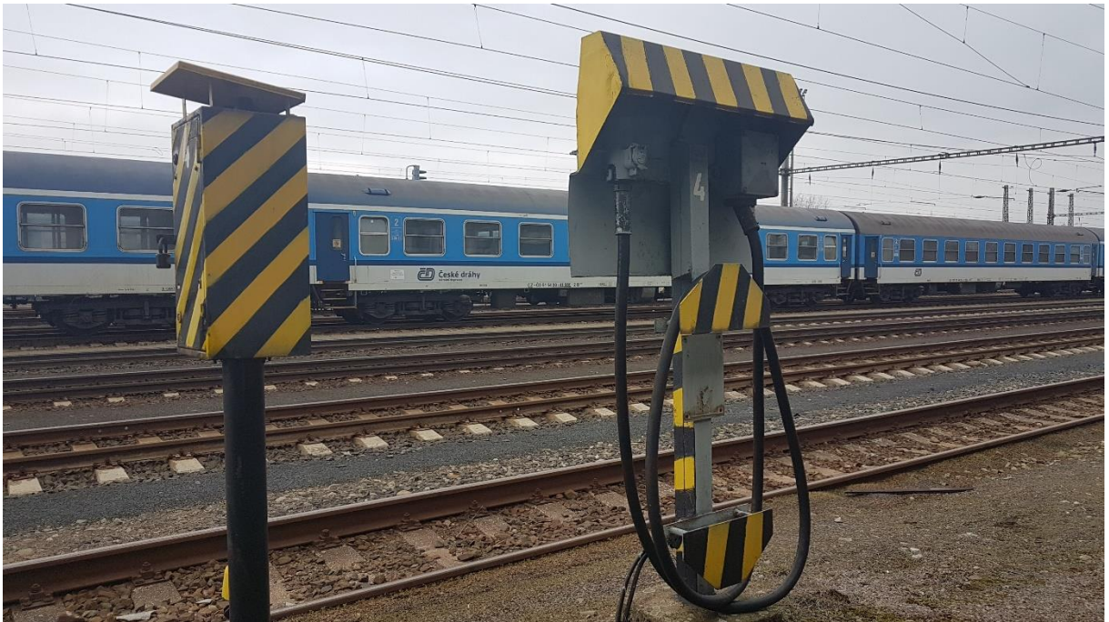
Obrázek č. 31 – km 65,000, předtápěcí stojan
