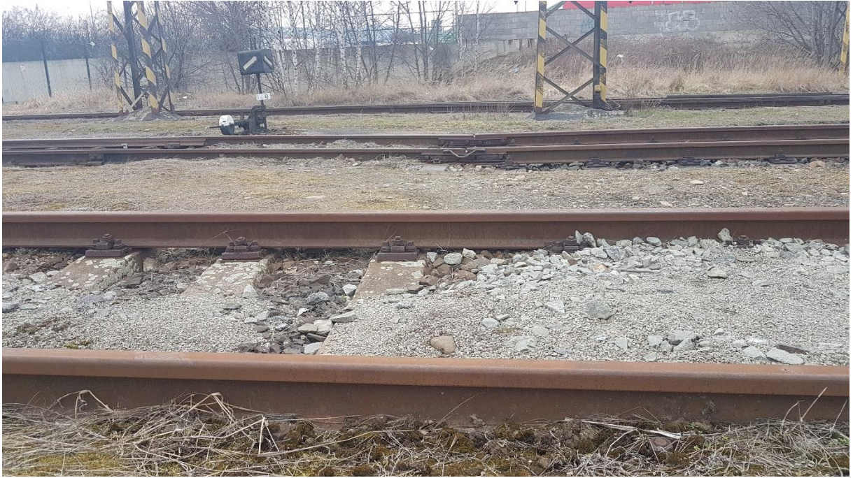
Obrázek č. 25 – km 64,850, kolej č. 10 – detail
