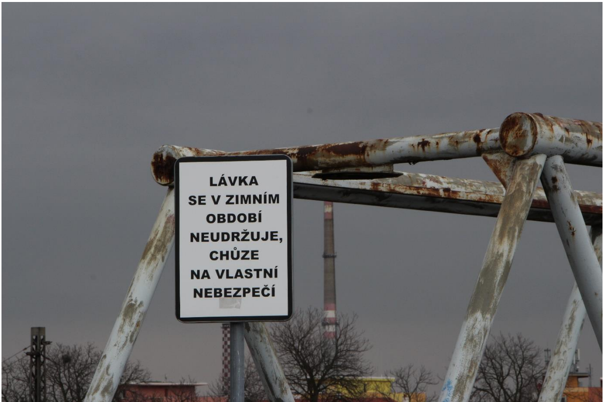
Obrázek č. 17 – varovná tabule při vstupu na lávku
