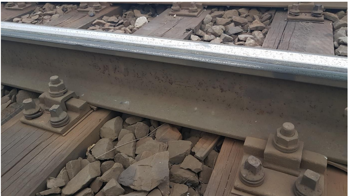
Obrázek č. 46 – km 65,500, kolejnice R65 – detail
