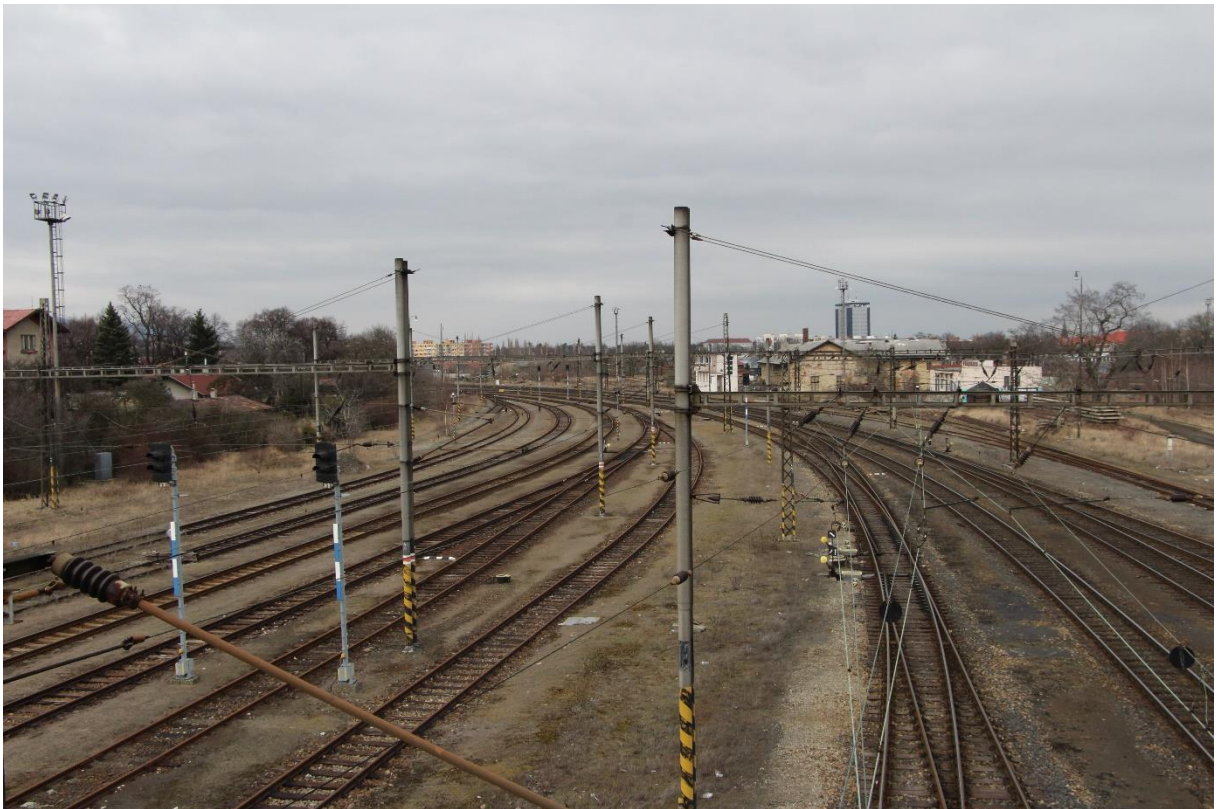
Obrázek č. 14 – pohled z lávky, směr Most
