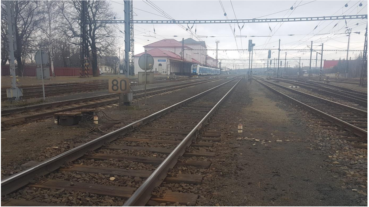
Obrázek č. 13 – km 64,550, směr Kadaň, kolej č. 2
