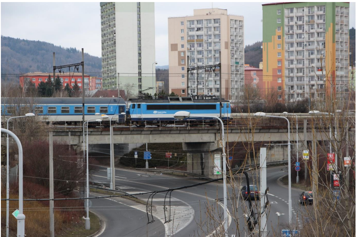
Obrázek č. 56 –km 63,750, most přes silnici I/13
