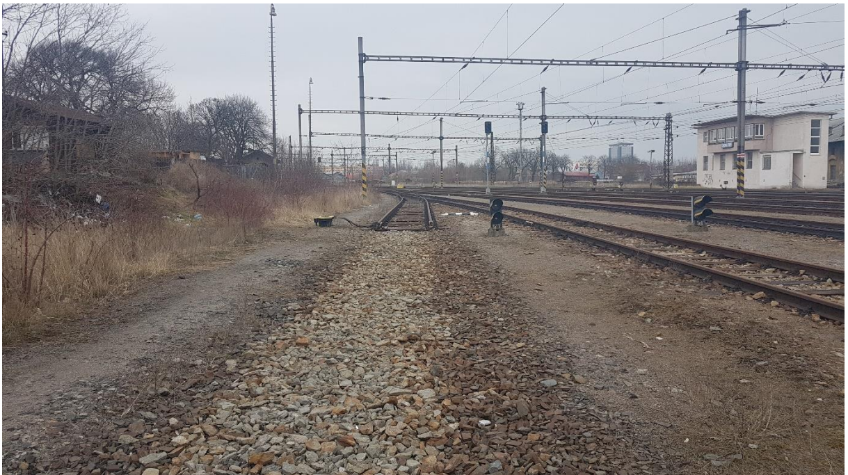
Obrázek č. 6 – km 64,250, směr Most, kolej č. 24
