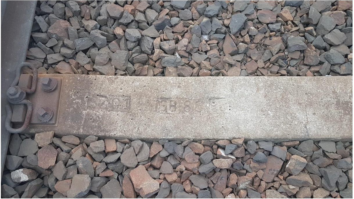
Obrázek č. 33 – km 65,000, kolej č. 1, betonový pražec – detail
