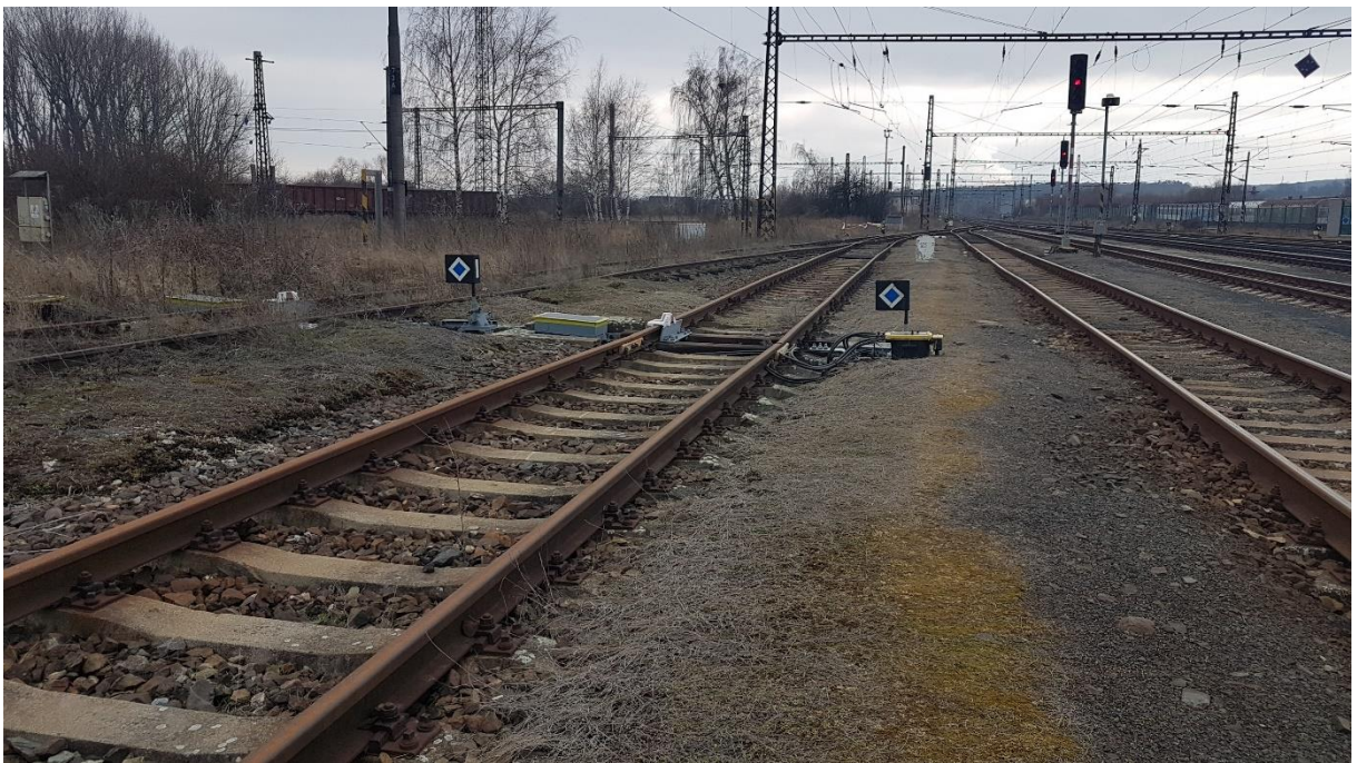
Obrázek č. 38 – km 65,200, směr Kadaň, kolej 7
