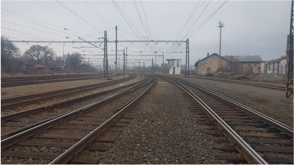
Obrázek č. 11 – km 64,400, směr Most, koleje č. 1 a 2
