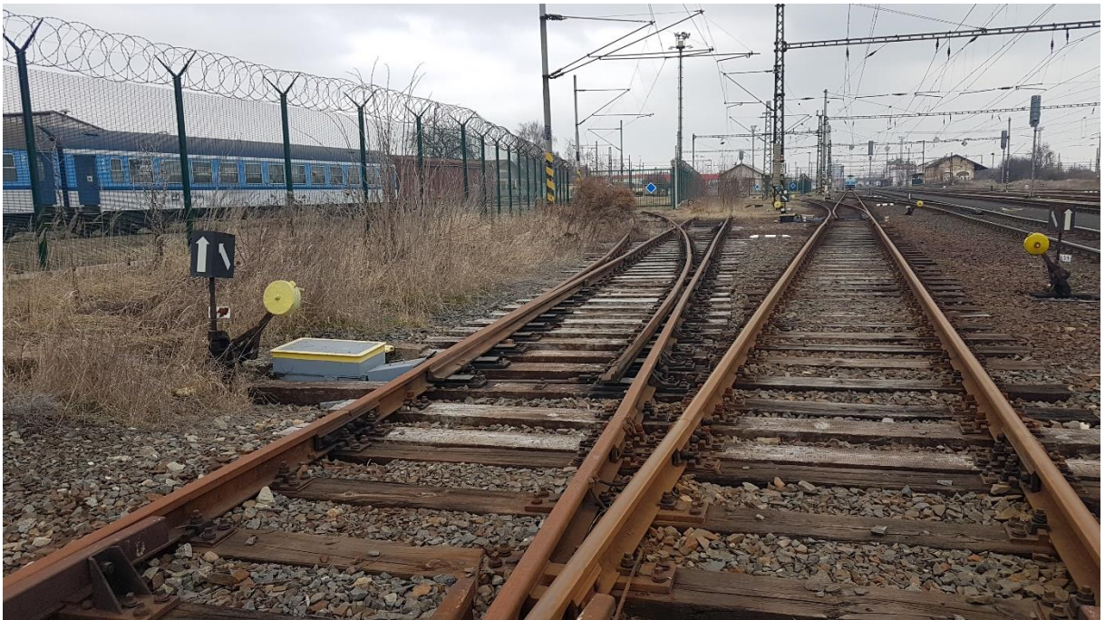
Obrázek č. 42 – km 65,350, směr Most, výhybka č. 60
