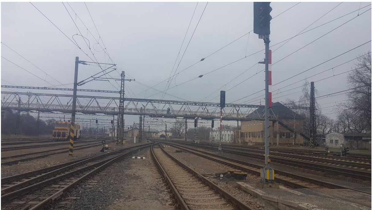
Obrázek č. 20 – km 64,550, směr Most, pohled na lávku
