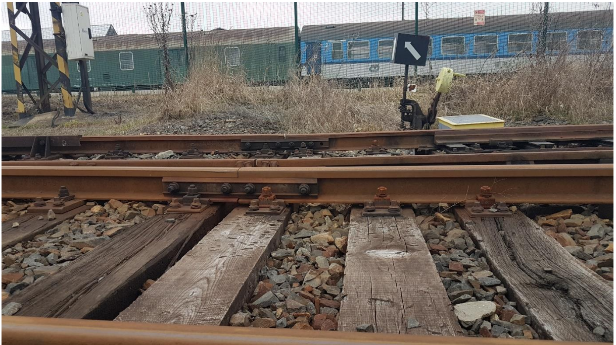
Obrázek č. 43 – km 65,350, výhybka č. 60 – detail
