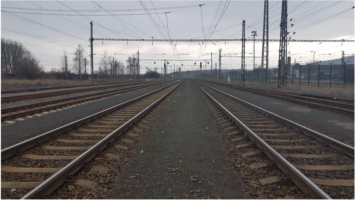
Obrázek č. 37 – km 65,200, směr Kadaň, koleje č. 1 a 2
