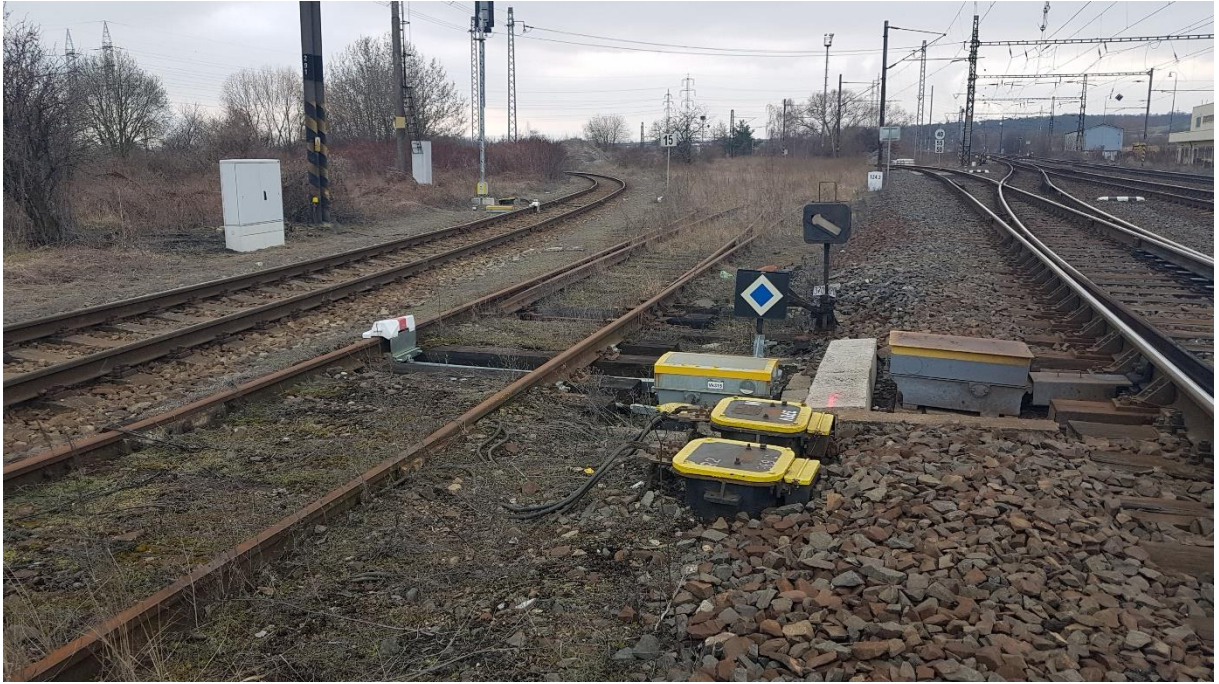
Obrázek č. 49 – km 65,550, směr Kadaň, Průmyslová kolej
