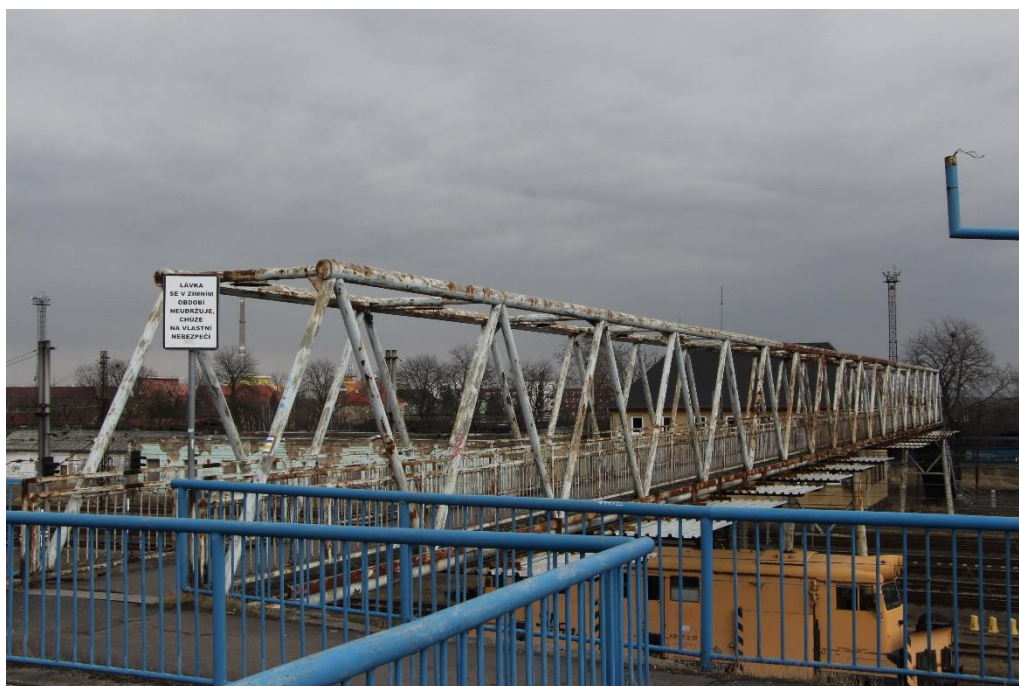
Obrázek č. 4 – lávka v žst. Chomutov
