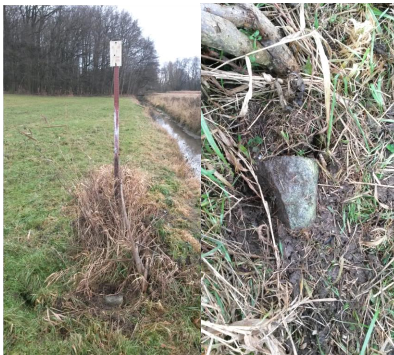
Obr. 3.3 Poškozený bod 227.1(2301) a detail
