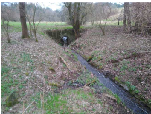
Obr. 2.4 Propust s betonovými čely, potrubí DN 1000 beton
