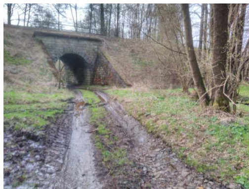
Obr. 2.7 Brod, železniční viadukt
