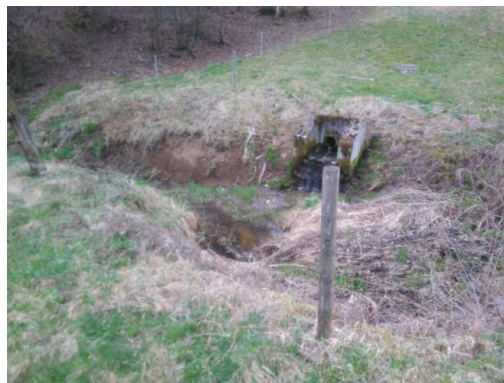
Obr. 2.3 Výústní objekt, potrubí DN 300 beton
