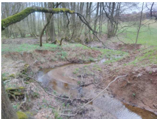
Obr. 2.6 Erozi poničené břehy u soutoku
