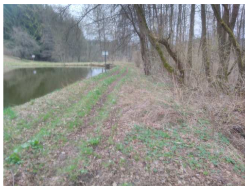
Obr. 2.5 Vodní nádrž parc. č. 292/4
