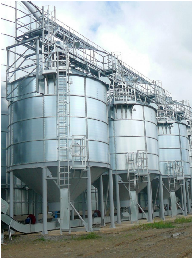
Obrázek 5 Silo s výsypkou
