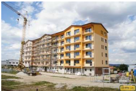
Obrázek 2: Výstavba bytového domu, VM
