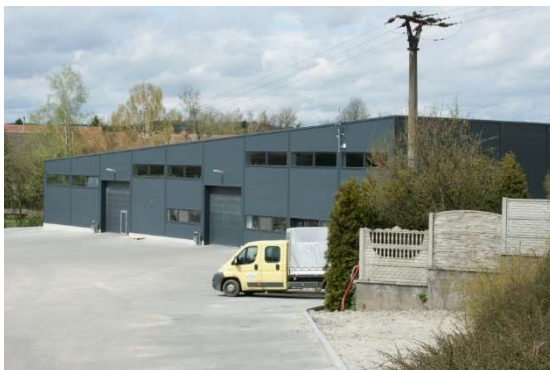
Obrázek 5: Sklad stavebnin Křižanov
